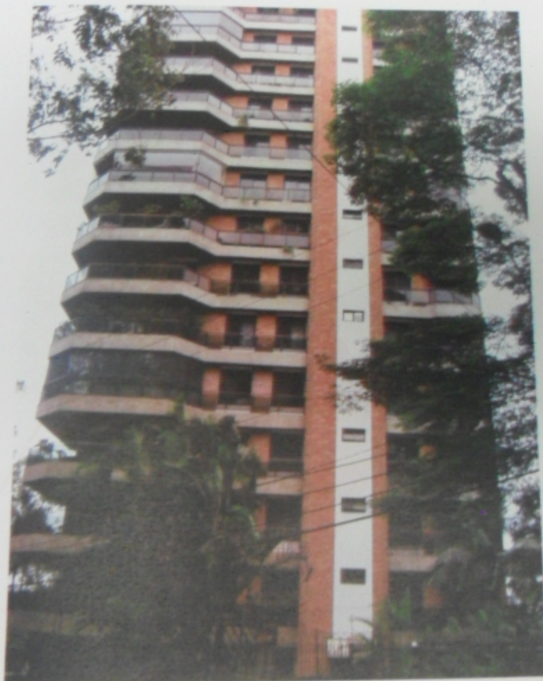
FOTO 5: FACHADA DO EDIFÍCIO EM QUESTÃO.
