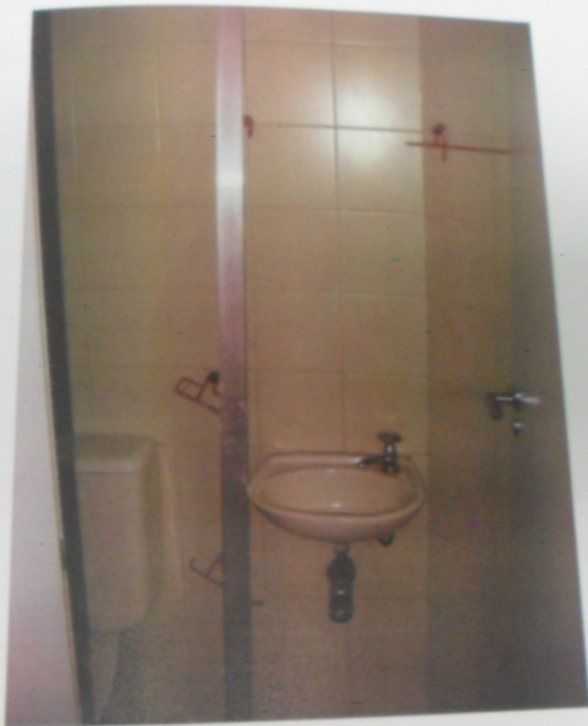
FOTO 29: BANHEIRO DE EMPREGADA.
