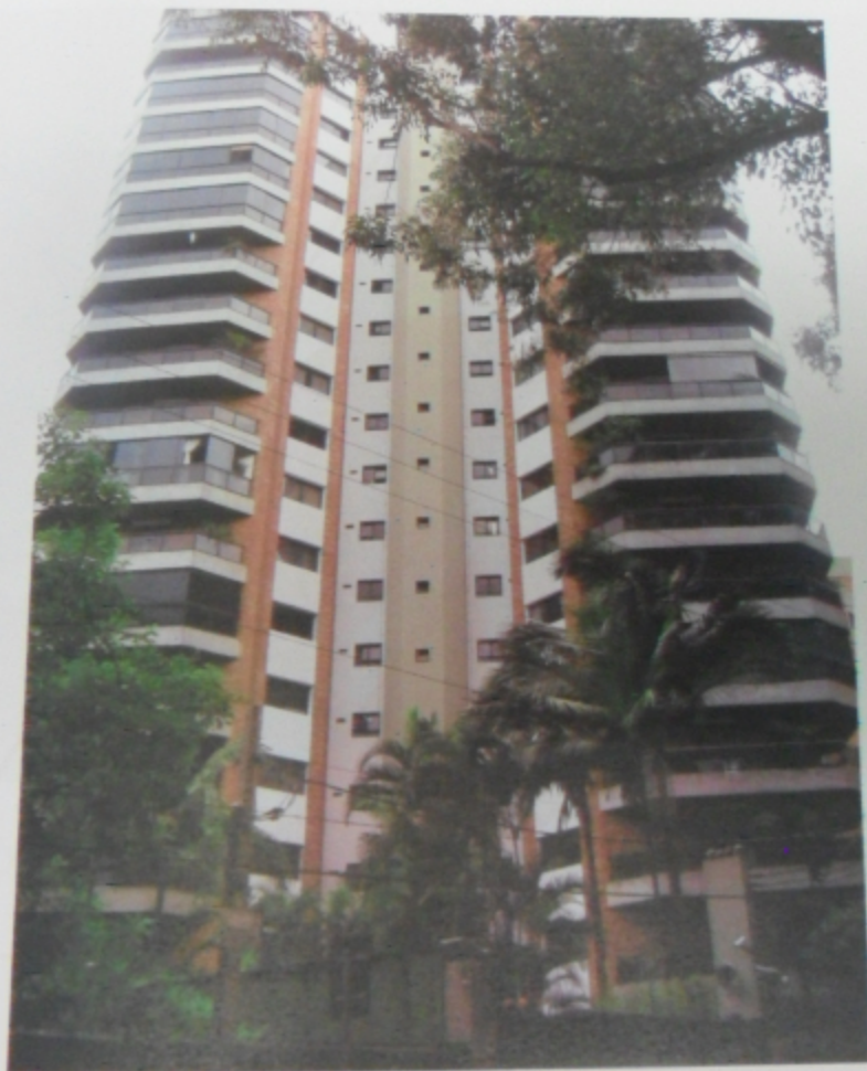
FOTO 6: OUTRA VISTA DA FACHADA.
