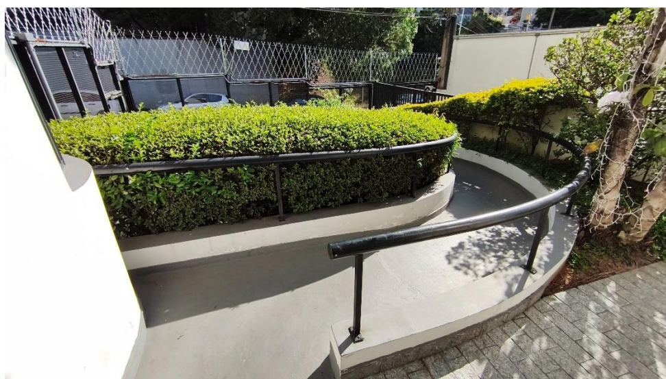
Figura 20 – Rampa de acessibilidade PCD
