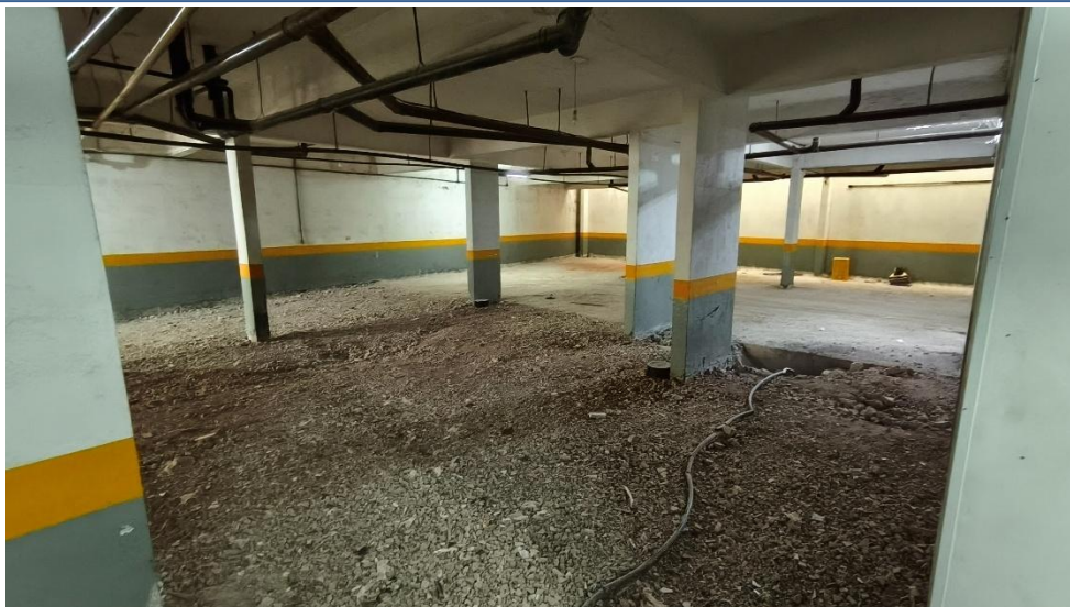
Figura 35 – Garagem em reforma
