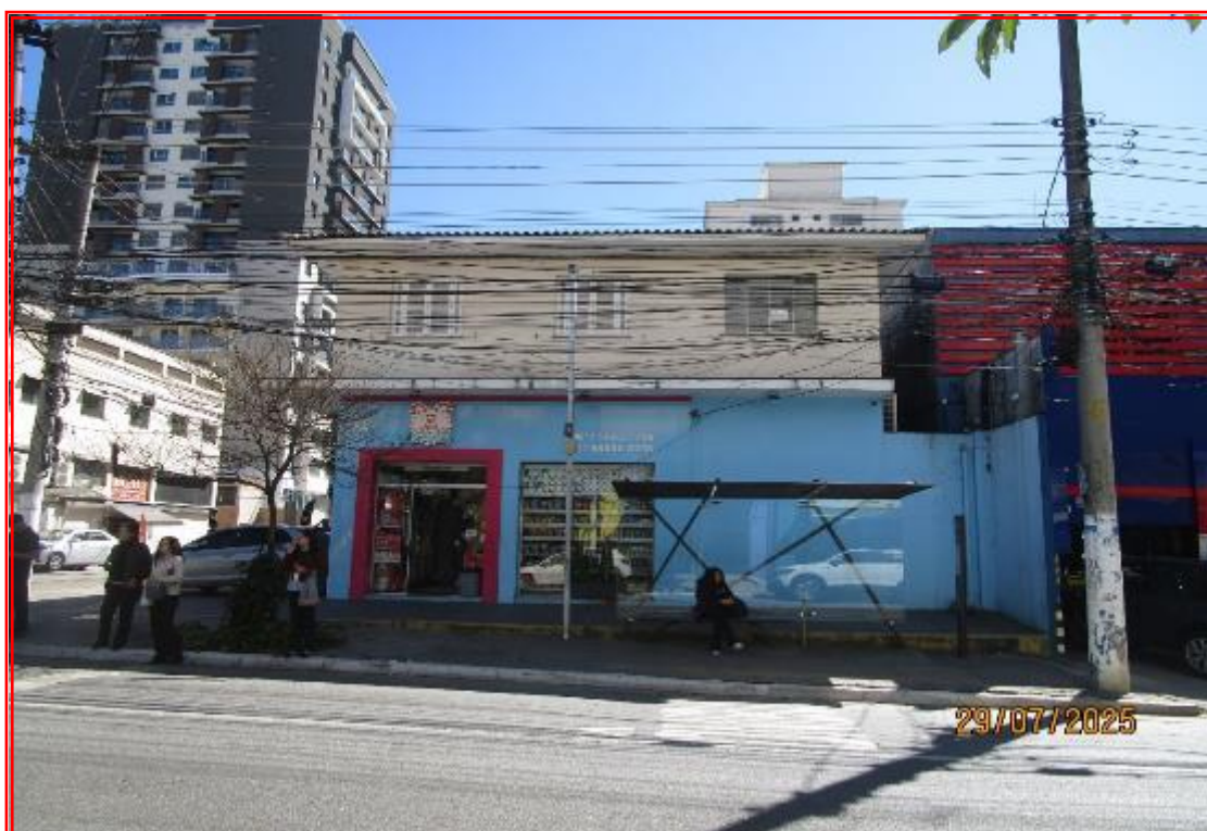
Foto nº 06: Vista geral do imóvel voltado para a Alameda dos Maracatins, loja nº 339 e apartamento 01 do superior.
