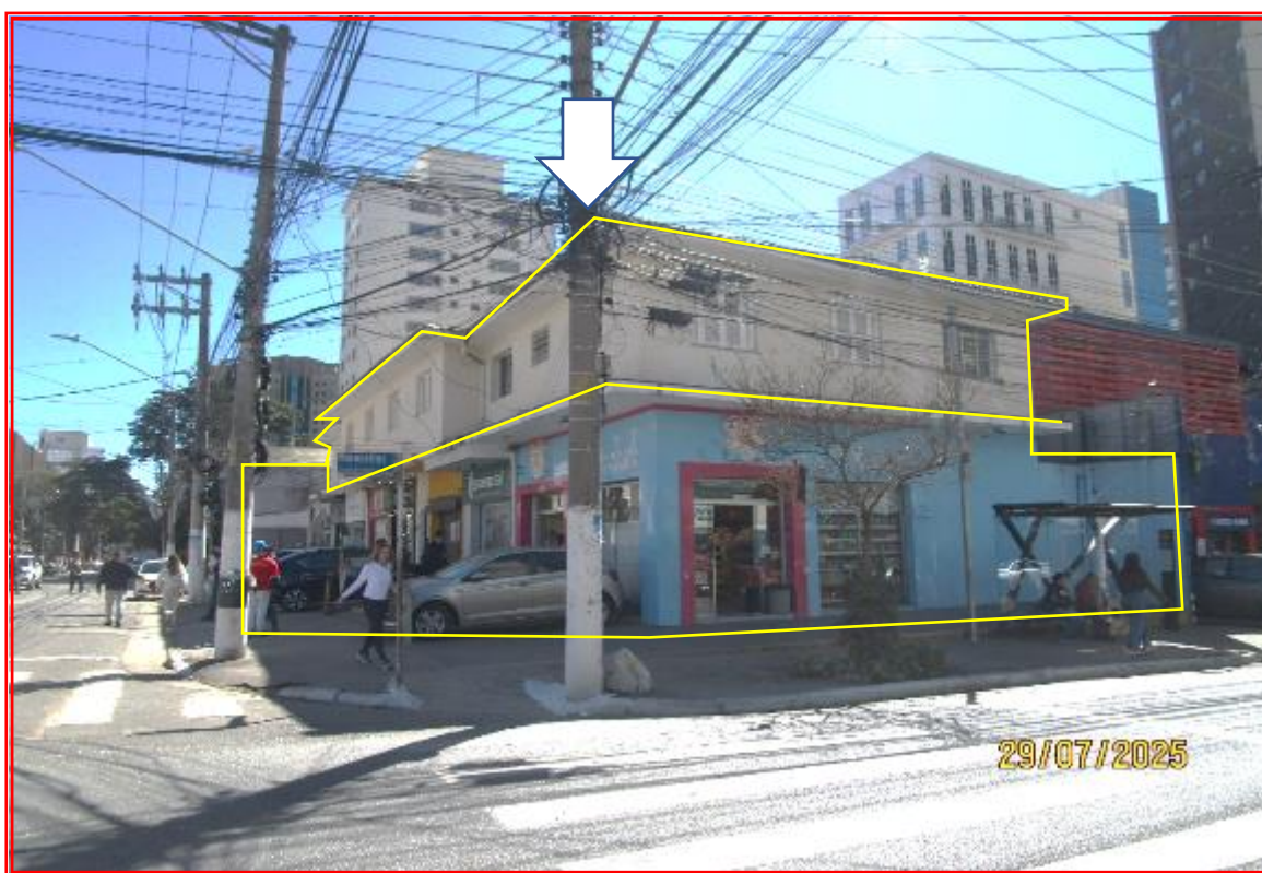
Foto 04: Vista geral da fachada do imóvel objeto da avaliação.
