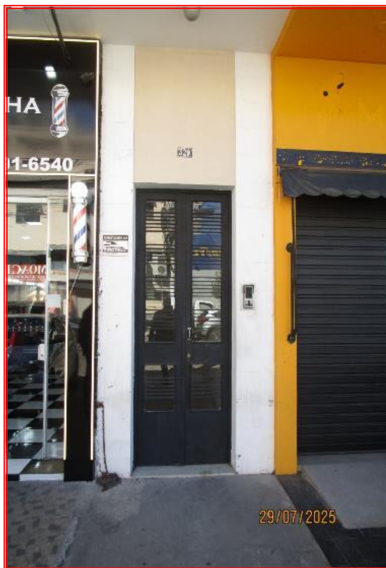
Foto nº 33: Vista da porta de acesso ao pavimento superior sob nº 329 da Avenida Moaci.
