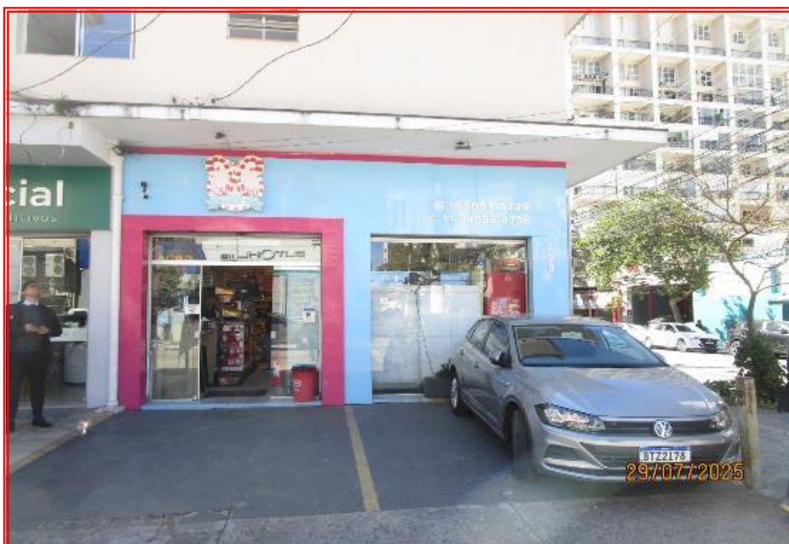
Foto nº 27: Vista parcial da loja nº 339, locada para terceiros.
