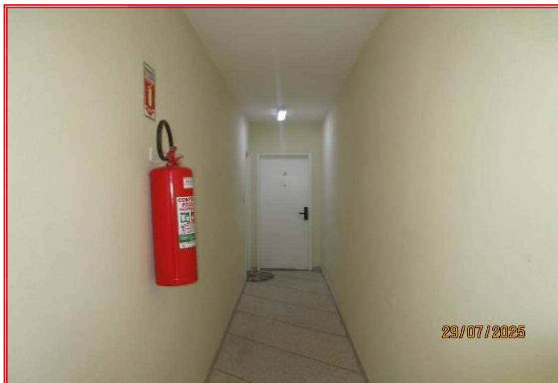
Foto nº 36: Vista parcial do hall de circulação do pavimento superior, onde se localizam os apartamentos.
