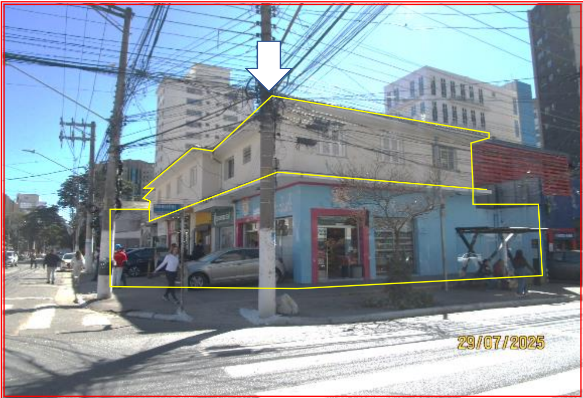
Foto: Vista geral da fachada do imóvel objeto da avaliação.
