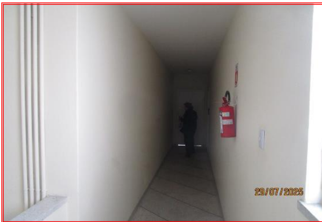
Foto nº 48: Vista parcial do hall de circulação, tomada de outro ângulo, em direção ao hall de entrada dos apartamentos 03 e 04.
