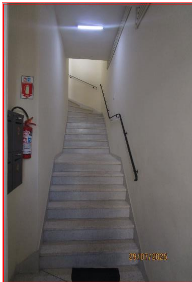
Foto nº 35: Vista da escada de acesso ao pavimento superior.
