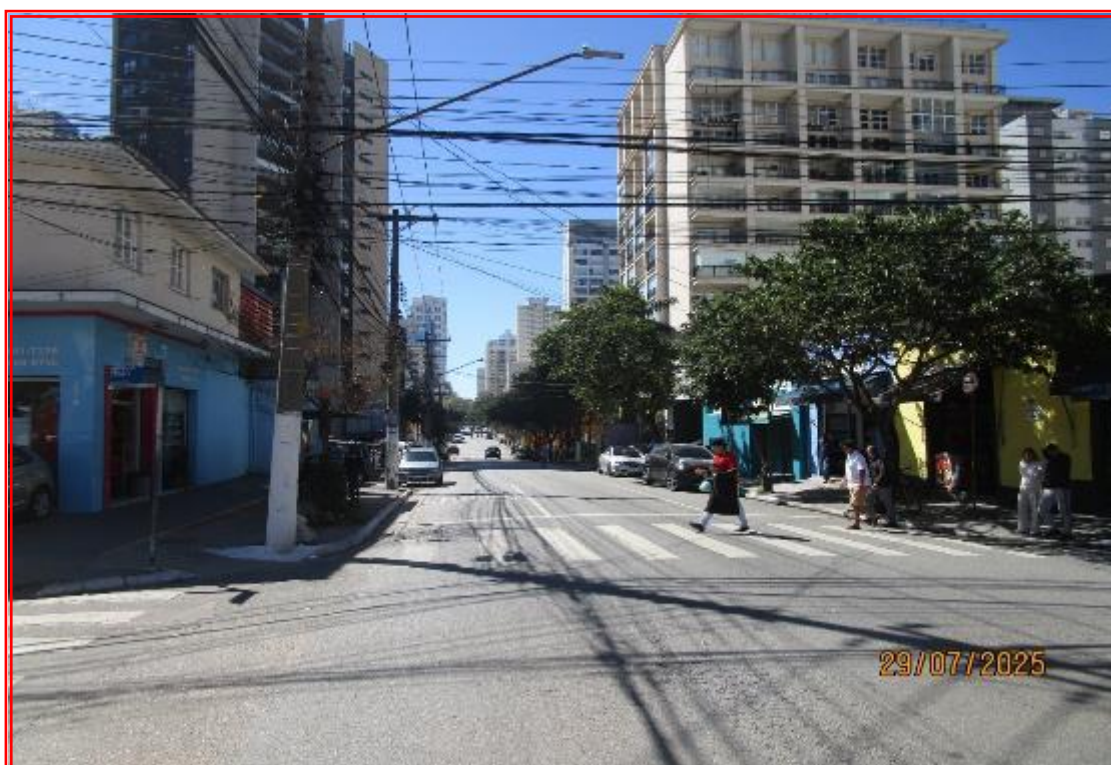
Foto nº 03: Vista parcial da Alameda dos Maracatins, na confluência com a Avenida Moaci, com detalhe para o imóvel à direita.
