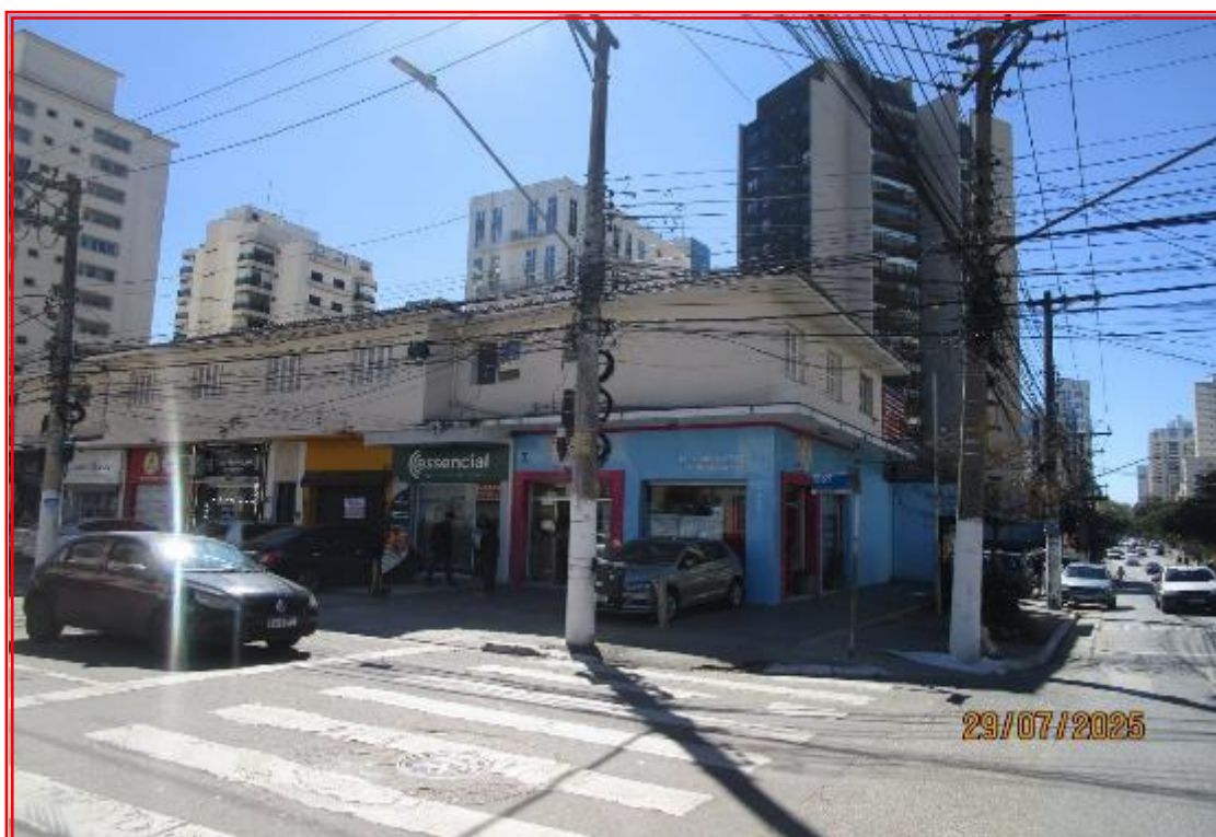
Foto nº 05: Vista geral do imóvel avaliando, com detalhe para a vagas frontais, lojas do pavimento térreo e apartamentos no superior.
