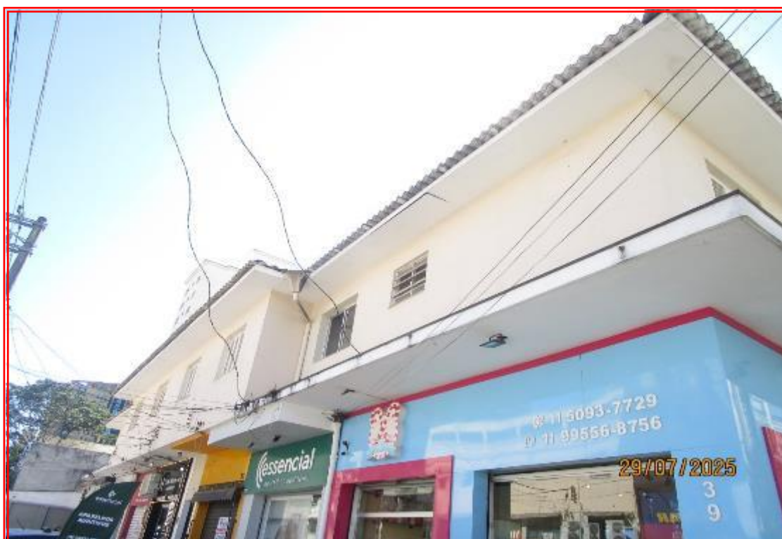
Foto nº 32: Vista parcial da fachada do imóvel, com detalhe para o pavimento superior onde se localizam os apartamentos.
