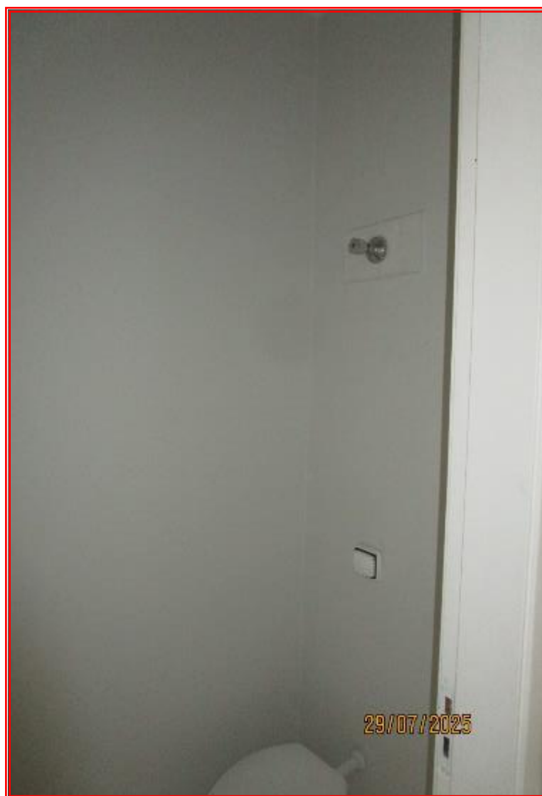
Foto nº 46: Vista parcial do sanitário.
