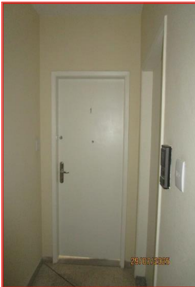
Foto nº 38: Vista geral da porta do apartamento 01, desocupado disponível para locação.
