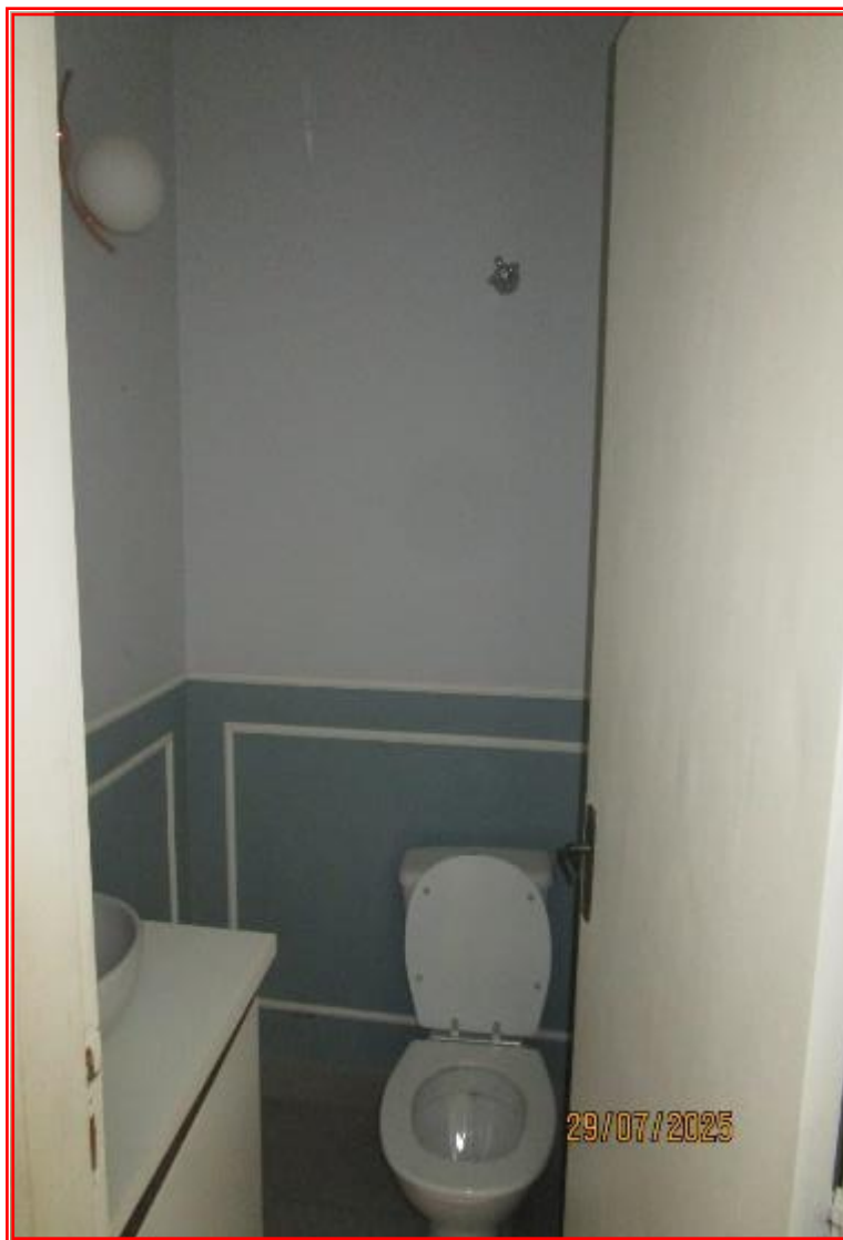
Foto nº 17: Vista geral do sanitário.
