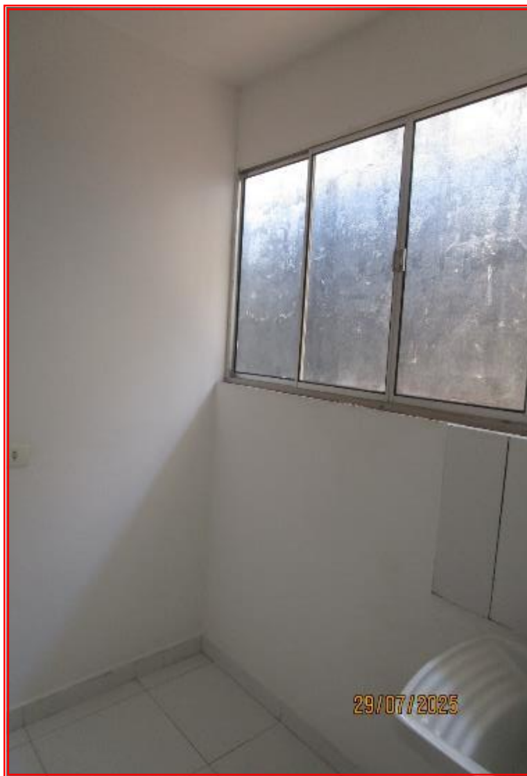
Foto nº 45: Vista parcial da área de serviço.
