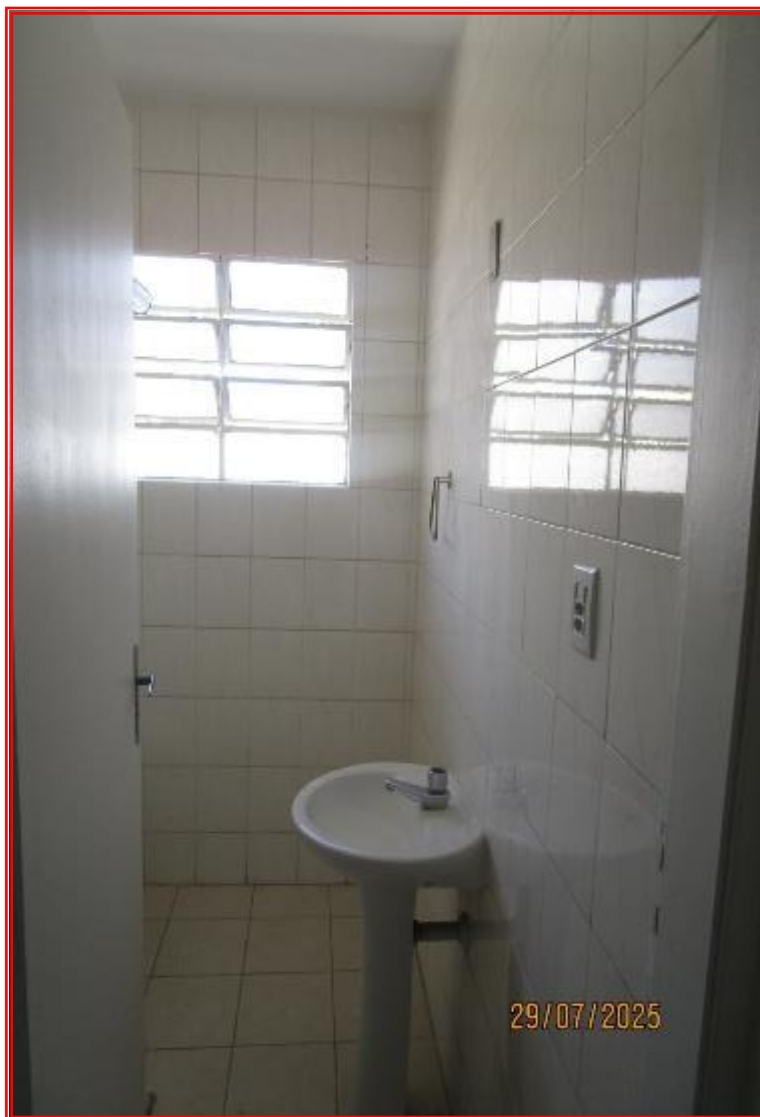
Foto nº 43: Vista parcial do banheiro.
