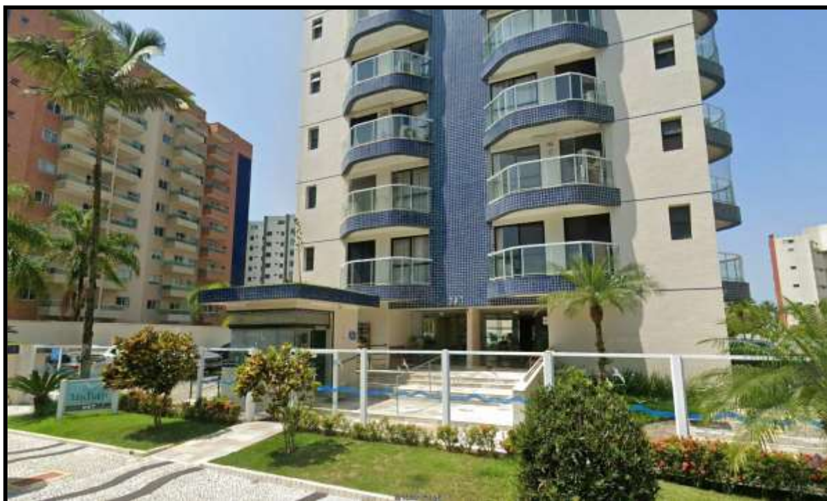
2. Fachada do Edifício Indian.
