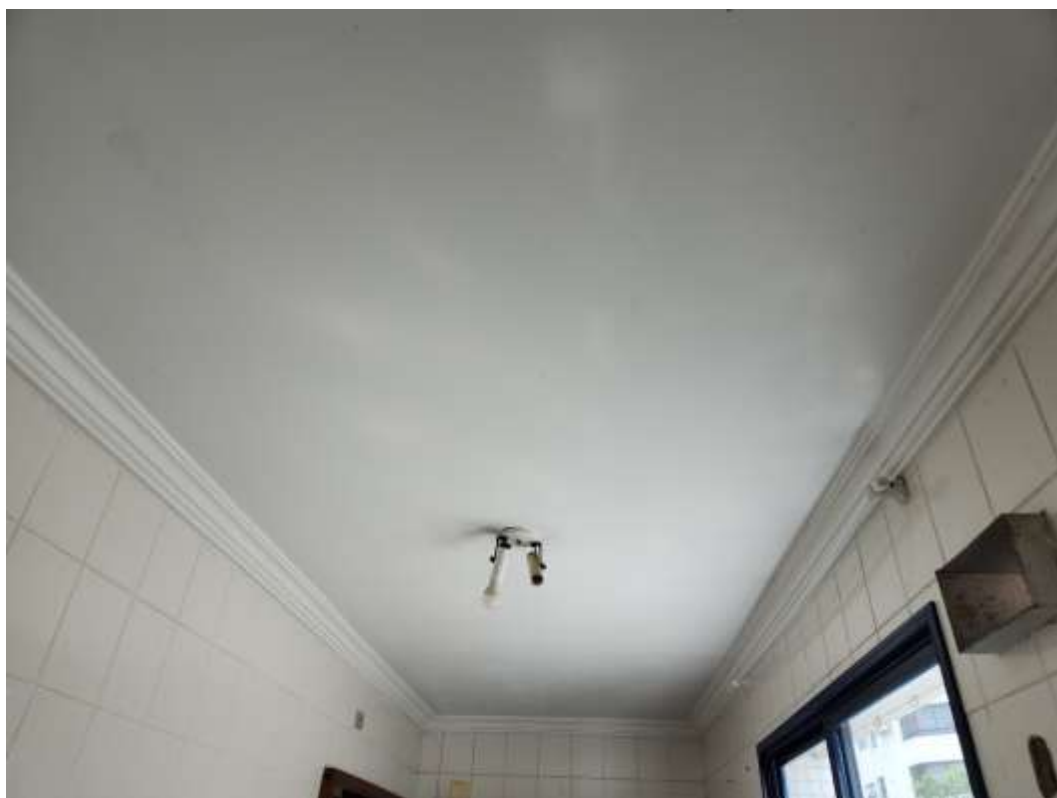
Teto da cozinha com iluminação sobreposta.
