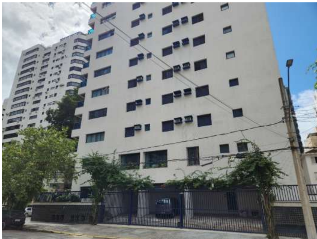
Fachada lateral pela Rua Piracicaba – vagas de estacionamento no pavimento térreo.
