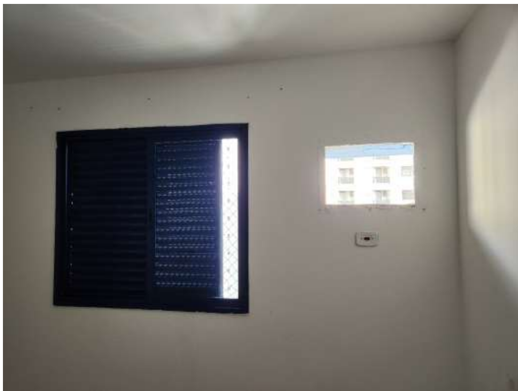
Caixilho do dormitório em detalhes.
