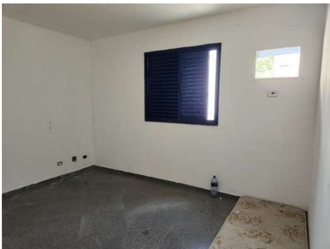
Vista geral do dormitório.
