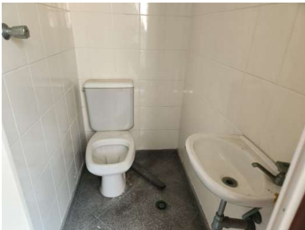
Banheiro de serviço.
