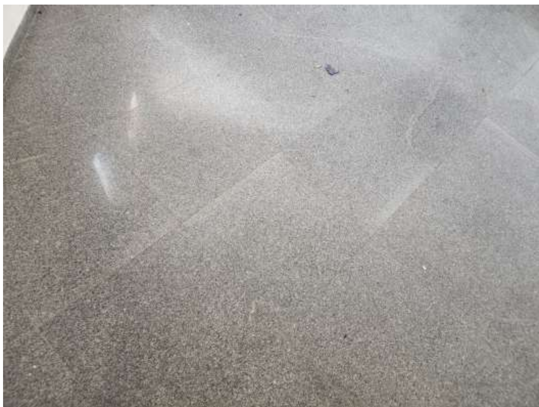
Revestimento sobre o piso da suíte master.
