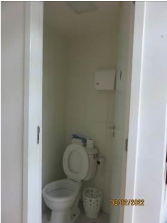
FOTOS N° 19/20: Vista de banheiro ao imóvel avaliando.
