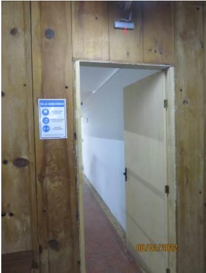
FOTOS N° 23/24 : Vista interna do imóvel avaliando ..
