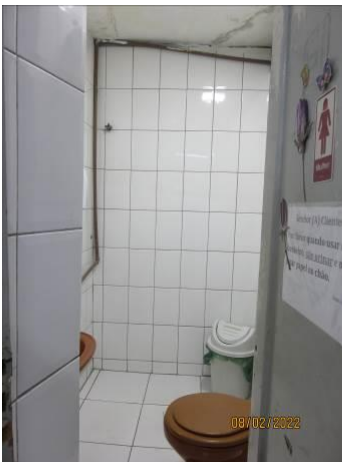
FOTOS N° 13/14: Vista salão e banheiro do imóvel avaliando.
