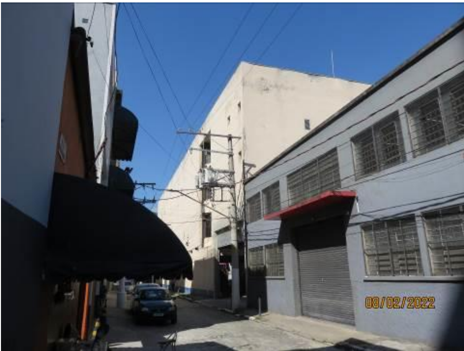
FOTOS Nº 21/22: Vista frontal do imóvel avaliando.
