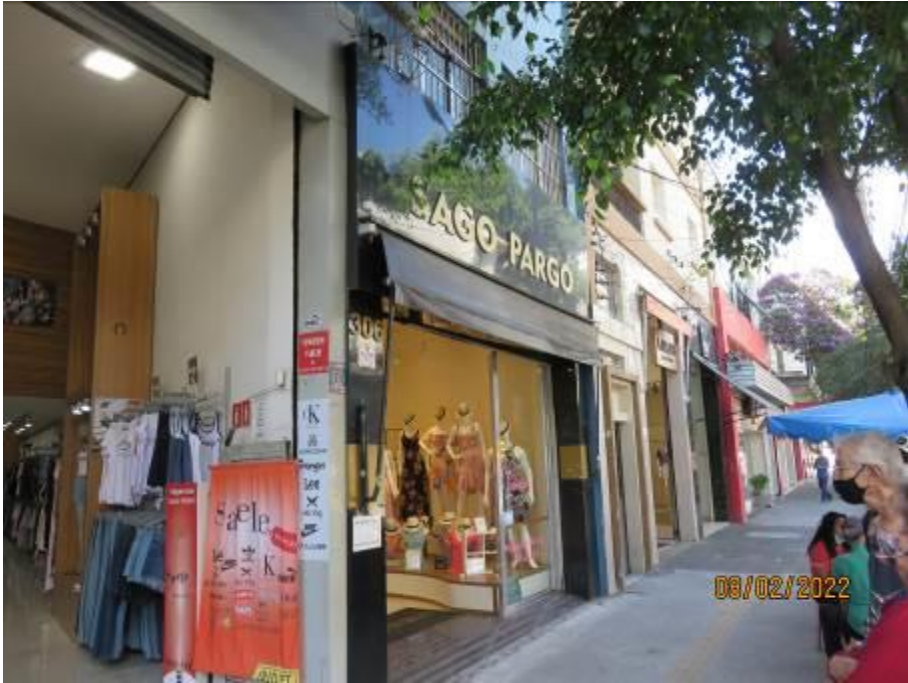
FOTOS N° 03/04: Vista frontal dos imóveis da Rua Silva Teles, 306/312 integrantes do imóvel avaliando , Brás.
