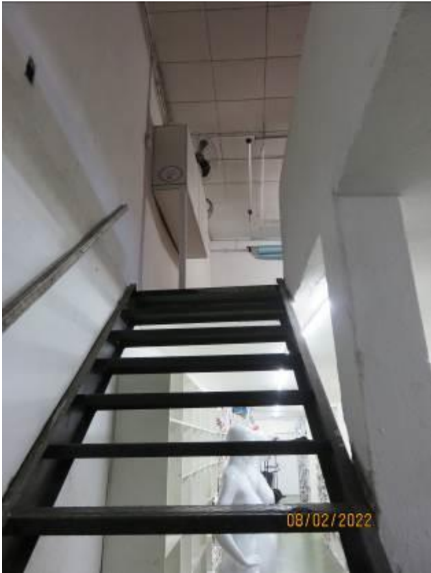
FOTOS N° 17/18: Vista interna do imóvel avaliando , localizado Rua Silva Teles, nº 306 , Brás.
