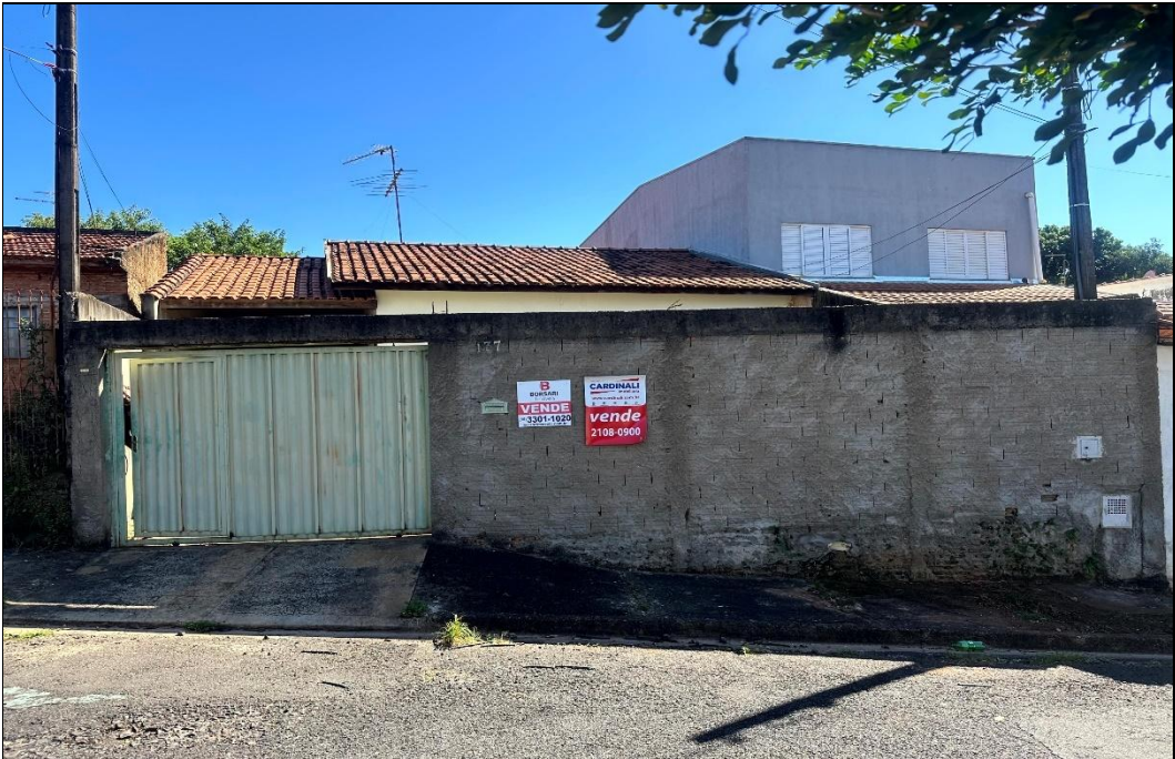
FOTO 01 – Vista frontal do imóvel localizado na Avenida José Valente nº137.
