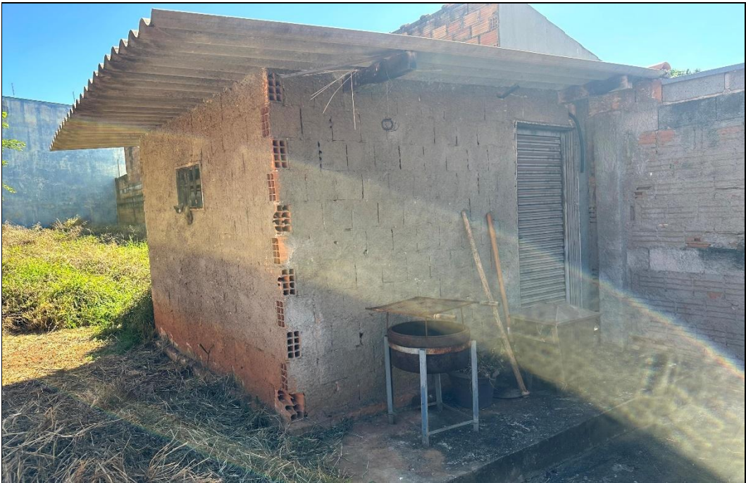
FOTO 10 – Vista geral da construção inacabada nos fundos do imóvel.
