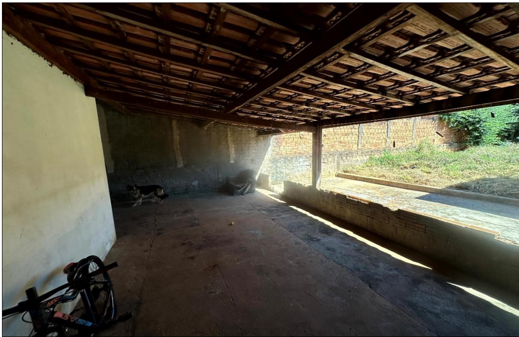
FOTO 08 – Vista geral da varanda externa com cobertura em telhas cerâmicas do imóvel.
