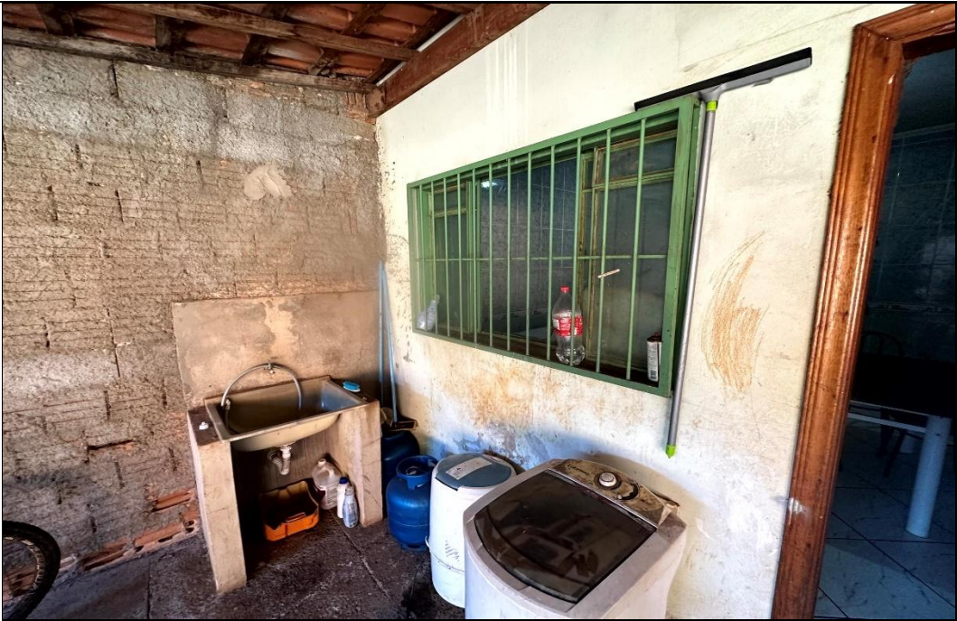
FOTO 09 – Vista geral área de serviço do imóvel.
