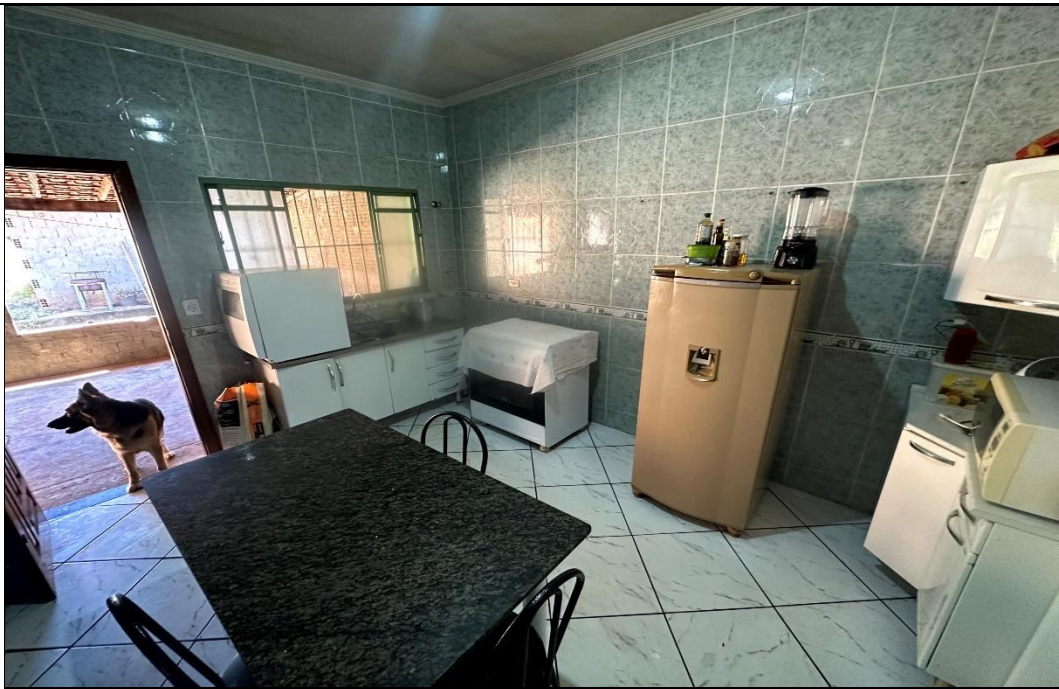
FOTO 07 – Vista geral da cozinha com revestimento cerâmico nas paredes do imóvel.
