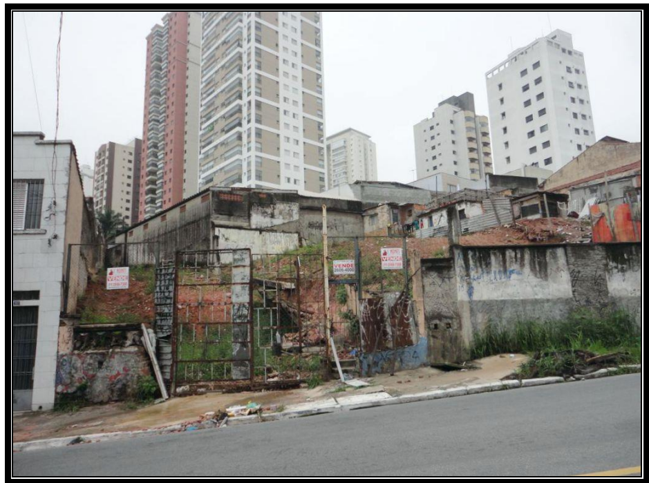
Vista da frente dos imóveis avaliandos.
