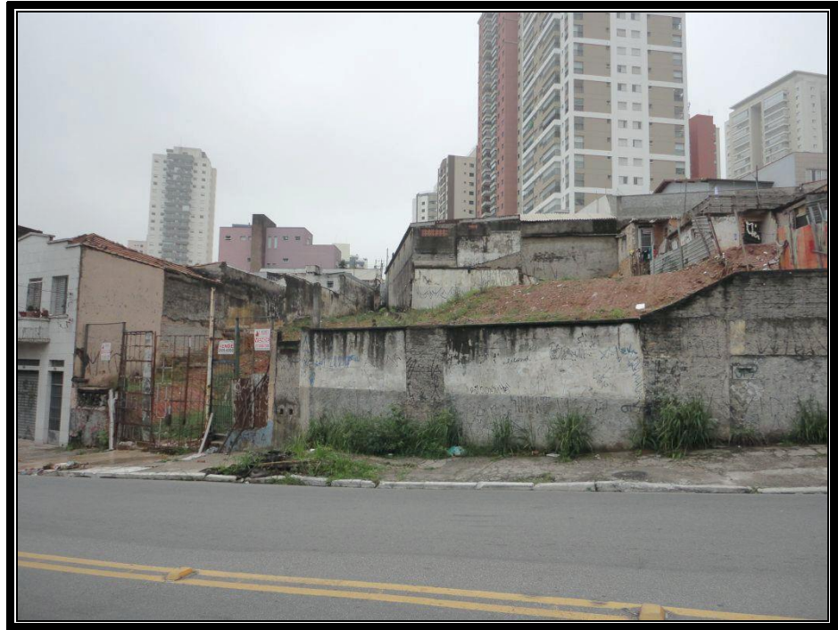
Vista da frente dos imóveis avaliandos.
