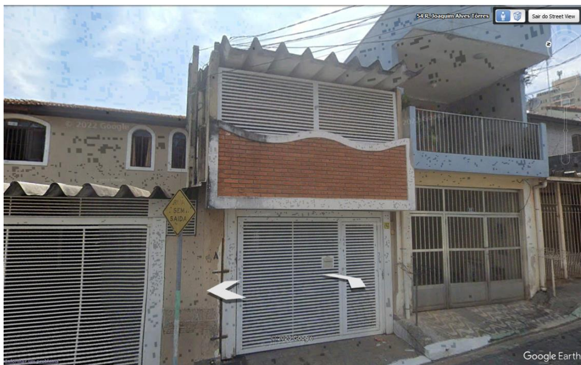
VISTA DO IMÓVEL AVALIANDO
