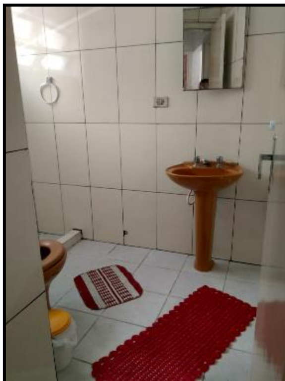
Foto 11 – Apartamento nº 23 (similar ao apartamento avaliando): Vista do Banheiro.
