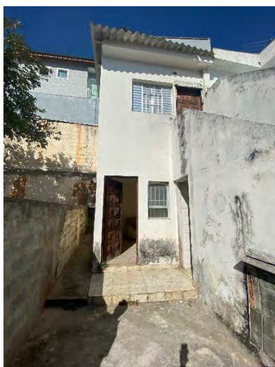
Foto 59 – Vista da edificação
