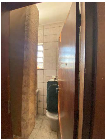
Foto 87 – Banheiro (pisso superior)
