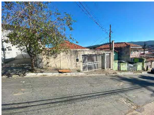
Foto 1 – Vista do Imóvel
