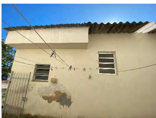
Foto 41 – Quintal (detalhe da parede)
