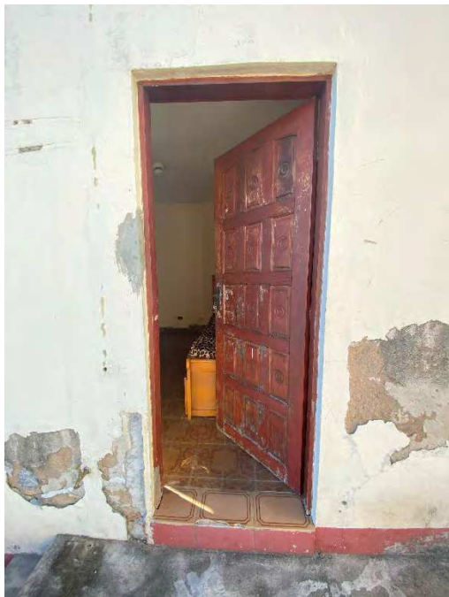
Foto 47 – Entrada do imóvel 2
