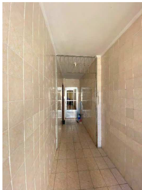
Foto 38 – Corredor para lavanderia
