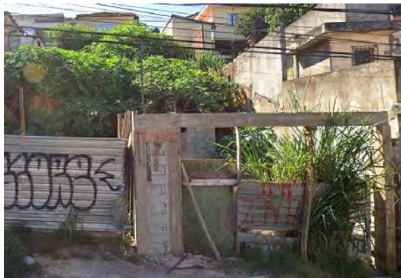
Figura 17: Rua das Imbiras, 642 - Vila Nova Mazzei, São Paulo - SP
