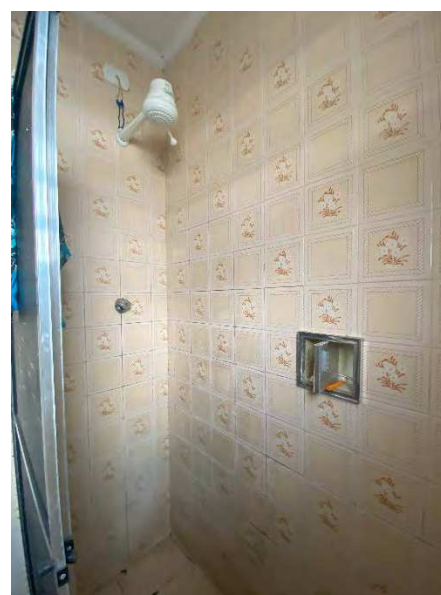
Foto 56 – Banheiro (detalhe do chuveiro)
