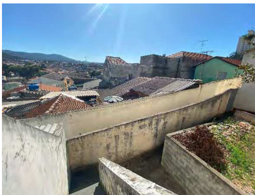
Foto 70 – Vista de fora do Quarto 2
