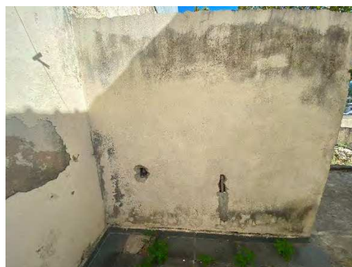
Foto 40 – Quintal (detalhe da parede)
