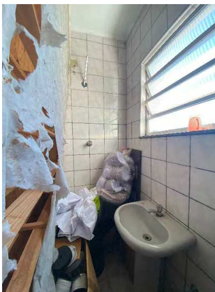
Foto 88 – Banheiro (pisso superior)
