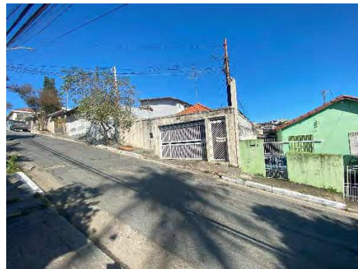
Foto 2 – Vista do Imóvel
