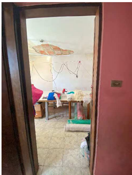
Foto 83 – Acesso para Quarto 1
