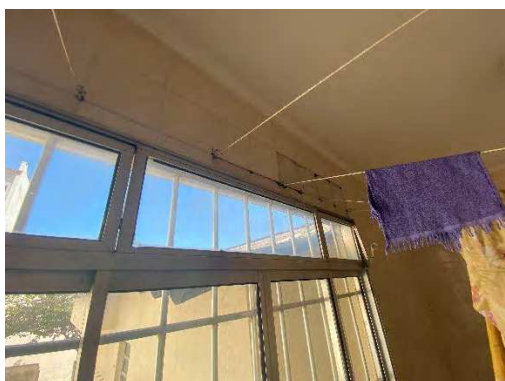
Foto 37 – Lavanderia (detalhe da parede)
