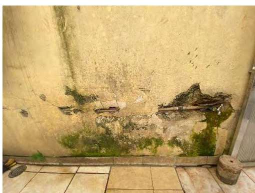
Foto 120 – Detalhe da parede externa
