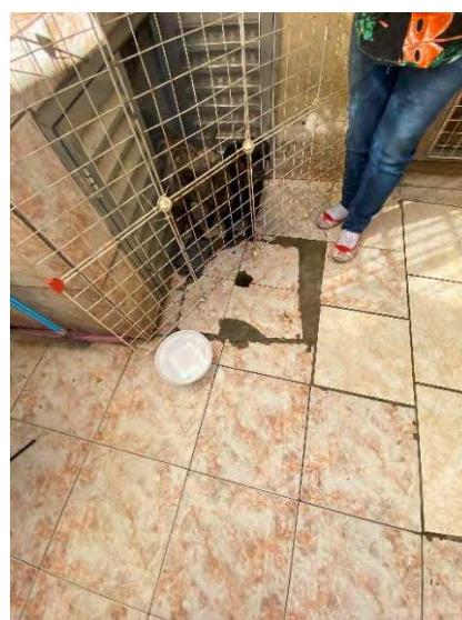
Foto 121 – Detalhe do piso (fossa)
