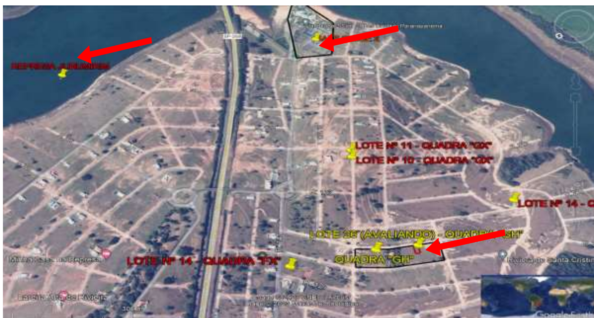
Foto Aérea da Localização do Lote 26, da represa Jurumirim e do clube - Fonte: Google Heart
