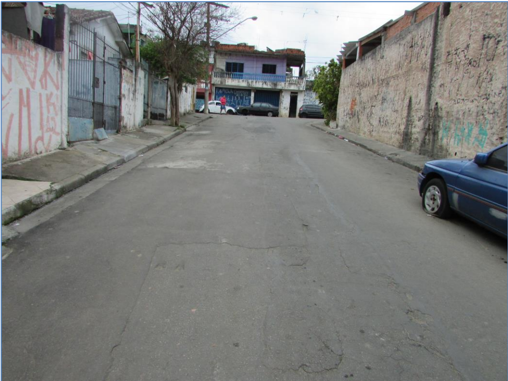
VISTAS DA EDIFICAÇÃO, PELA RUA NITERÓI.
