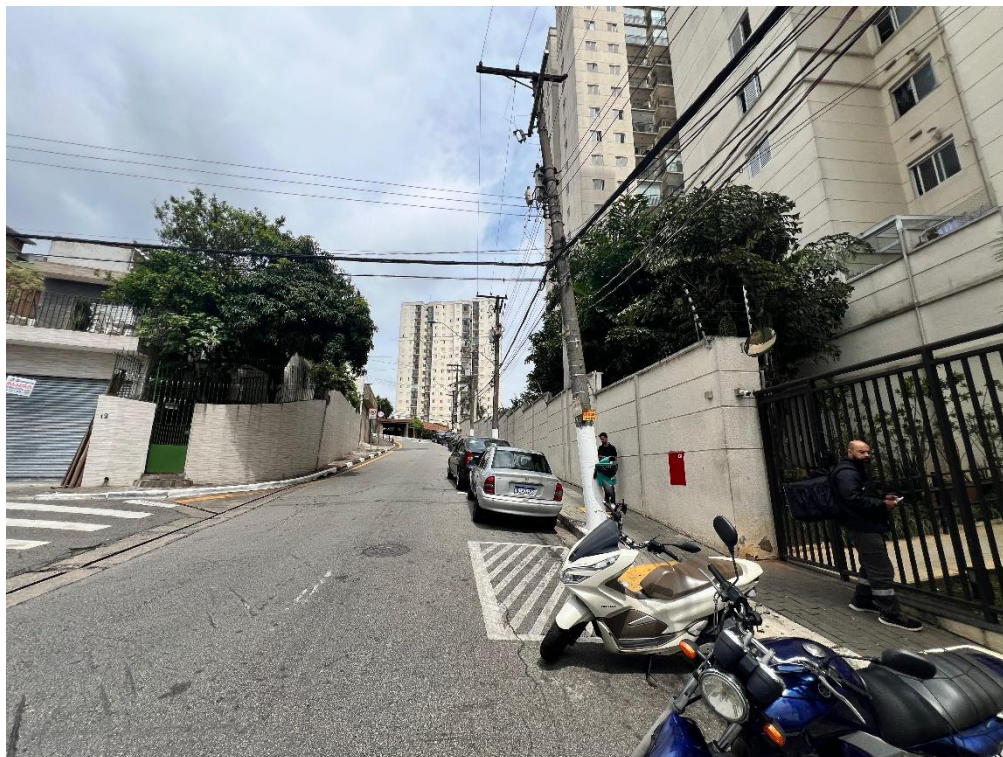
Figura 4 – Vista lateral a direita do edifício sentido rua
