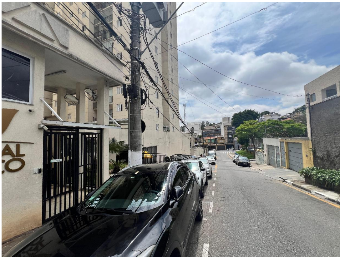
Figura 5 – Vista lateral a esquerda do edifício sentido rua
