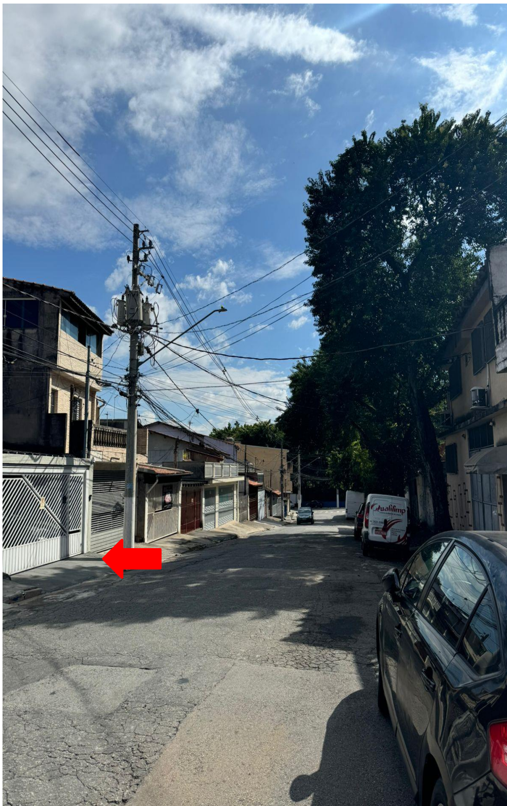
FOTO 02: Vista da Rua José Soeiro de Vaz com o imóvel avaliando localizado ao lado esquerdo
