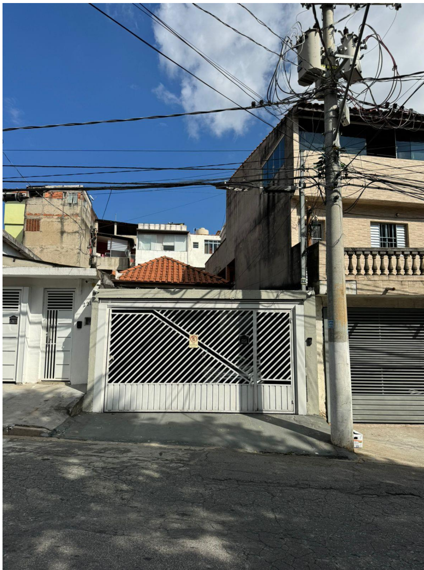
FOTO 01: Vista da fachada frontal do imóvel avaliando
