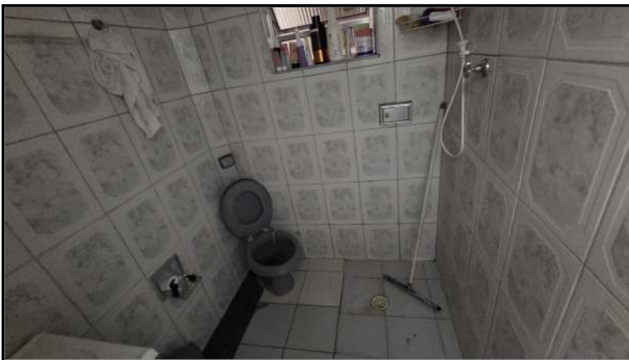
8. Vista interna do banheiro.
