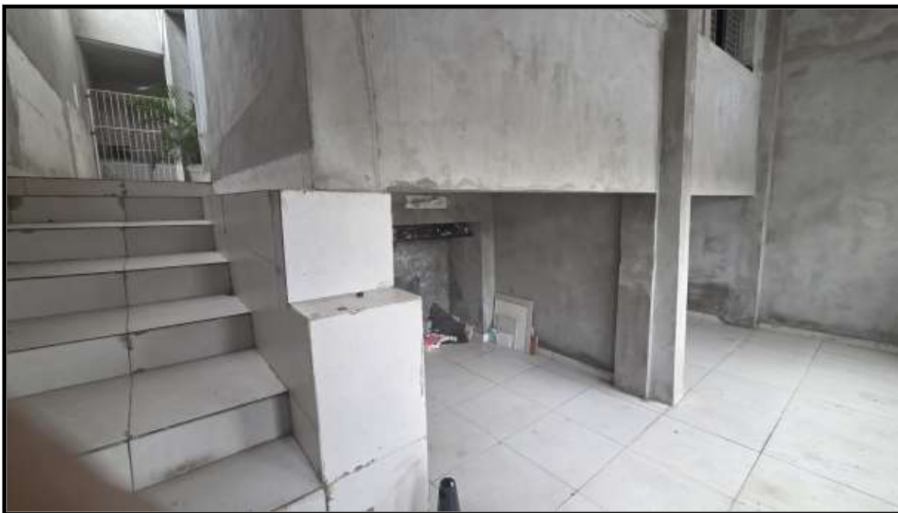
3. Vista da garagem e da escada para o pavimento superior.
