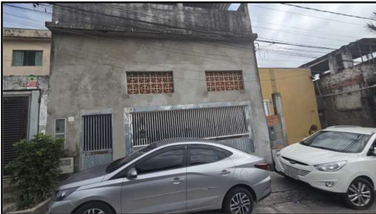
2. Vista imóvel da Rua Antônio Pinto de Miranda, nº 55.
