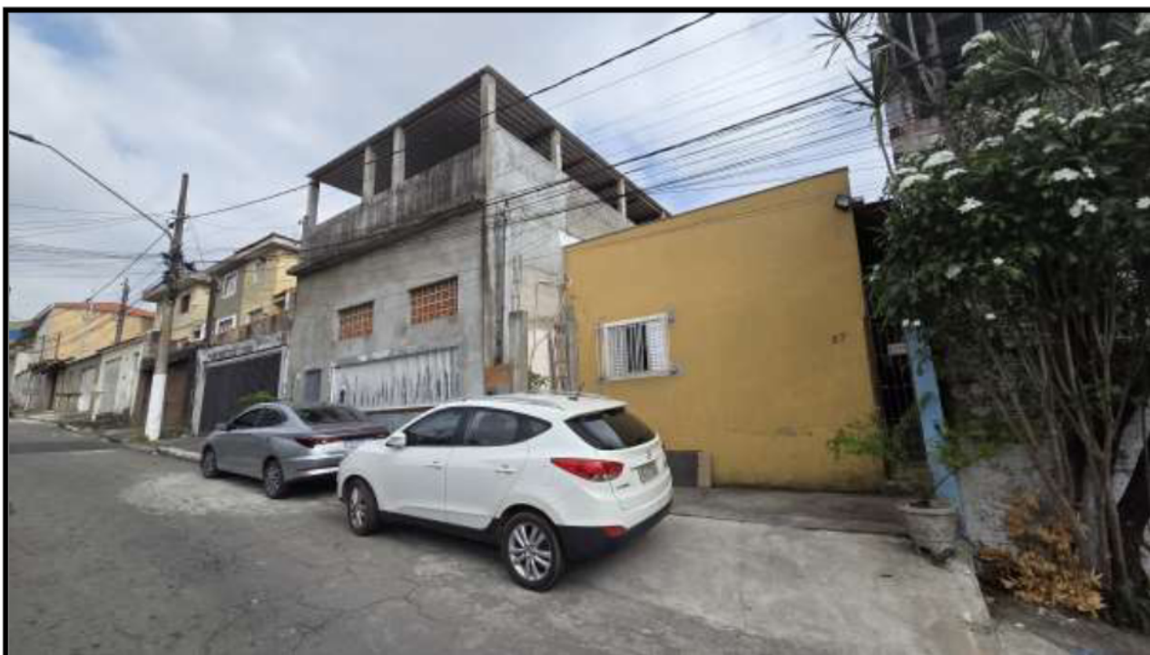
9. Vista imóvel da Rua Antônio Pinto de Miranda, nº 57.
