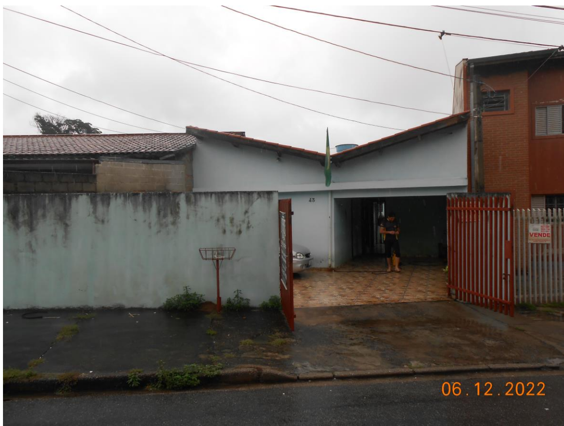
Foto 1: Vista frontal da Residência 1 – nº 43.
