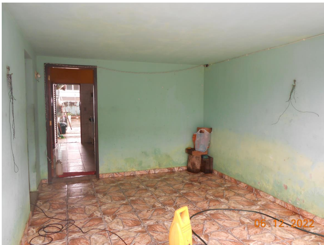
Foto 2: Vista do abrigo para veículo da Residência 1 – nº 43.
