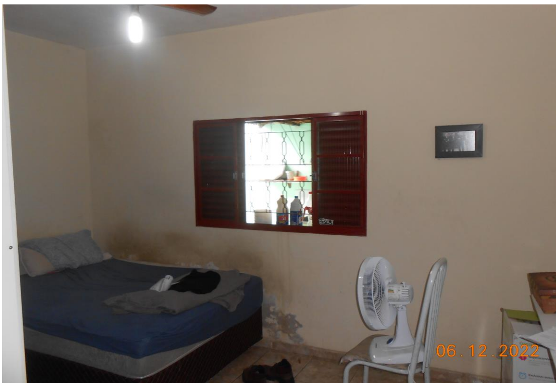
Foto 4: Vista de um dos dormitórios da Residência 1 – nº 43.
