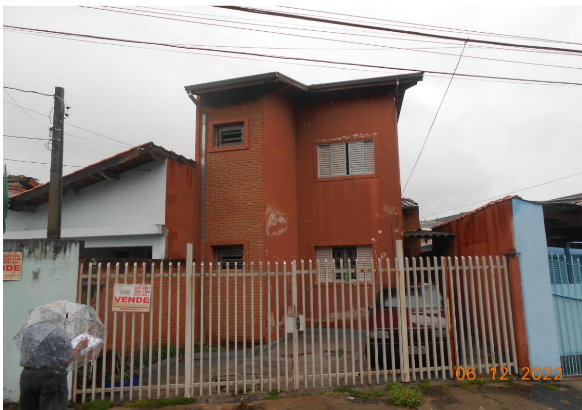
Foto 7: Vista frontal da Residência 2 – nº 49.
