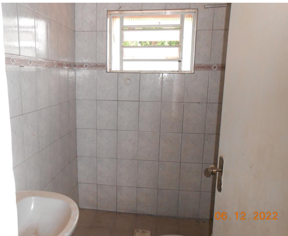
Foto 10: Vista de um dos banheiros da suíte da Residência 2 – nº 49.
