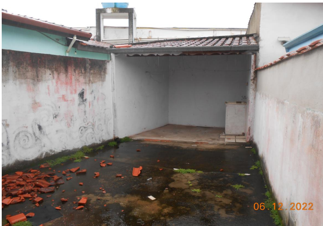
Foto 11: Vista da área de serviço da Residência 2 – nº 49.
