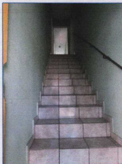
Escada de acesso ao pavimento térreo.
