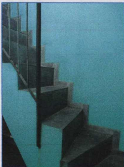
Escada de acesso ao segundo pavimento.
