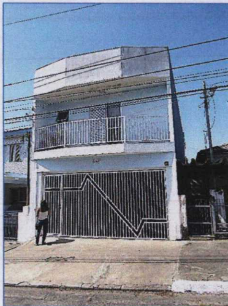
Fachada do imóvel com entrada pela Rua Maragojipe.
