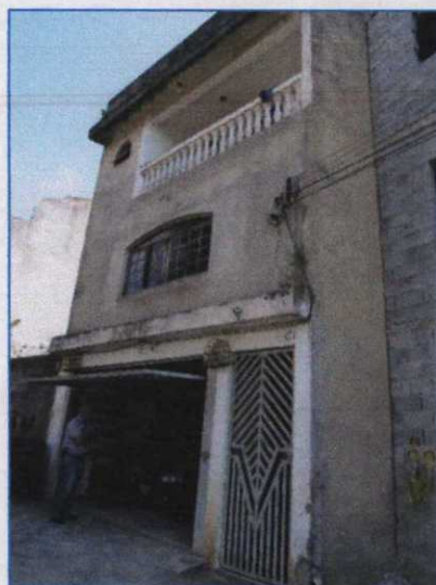
Fachada do imóvel com acesso pela Rua Caçaquera.
