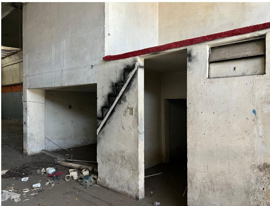
Vista da entrada do banheiro, à direita e da entrada do depósito à esquerda
