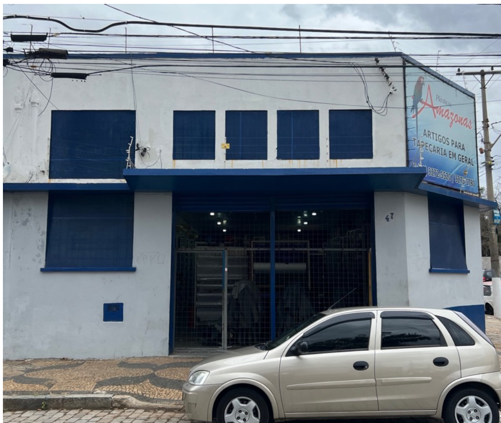
Imagem 2.02: Imóvel localizado na Rua Dr. Sales de Oliveira, Nº 47
