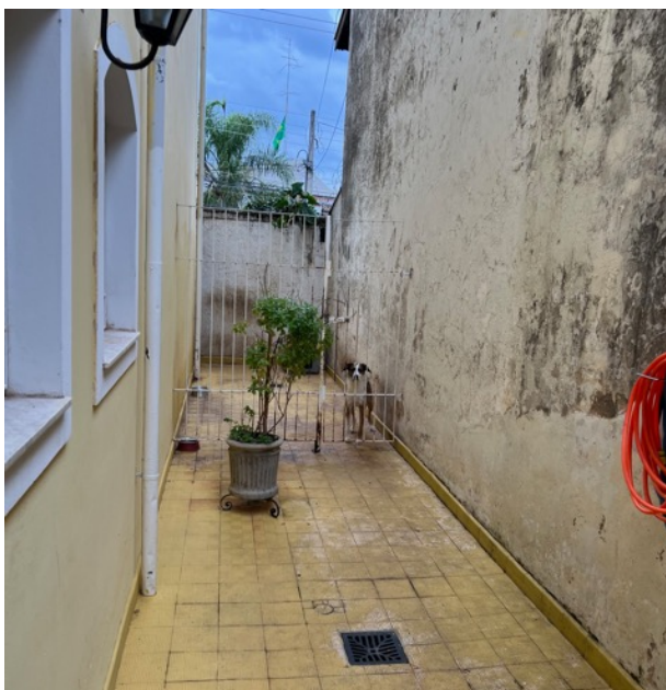
Imagem 1.21: Corredor lateral, visto da entrada / saída pela cozinha, olhando para a frente do imóvel
