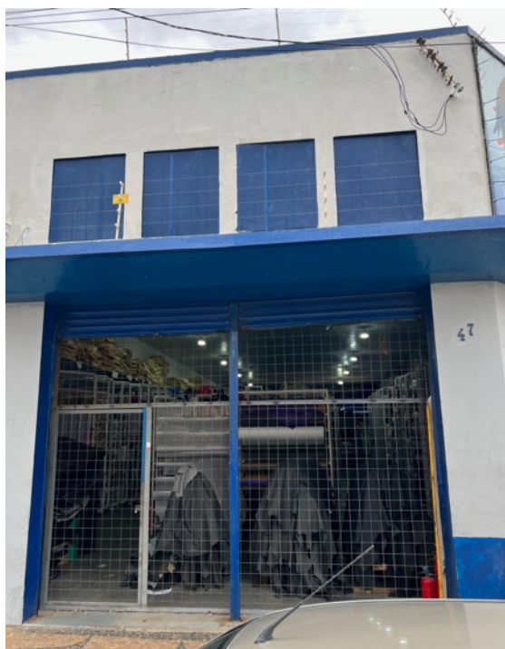
Imagem 2.06: Portão de entrada pela Rua Sales de Oliveira, visto de fora para dentro
