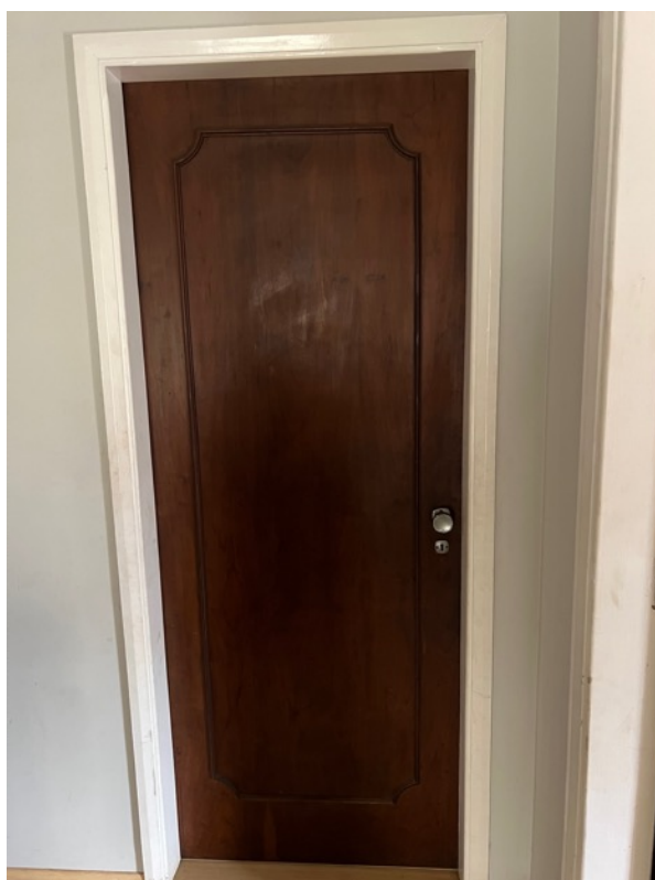
Imagem 1.16: Porta de acesso a um dos três quartos da casa
