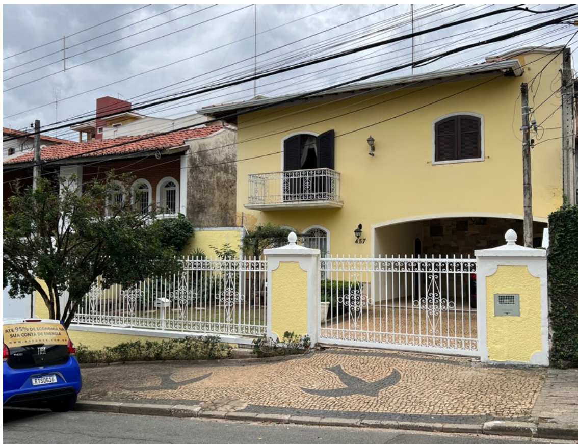
Imagem 1.02: Fachada do imóvel visto da Av. Imp. Dona Tereza Cristina
