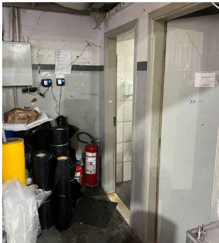
Imagem 2.13: Local ao lado da entrada principal, onde foi construído 2 banheiros
