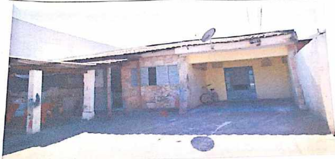
VISÃO DA FACHADA DA RESIDENCIA
