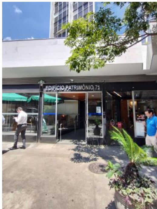
Vista parcial entrada Edifício Patrimônio (Rua Manoel da Nóbrega)
