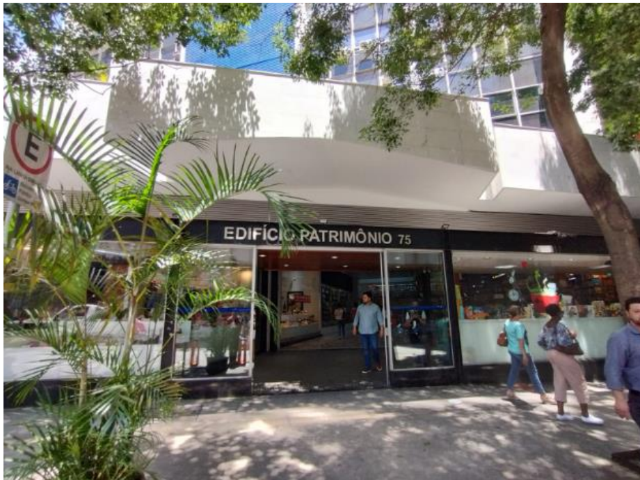
Vista parcial entrada Edifício Patrimônio (Rua Manoel da Nóbrega)
