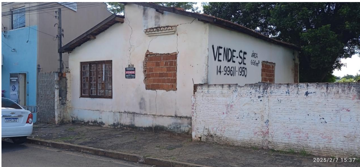
Imagem 05 - Vista da residência que integra o imóvel
