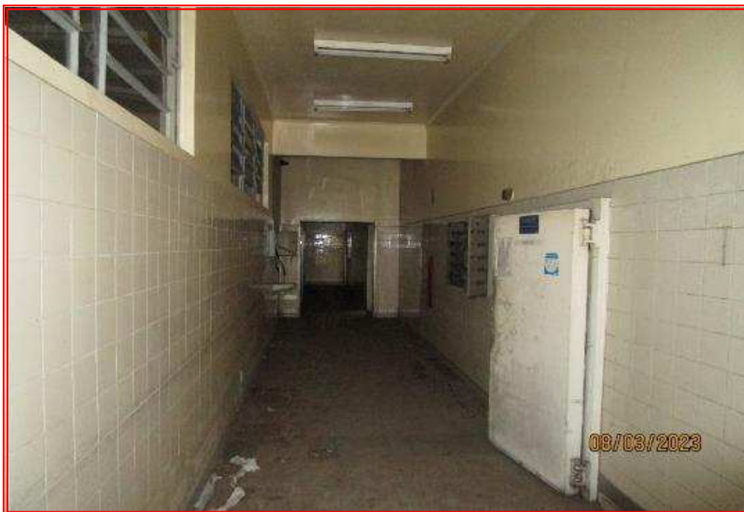
Foto nº 77: Corredor de acesso a câmara frigorífica e cozinha.
