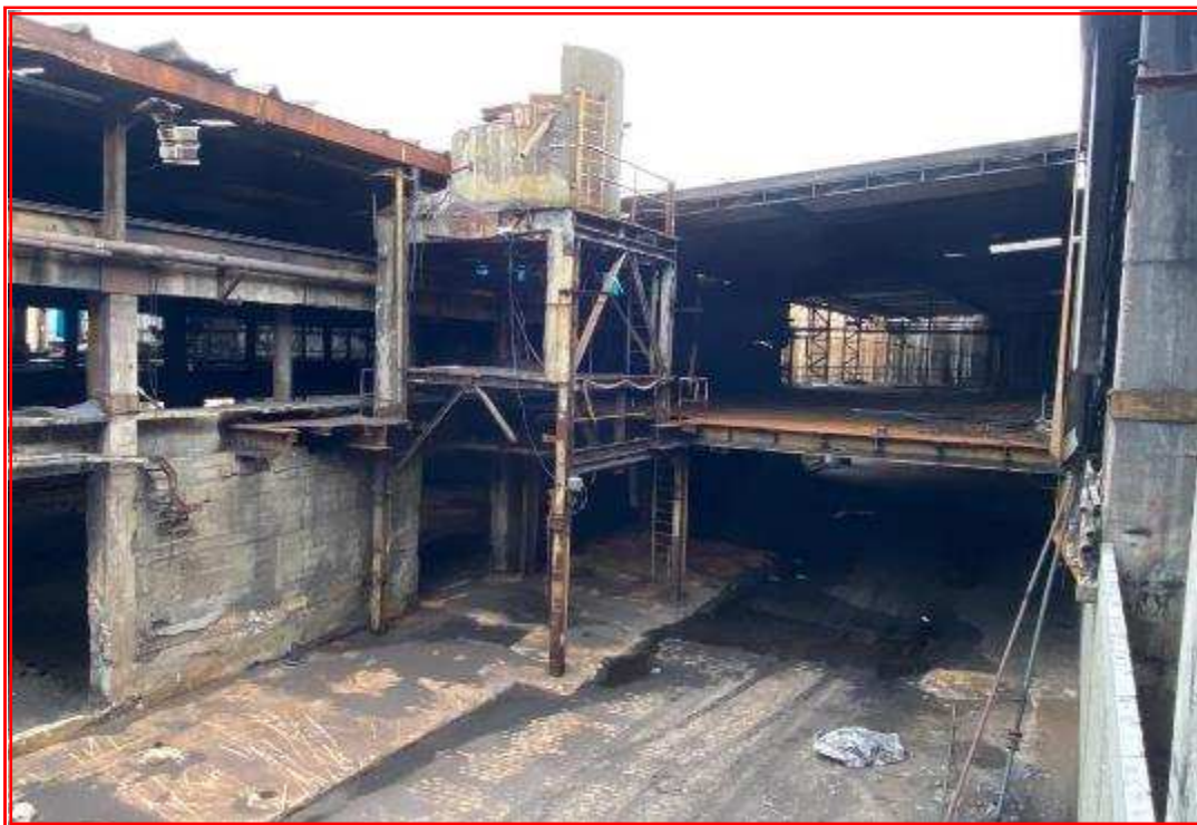
Foto nº 131: Vista geral da antiga fábrica 1.
