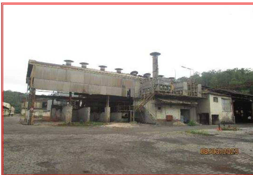
Foto nº 103: Vista geral da antiga fábrica 2.
