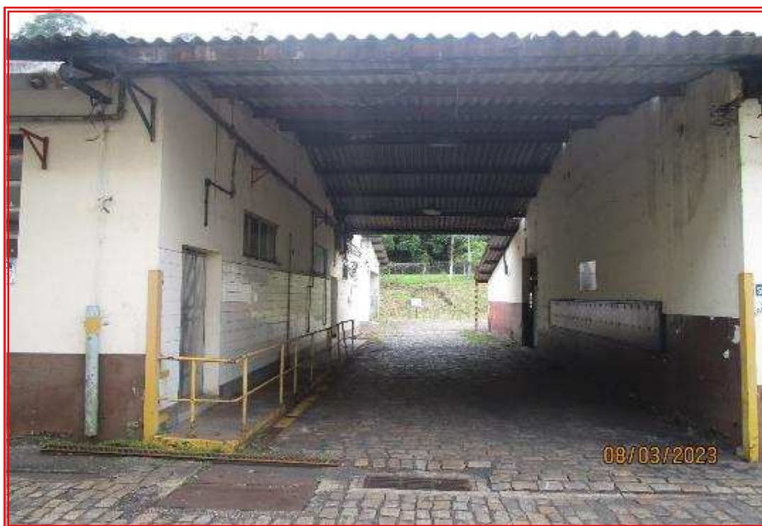
Foto nº 72: Acesso ao refeitório, cozinha e galpão do almoxarifado.
