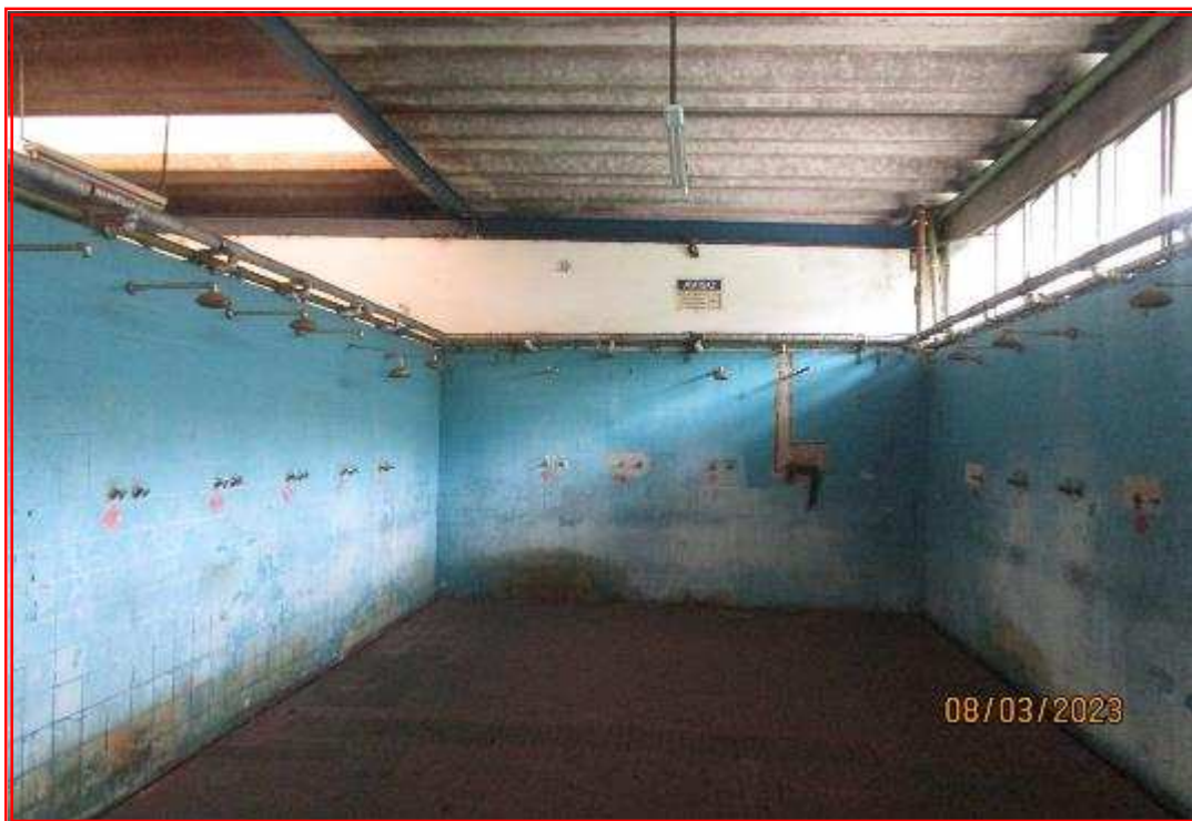
Foto nº 67: Vista interna vestiário.
