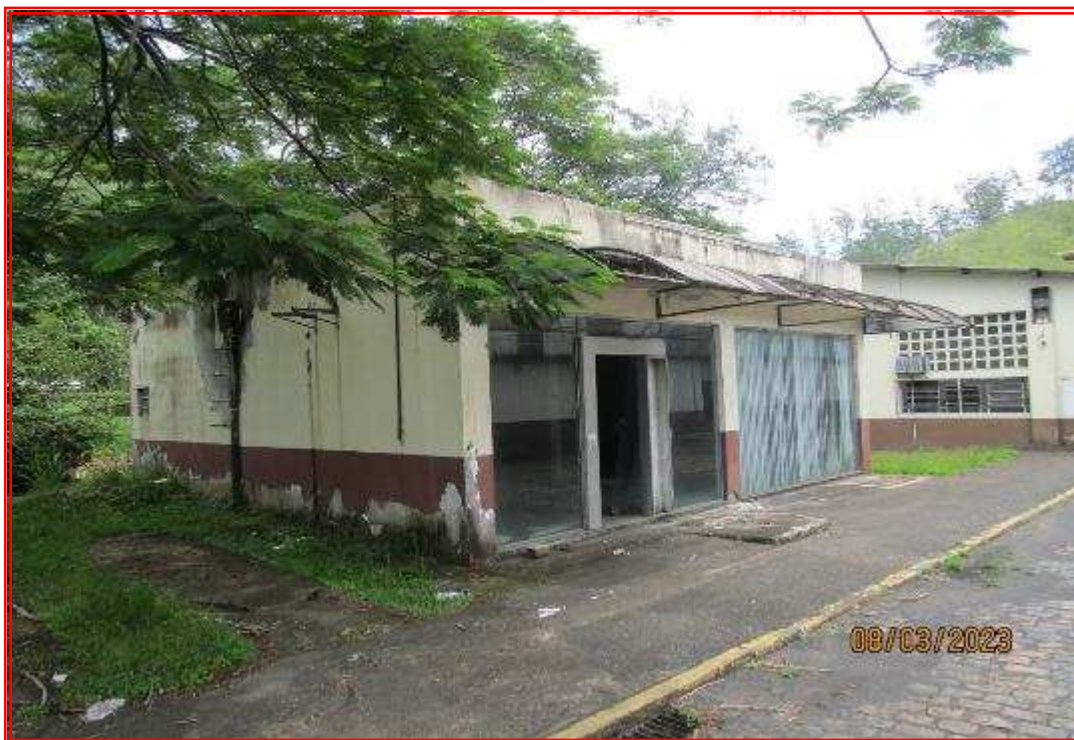
Foto nº 69: Vista externa do prédio de uso bancário.
