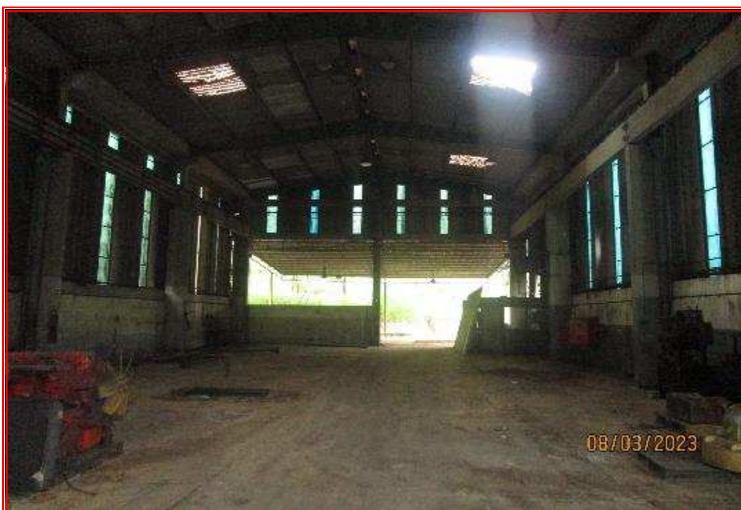
Foto nº 86: Vista interna do galpão, tomada de outro ângulo.
