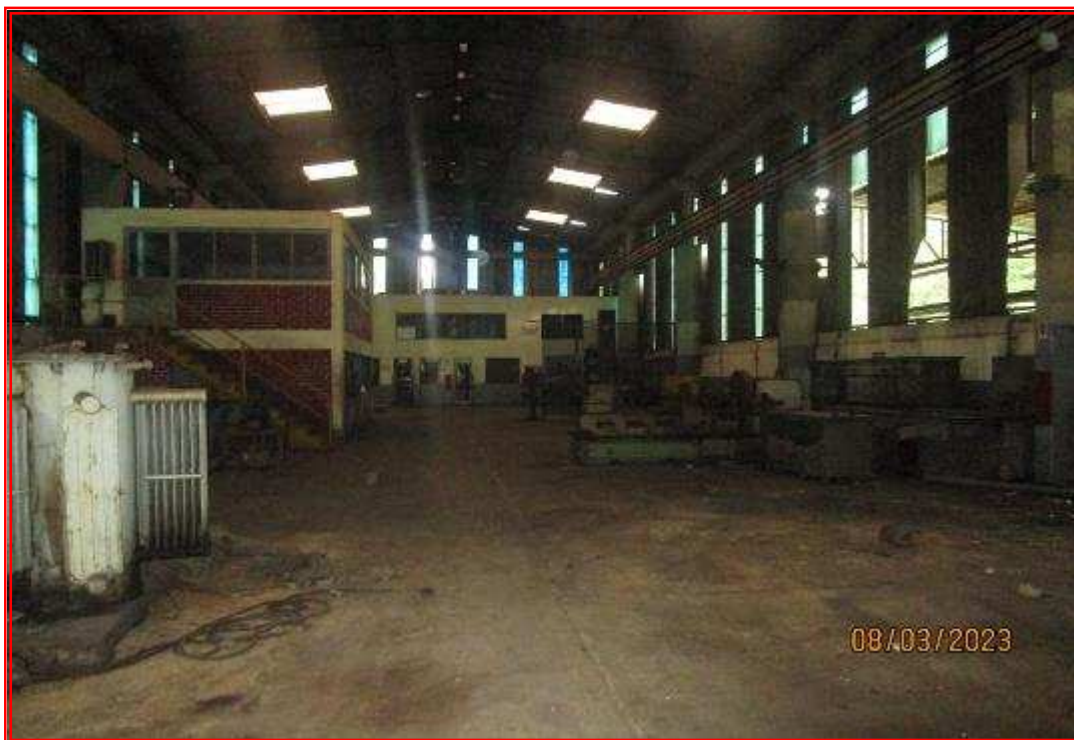
Foto nº 85: Vista interna do galpão.
