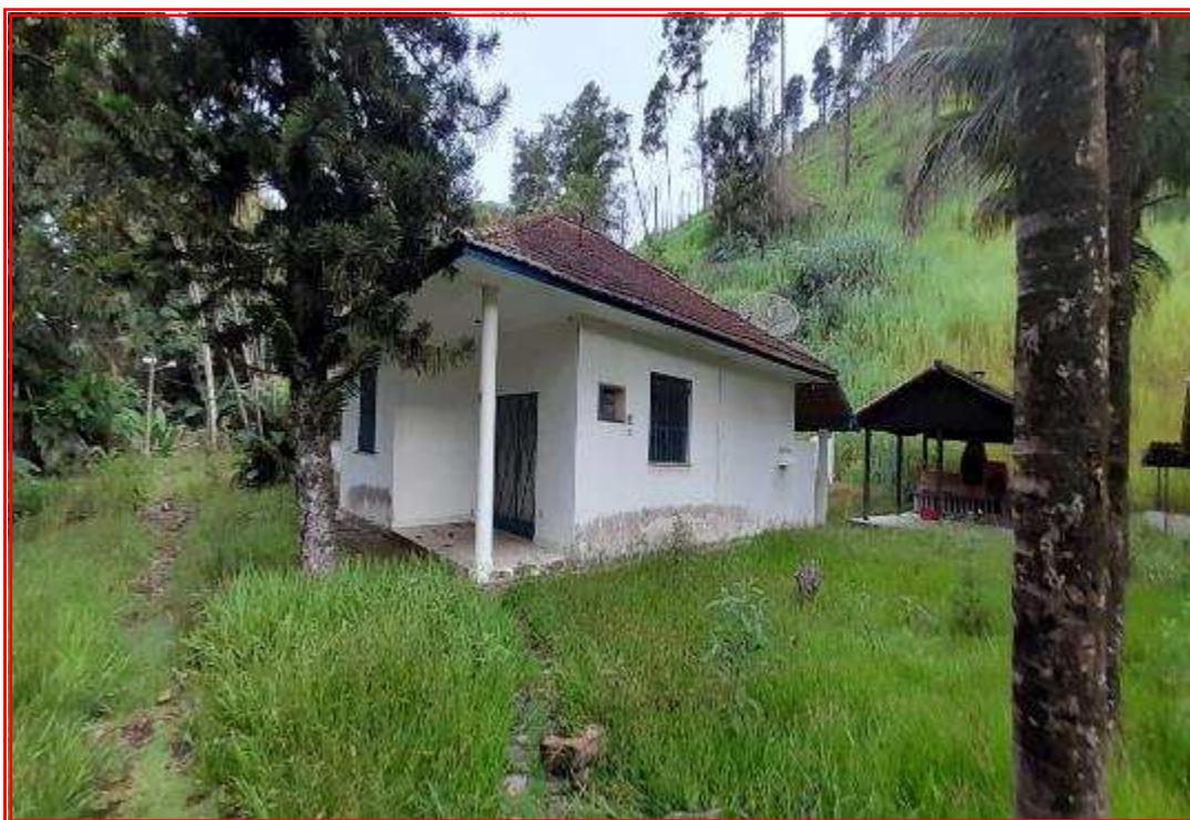
Foto nº 154: Vista geral da fachada da casa 07.
