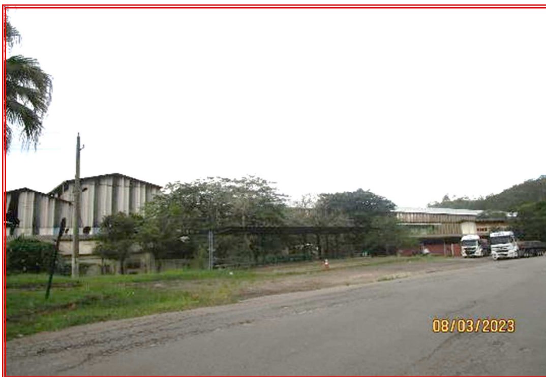
Foto nº 42: Vista da área de espera e estacionamento de caminhões.
