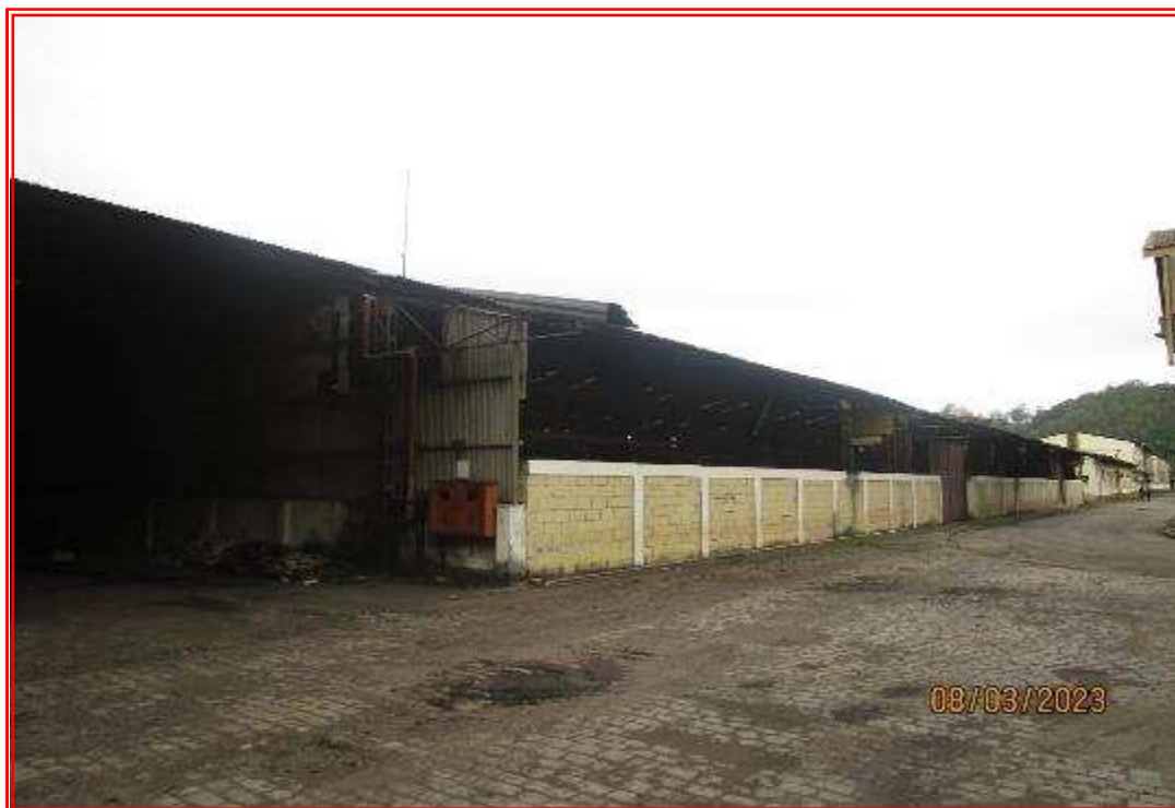
Foto nº 106: Vista geral da construção destinada a depósito de modelos com acesso pela Rua 5.
