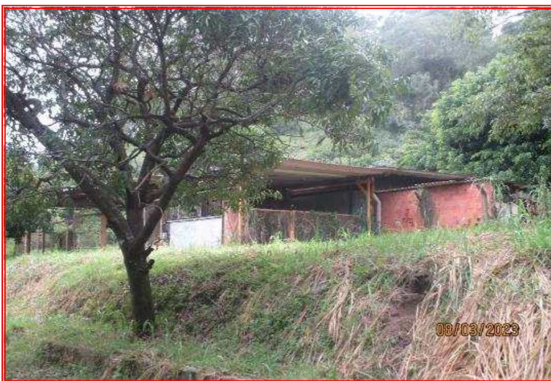
Foto nº 88: Detalhe para a manutenção civil.
