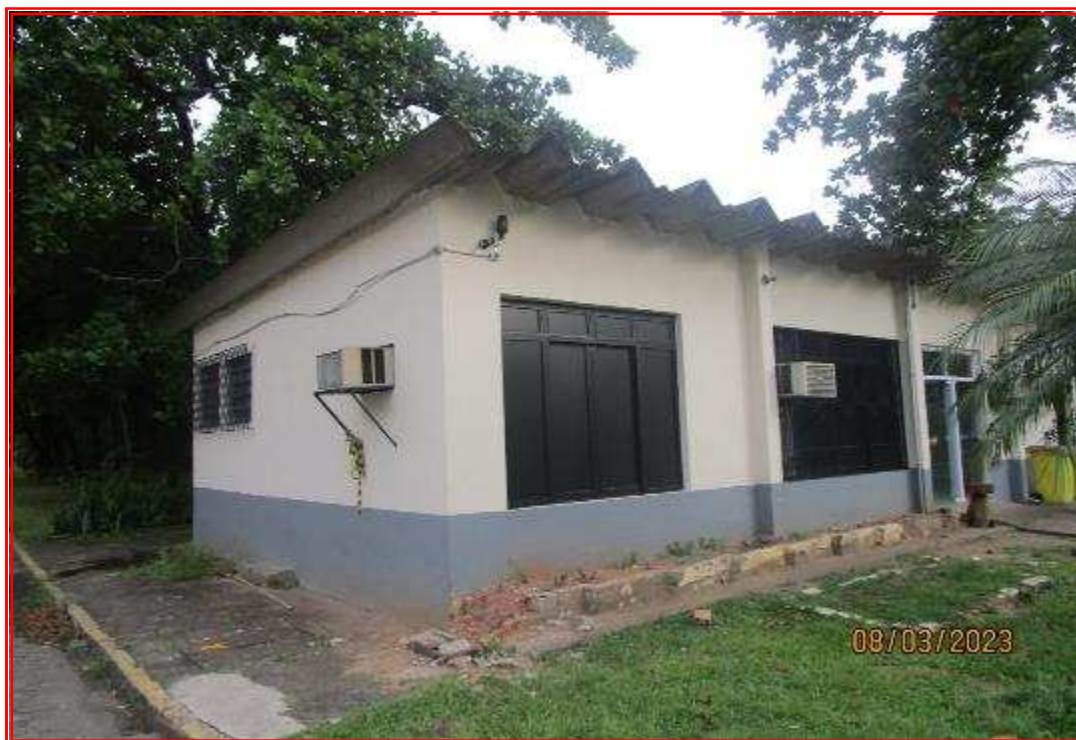
Foto nº 138: Vista geral da construção destinada ao antigo departamento de compras.
