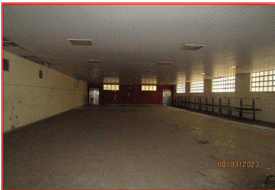
Foto nº 74: Vista interna do refeitório.
