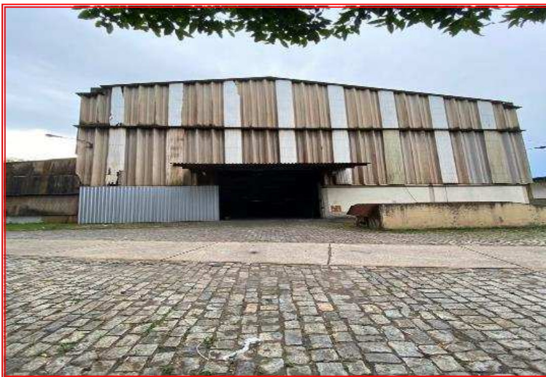
Foto nº 124: Vista do galpão ocupado pela ACSO.
