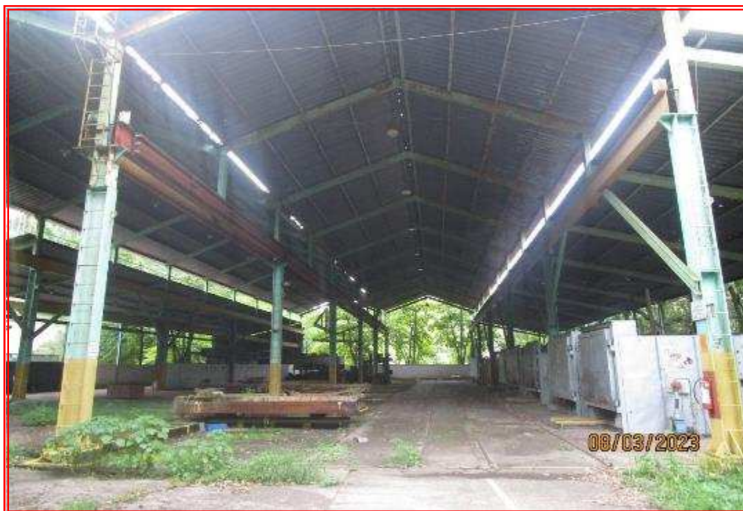
Foto nº 134: Vista do galpão destinado a tratamento térmico.
