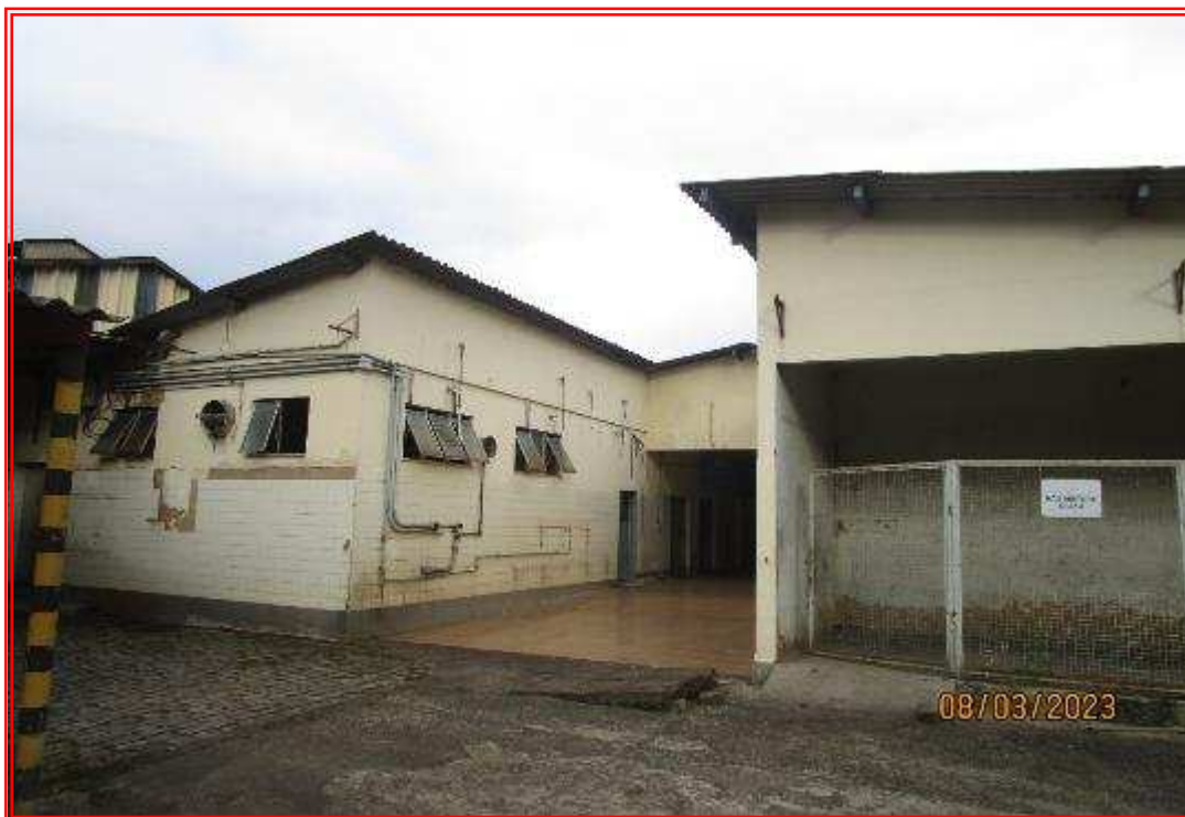
Foto nº 75: Acesso a cozinha com câmara frigorífica.
