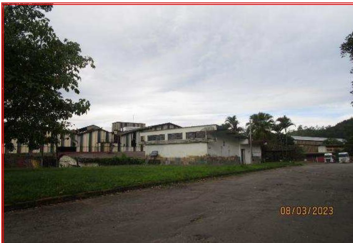
Foto nº 41: Vista da Estrada Governador Raymundo Padilha, com detalhe para o complexo industrial implantado na área objeto da avaliação descrita na matrícula nº 1.578
