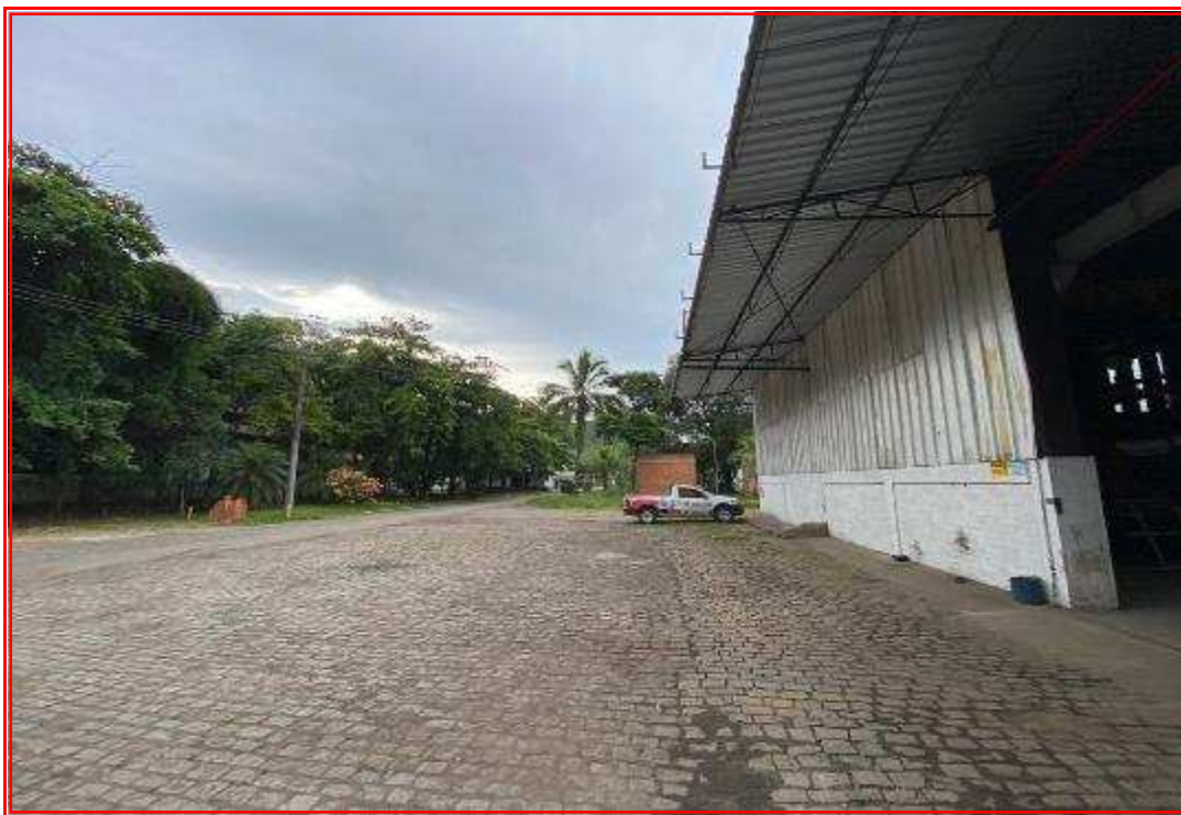
Foto nº 125: Vista geral da Rua 1 com detalhe para o pátio de manobra e galpão (fábrica 1) atualmente ocupado pela empresa ACSO.
