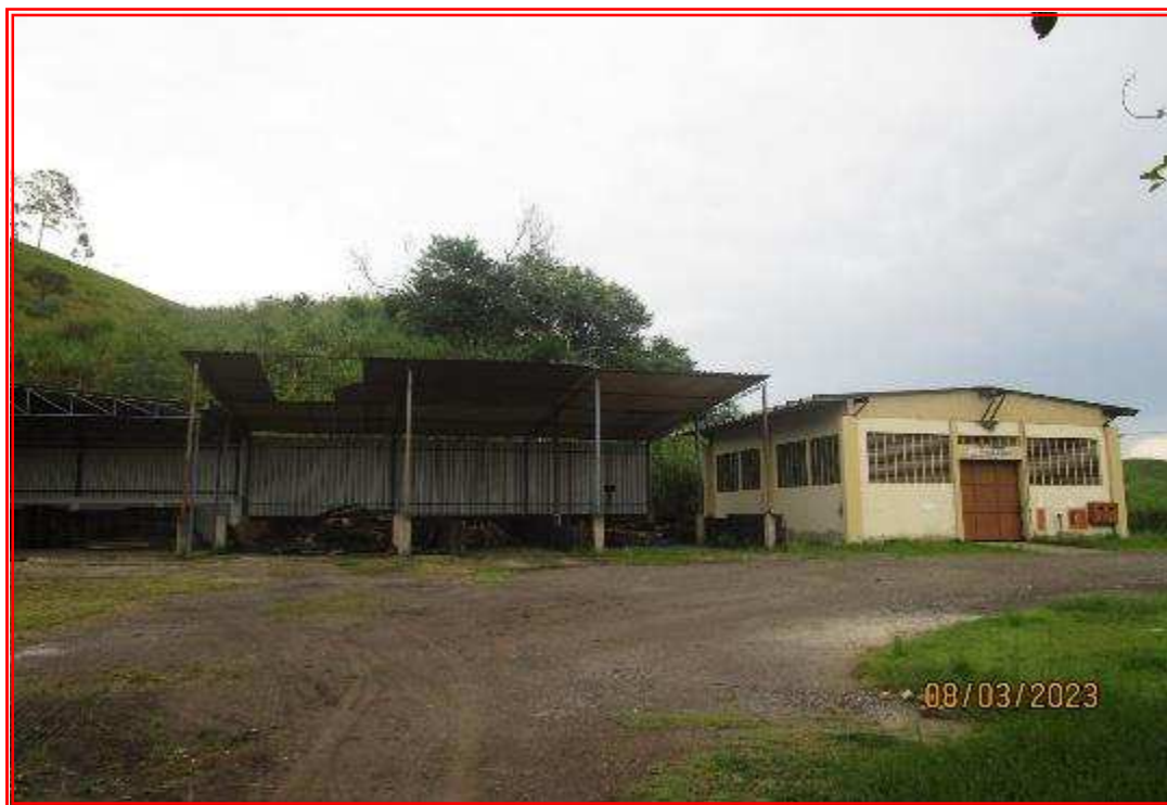
Foto nº 99: Vista das construções anexas.
