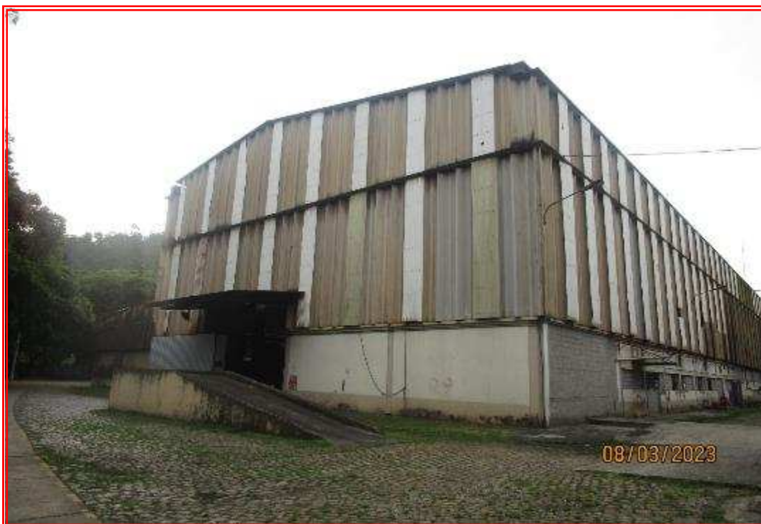
Foto nº 123: Vista geral do antigo galpão da expedição e de acabamento I, ocupado atualmente pela empresa ACSO.
