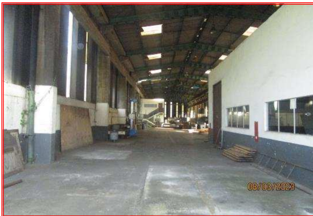
Foto nº 111: Vista interna da construção anterior.
