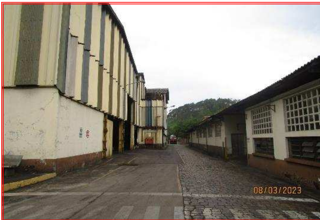
Foto nº 87: Vista geral da rua 1, onde se observa a antiga fábrica 1.
