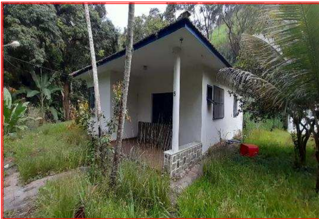
Foto nº 153: Vista parcial da fachada da 05.
