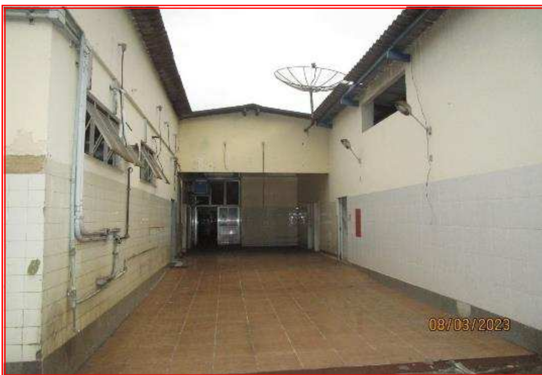
Foto nº 76: Acesso a cozinha e áreas de apoio.
