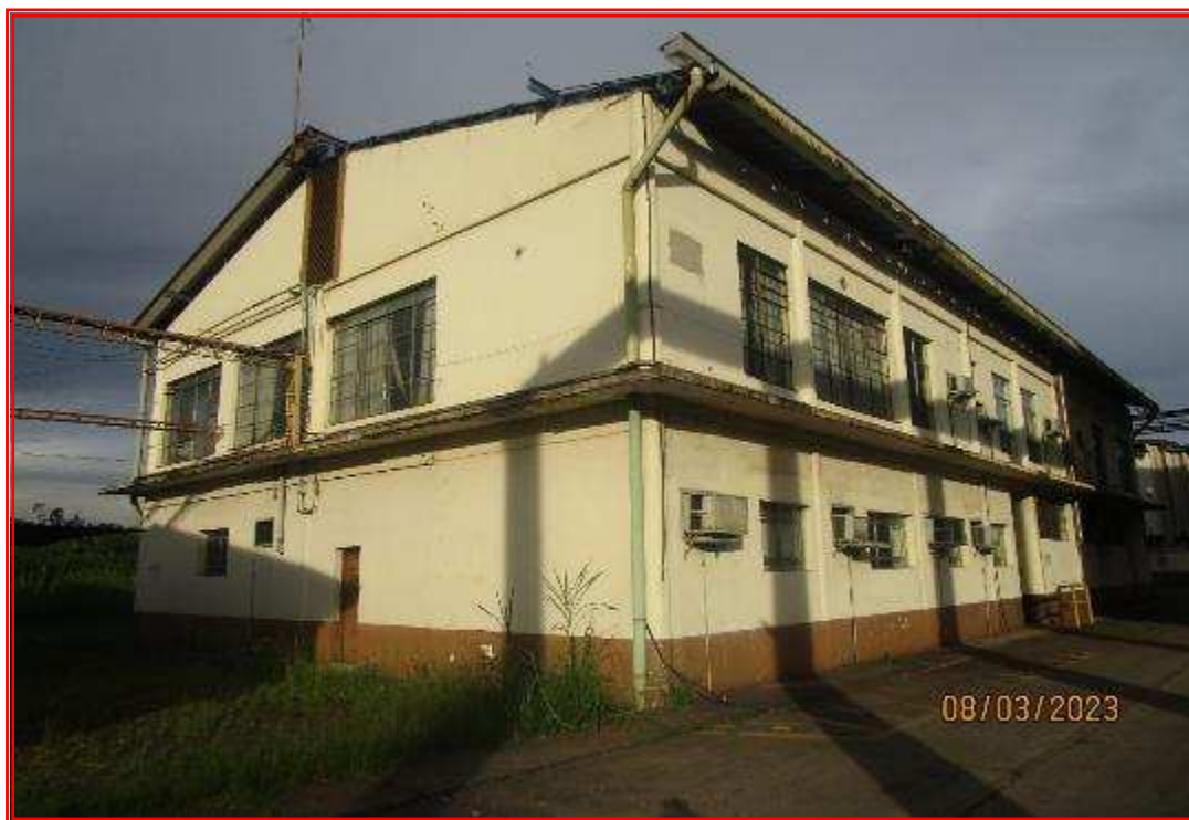
Foto nº 109: Vista geral da construção destinada a antiga administração.
