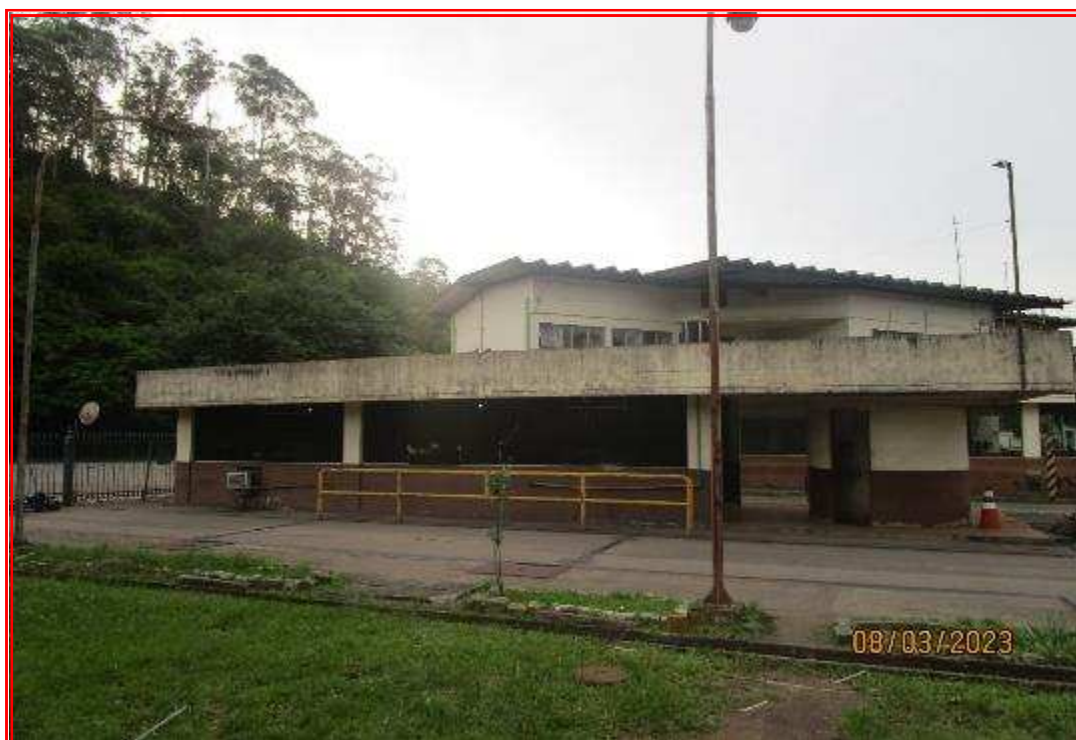
Foto nº 141: Detalhe para a recepção e balança rodoviária.
