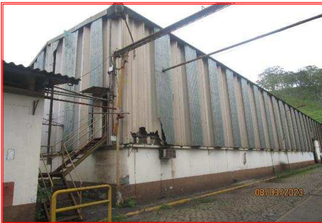
Foto nº 84: Vista externa do galpão da mecânica elétrica.
