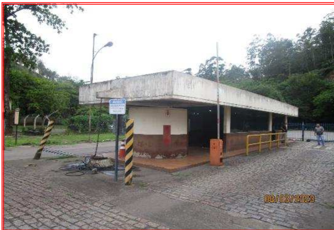
Foto nº 142: Vista geral da balança rodoviária.
