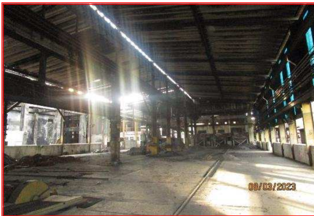
Foto nº 115: Vista interna da construção anterior.
