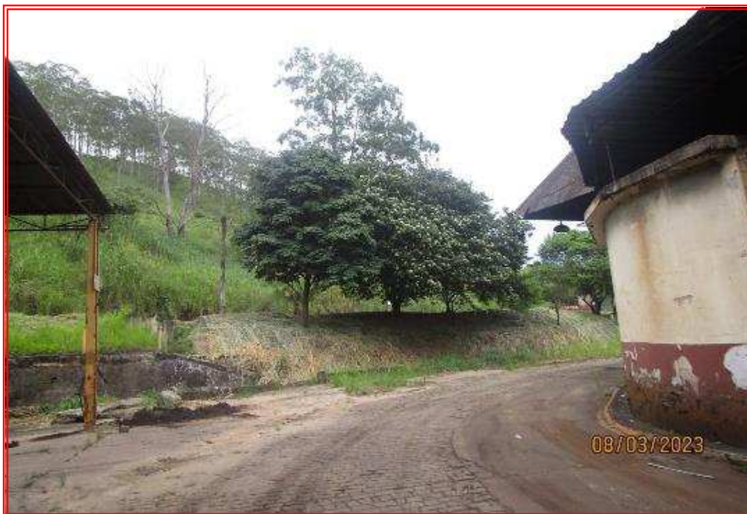
Foto nº 93: Vista da Rua 8 e área remanescente aos fundos.
