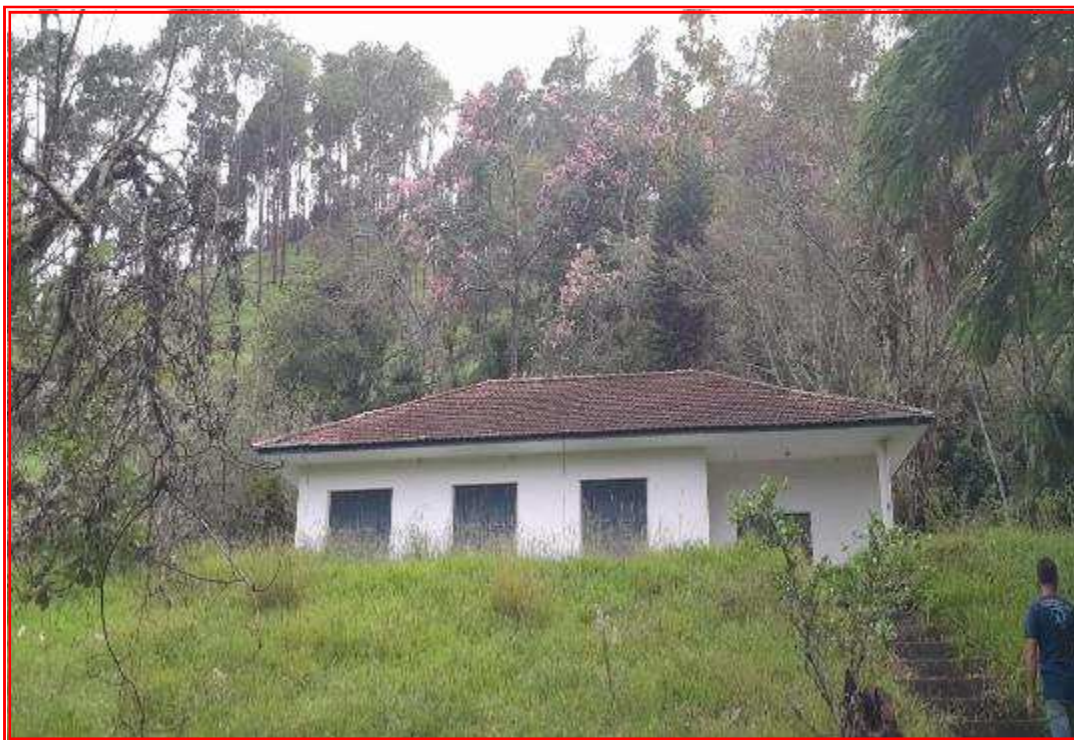
Foto nº 152: Vista geral da casa 05 da vila gerência.
