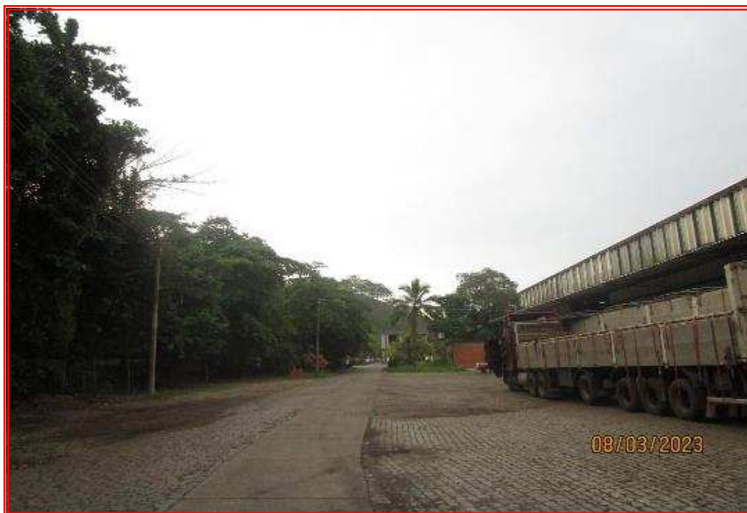
Foto nº 132: Vista da Rua 1 com detalhe para o pátio de manobra e galpão (fábrica 1) atualmente ocupado pela empresa ACSO.
