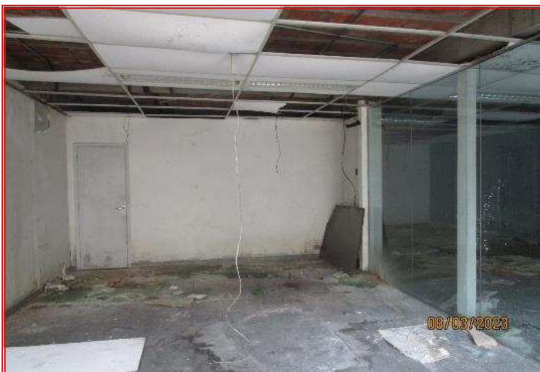
Foto nº 70: Vista interna do prédio.
