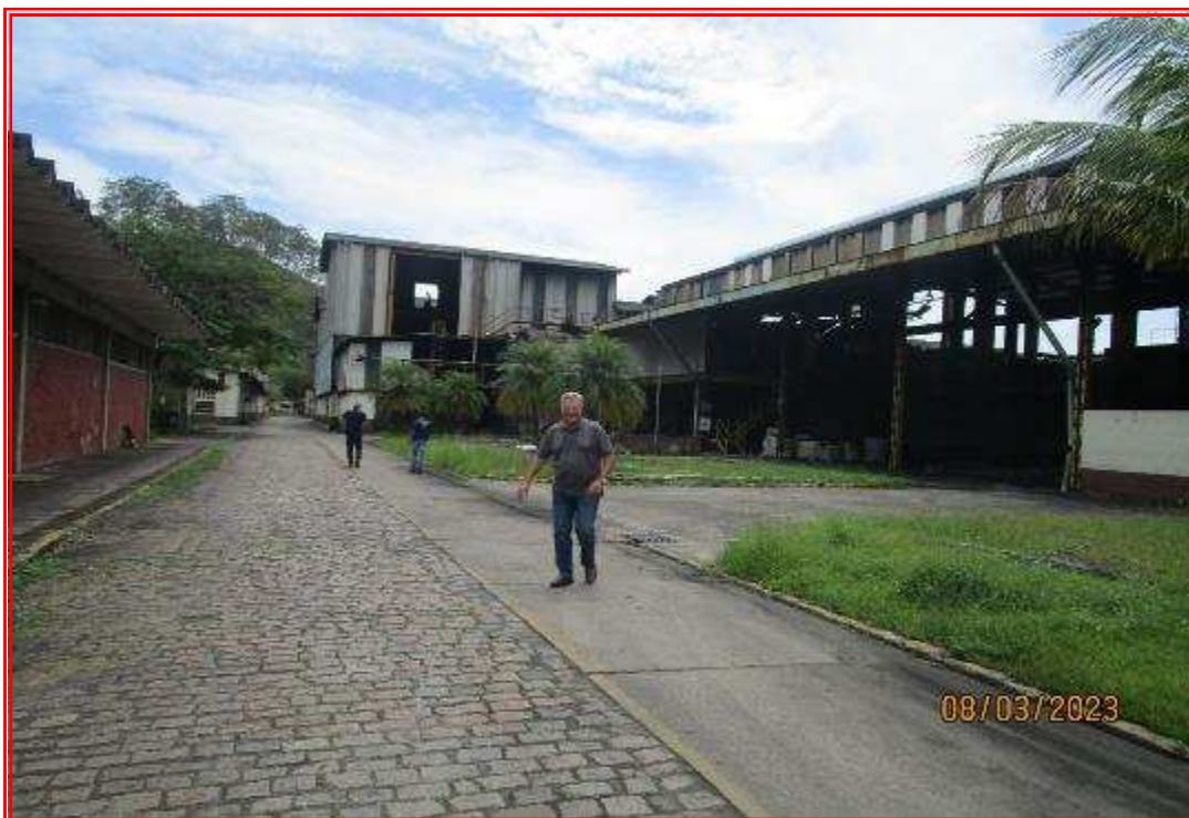
Foto nº 64: Vista da Rua 1 com detalhe para o pátio de manobra e galpão (fábrica 1) atualmente ocupado pela empresa ACSO.
