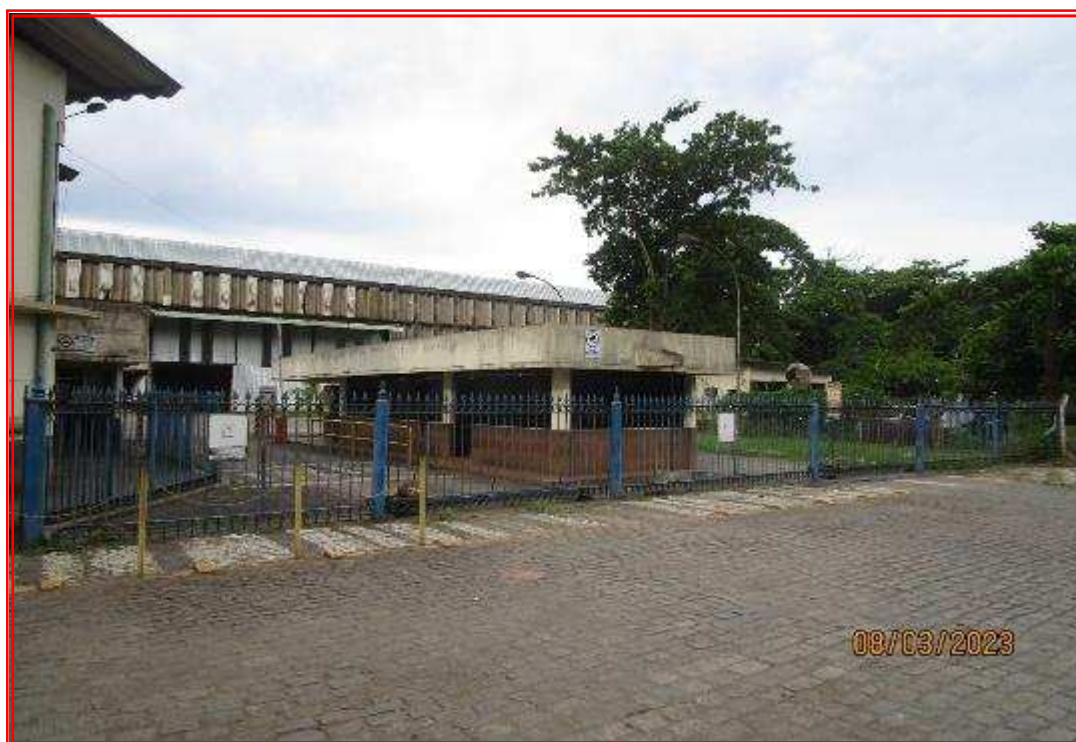
Foto nº 52: Detalhe para a portaria central de controle com balança rodoviária.
