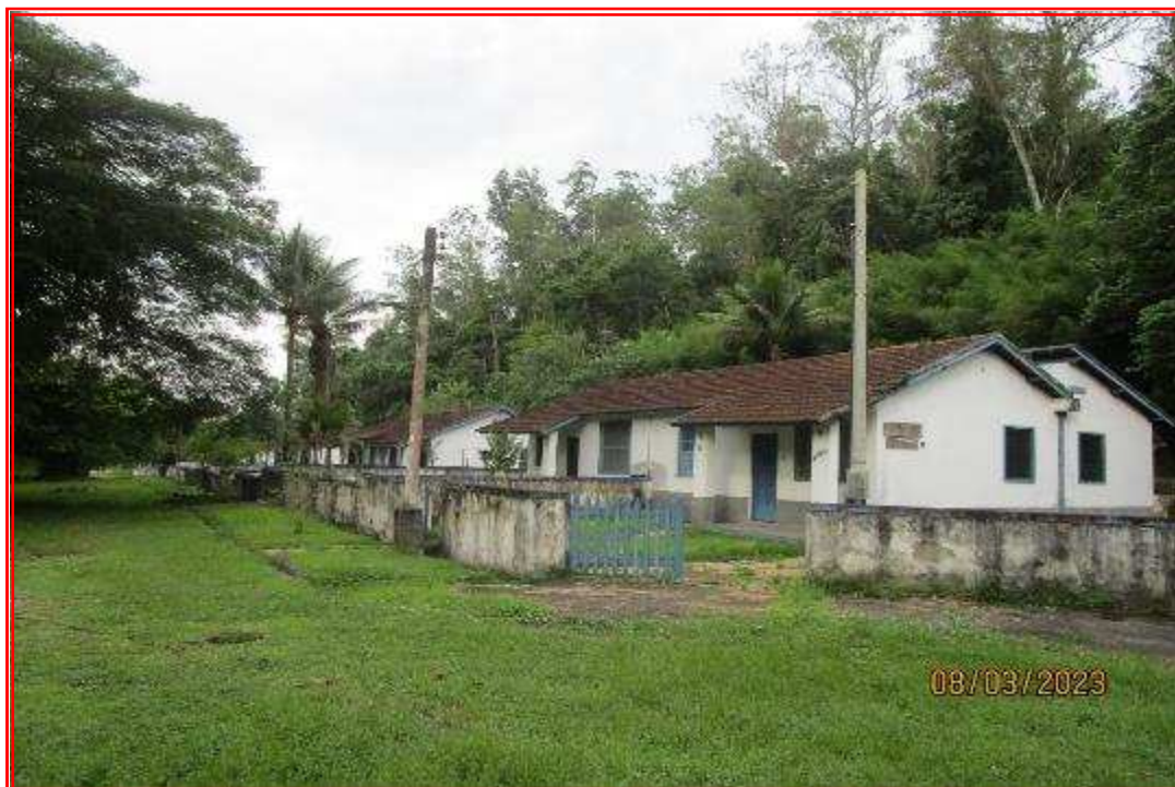
Foto nº 36: Detalhe para a via de acesso as casas.
