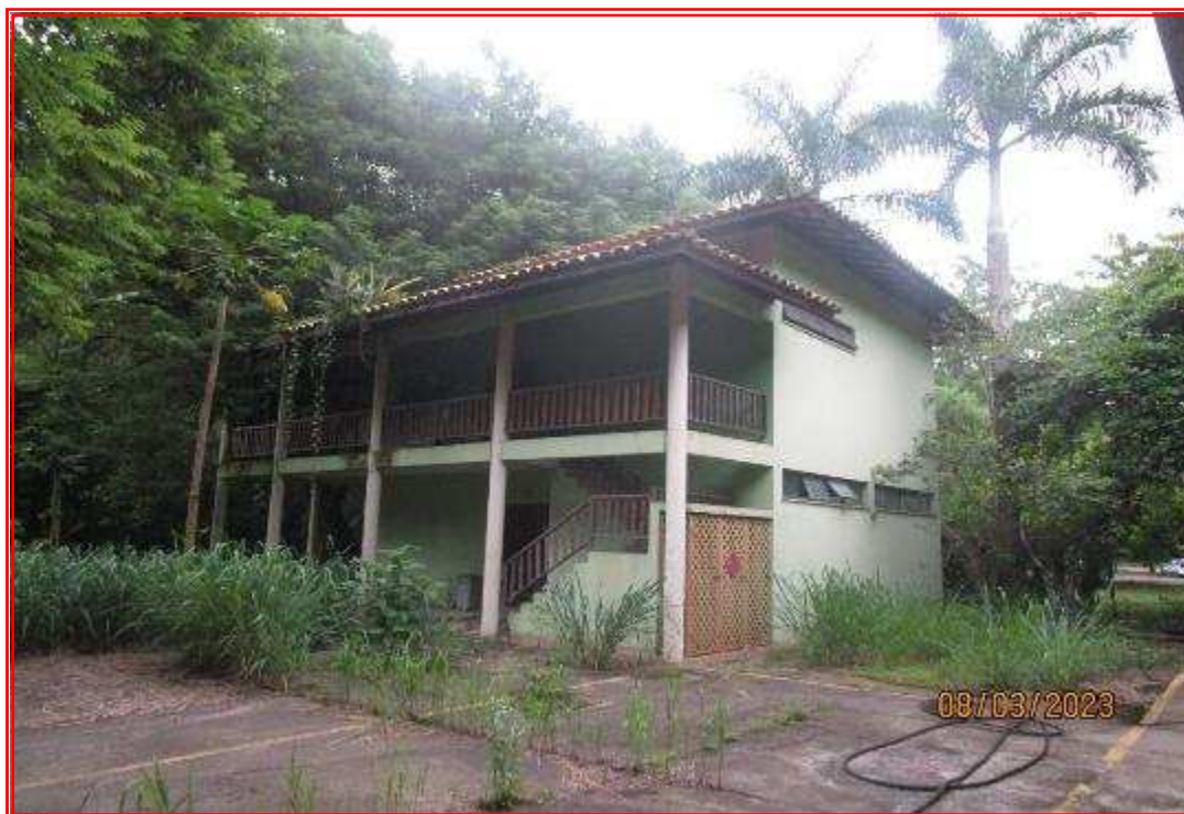
Foto nº 136: Vista geral do sobrado destinado ao antigo refeitório e vestiário da empresa AUSTEN.
