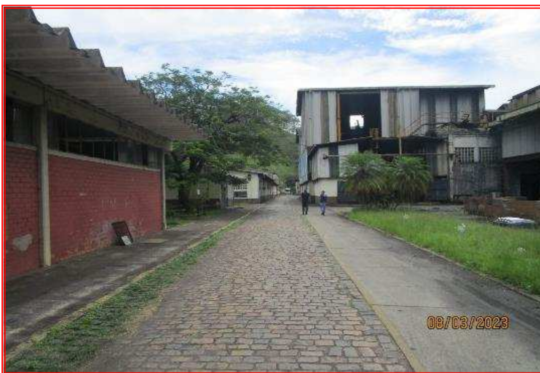
Foto nº 68: Rua 1 com detalhe para o antigo prédio (instituição financeira) e galpões da fábrica 01, à direita.
