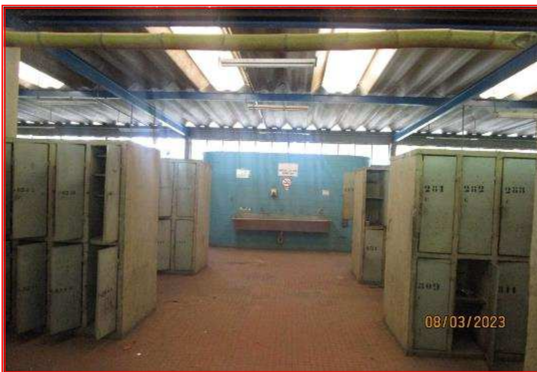
Foto nº 66: Vista interna do vestiário.
