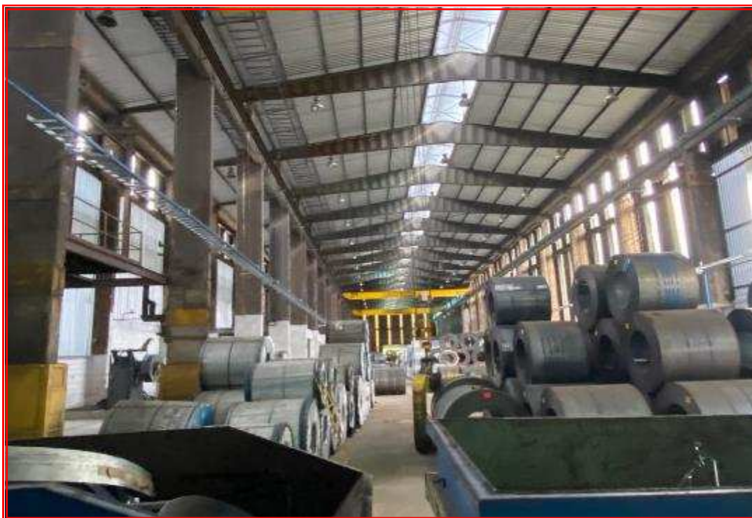
Foto nº 127: Vista interna do galpão ocupado pela ACSO.
