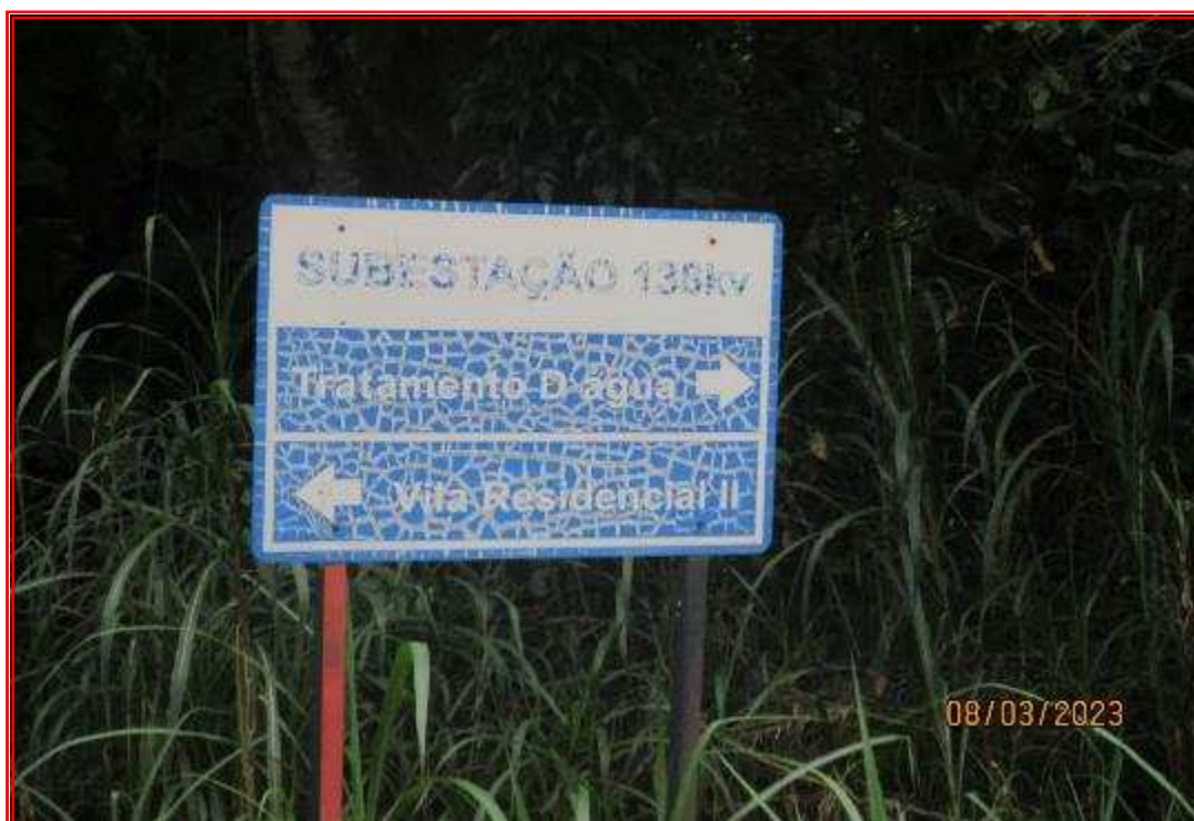
Foto nº 147: Vista da placa de identificação de acesso a Subestação.
