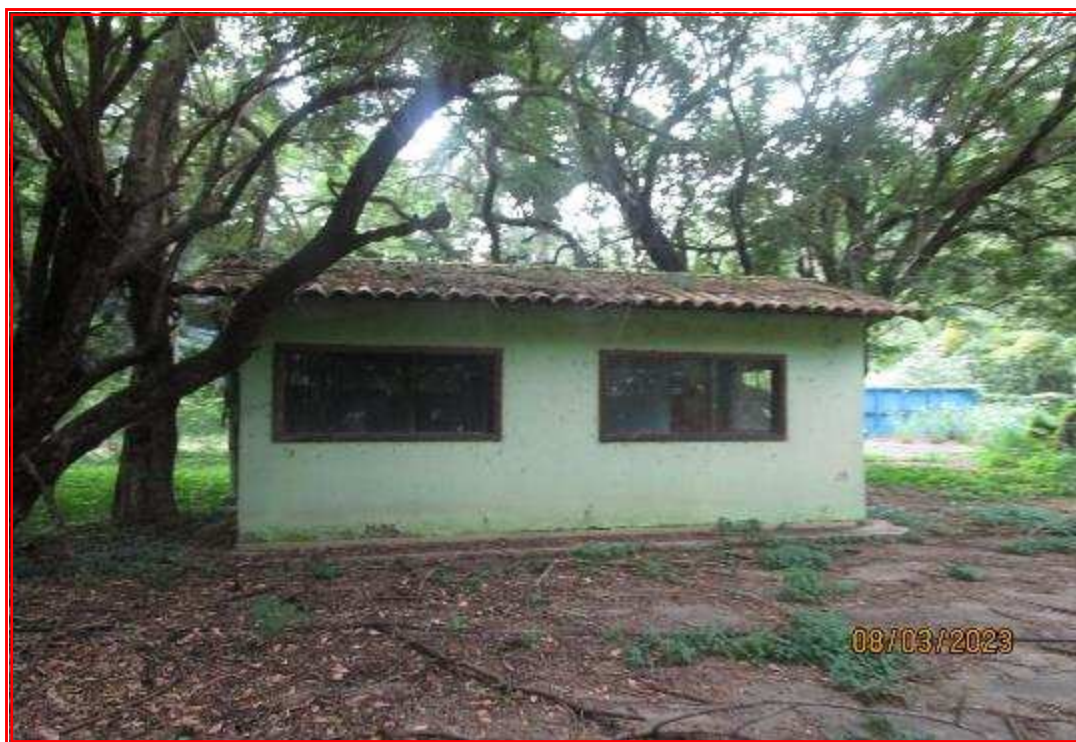
Foto nº 135: Vista do antigo escritório.
