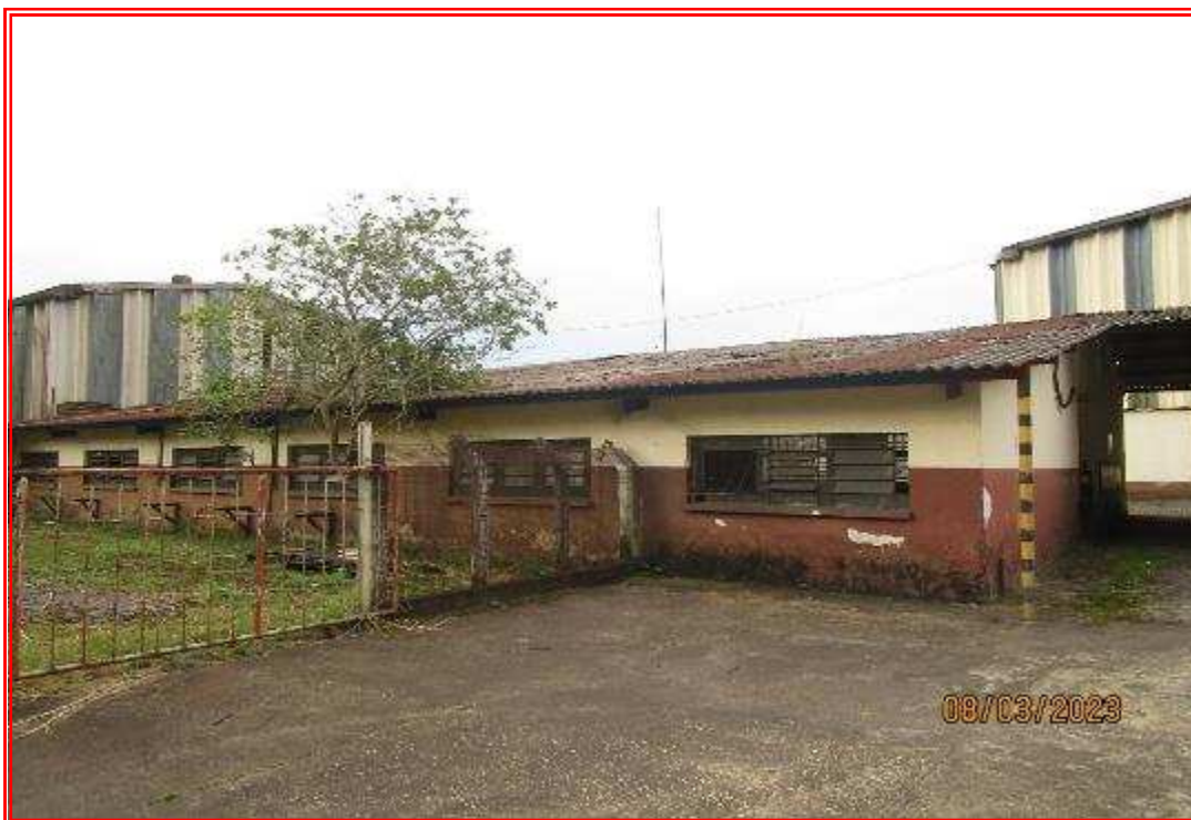
Foto nº 80: Vista externa do almoxarifado central.
