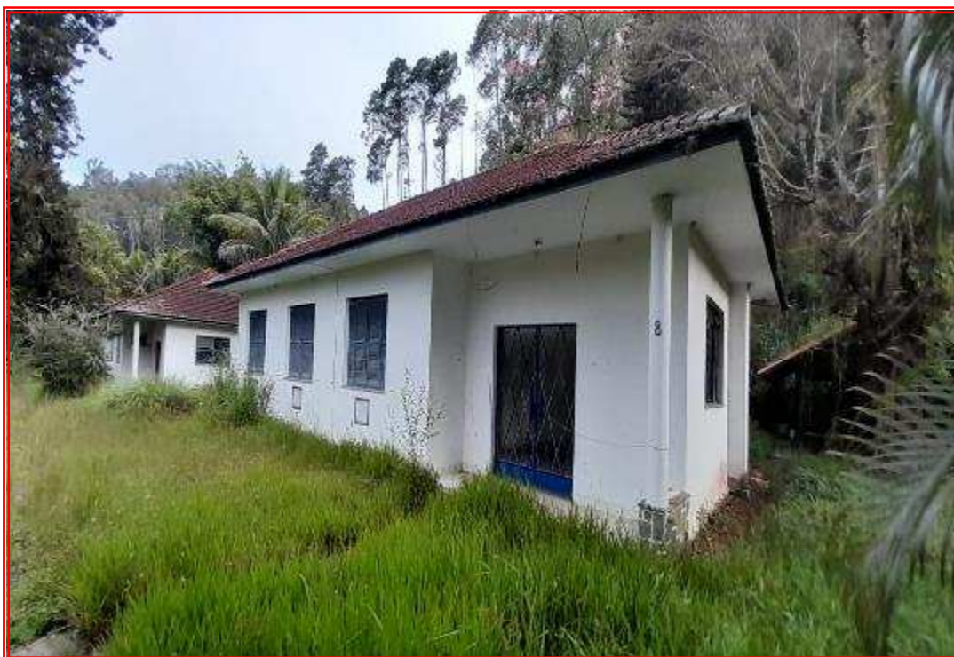
Foto nº 156: Vista parcial da fachada da casa 08.
