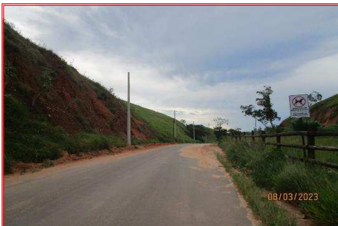
Foto nº 02: Vista da Estrada Governador Raymundo Padilha, que dá acesso ao imóvel, com detalhe para o início da área que foi seccionada com a implantação da malha viária conforme consta na planta da fazenda.
