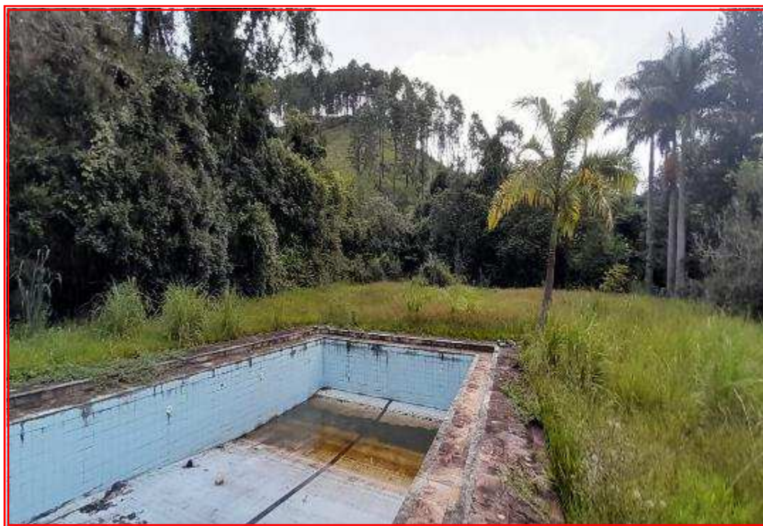
Foto nº 162: Vista geral da piscina desativada e área remanescente aos fundos.
