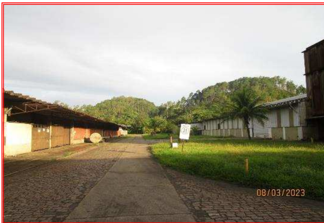
Foto nº 117: Vista geral da Rua 5, com detalhe para a área remanescente aos fundos.
