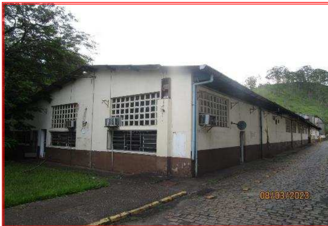
Foto nº 71: Vista externa do refeitório.
