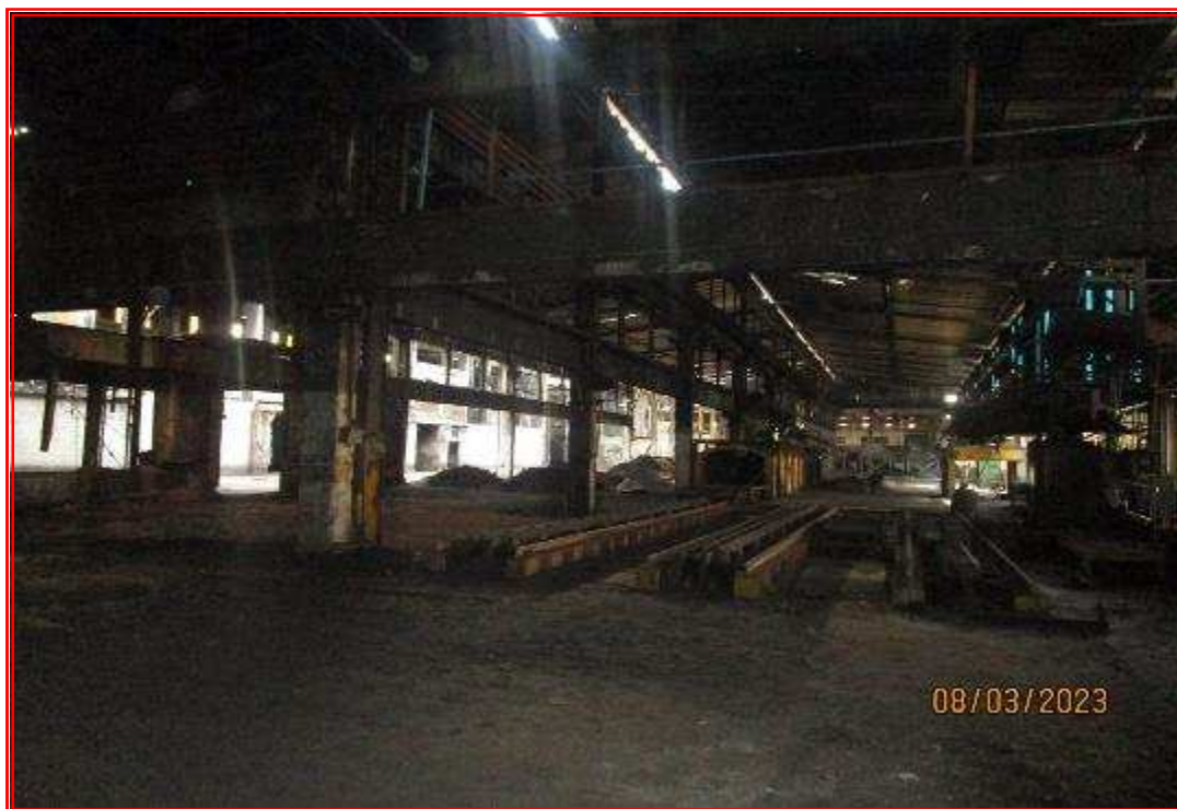
Foto nº 114: Vista interna da antiga fábrica 1 - Grupo 81.
