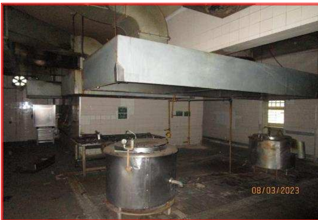
Foto nº 78: Vista interna da cozinha.
