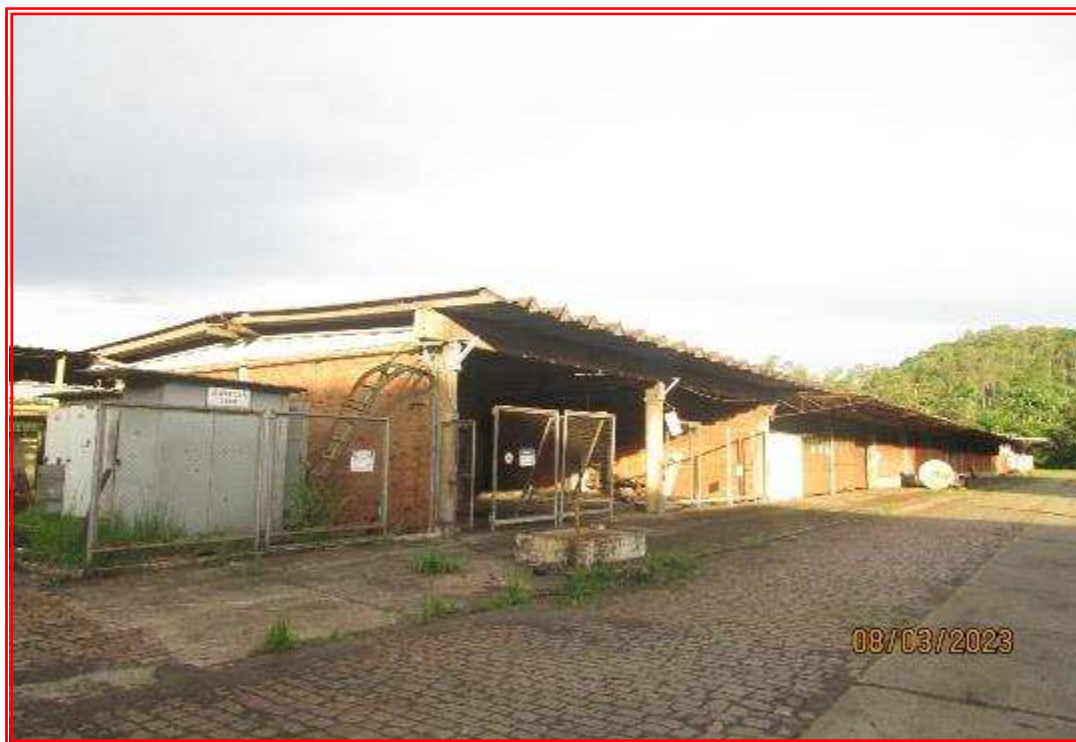
Foto nº 118: Vista geral da construção do antigo almoxarifado.
