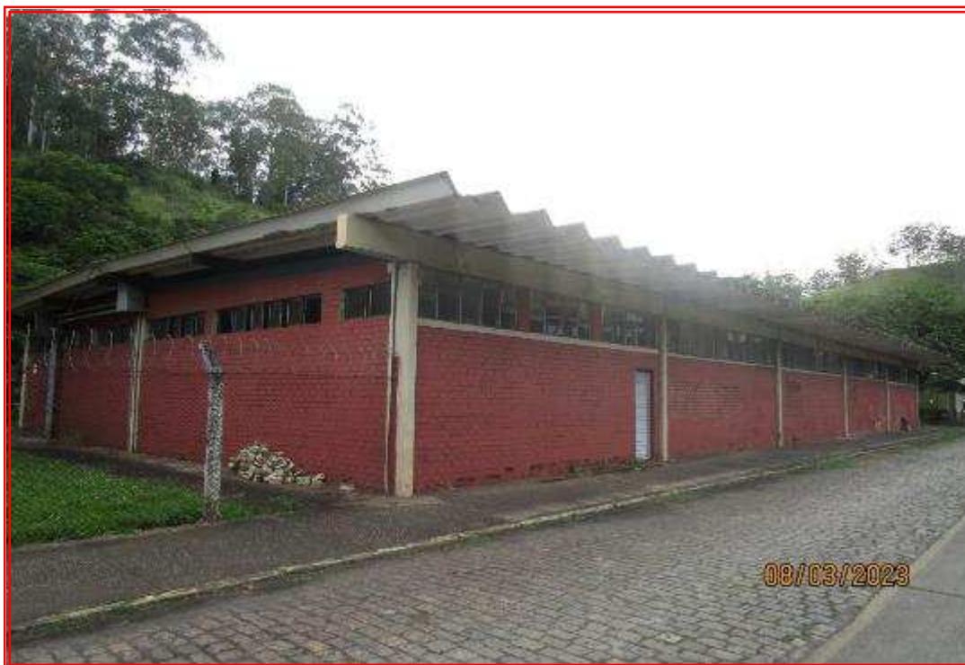
Foto nº 65: Vista externa do vestiário.
