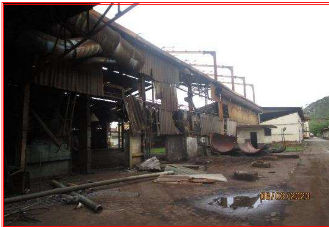
Foto nº 91: Detalhe para a fábrica 2 (antigo acabamento III e Virabrequins).
