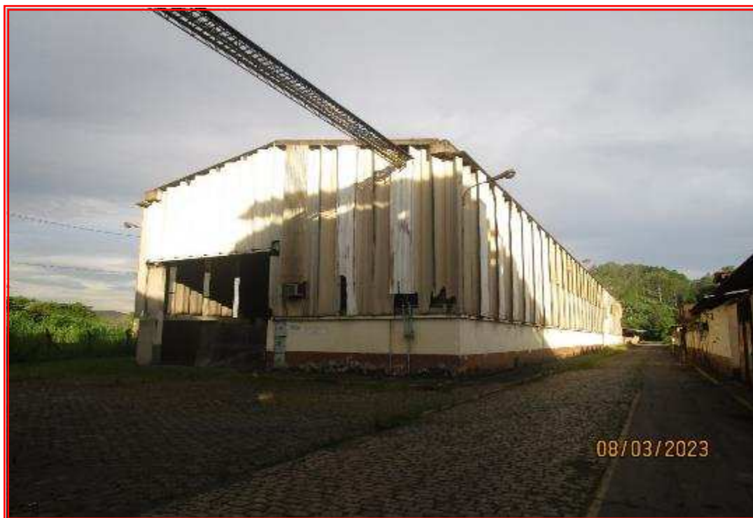
Foto nº 110: Vista geral da antiga construção destinada a modelação.
