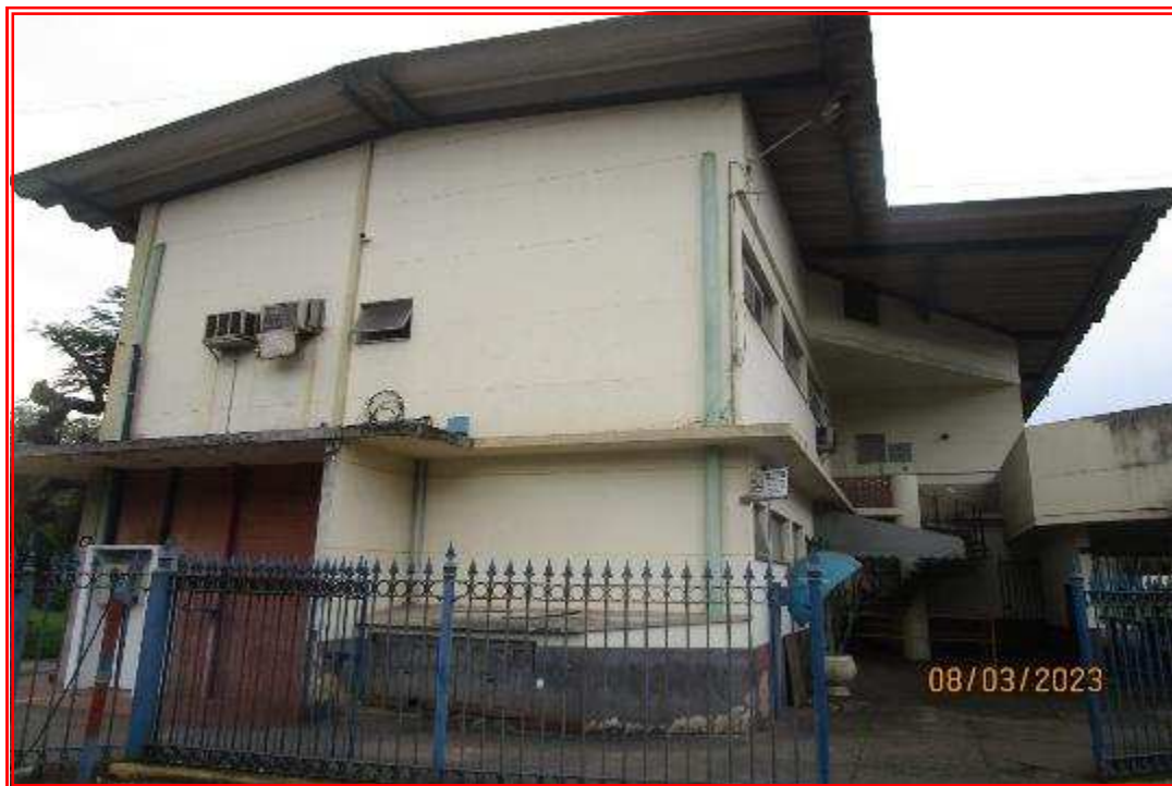
Foto nº 54: Vista externa do prédio administrativo (relações industriais e vendas).
