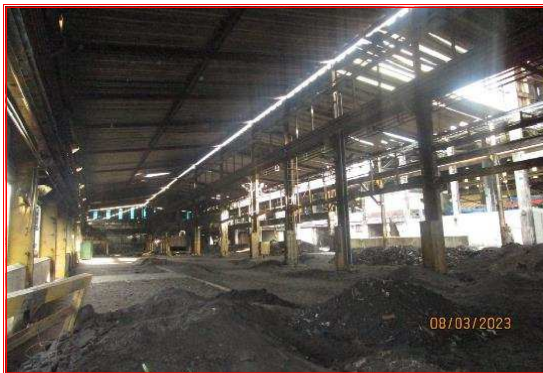
Foto nº 116: Outra vista geral da construção anterior.
