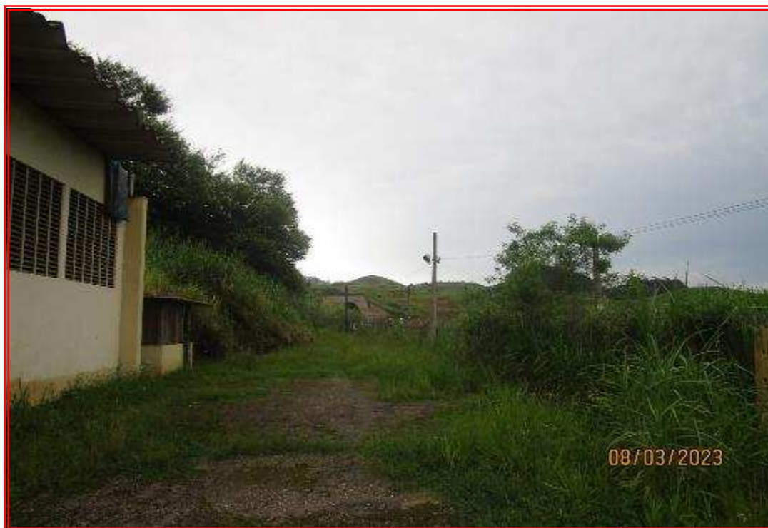
Foto nº 100: Vista da lateral da área que confronta com a linha férrea.
