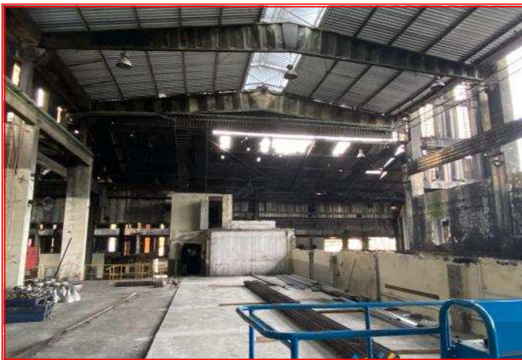
Foto nº 130: Vista interna do galpão ocupado pela ACSO.
