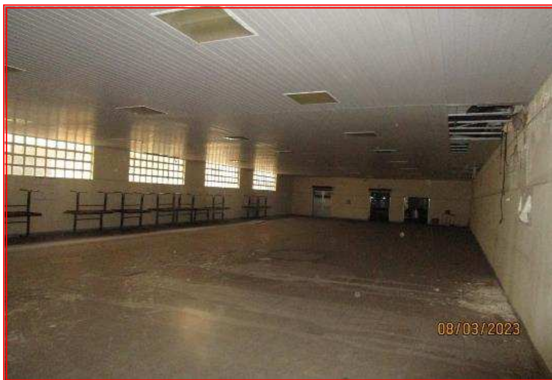
Foto nº 73: Vista interna do refeitório.
