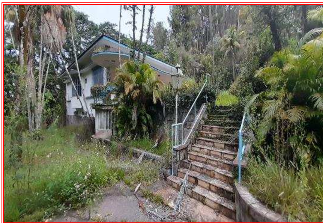
Foto nº 161: Vista geral do acesso.
