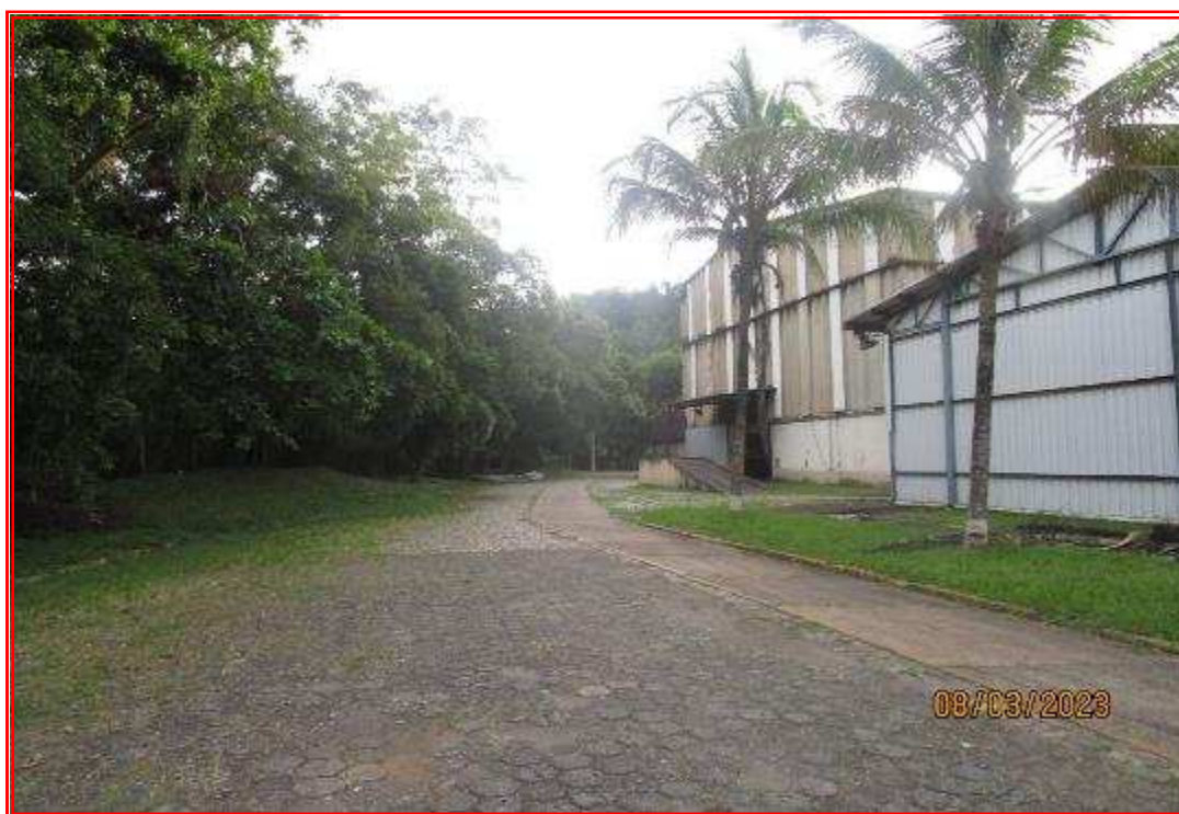
Foto nº 121: Vista da Rua 2, antigos galpões destinados aos acabamentos I, II e expedição.
