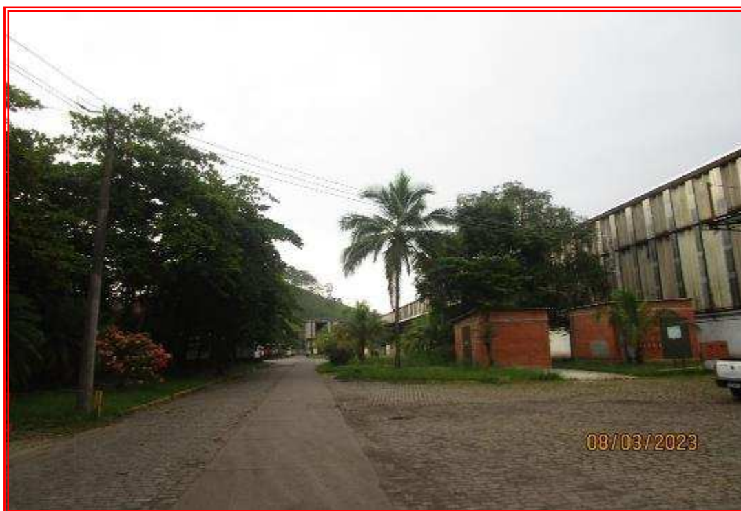
Foto nº 137: Vista da Rua 1 em direção a portaria central.
