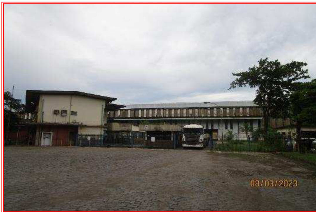
Foto nº 51: Vista geral da portaria central e prédio administrativo (relações industriais e vendas) do complexo industrial.
