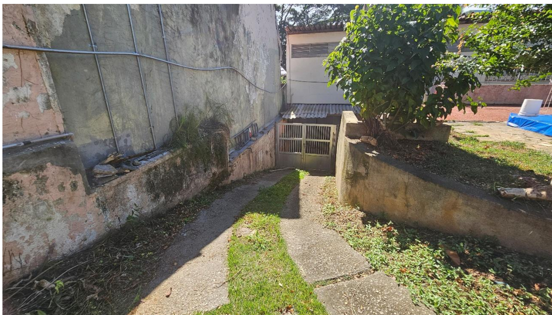
FOTO 43: Vista do acesso ao piso superior, para veículos
