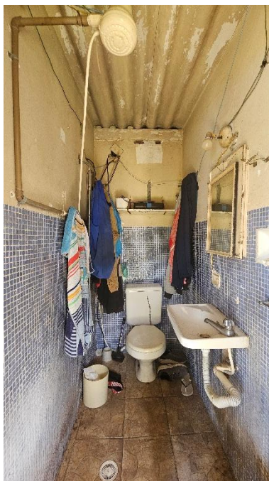
FOTO 42: Vista do banheiro na edícula superior do imóvel avaliando
