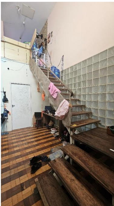
FOTO 27: Vista da escada de acesso ao piso superior do imóvel avaliando
