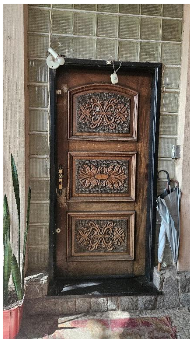
FOTO 16: Vista da porta de entrada do imóvel avaliando
