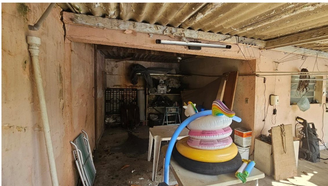
FOTO 39: Vista da garagem na edícula superior do imóvel avaliando
