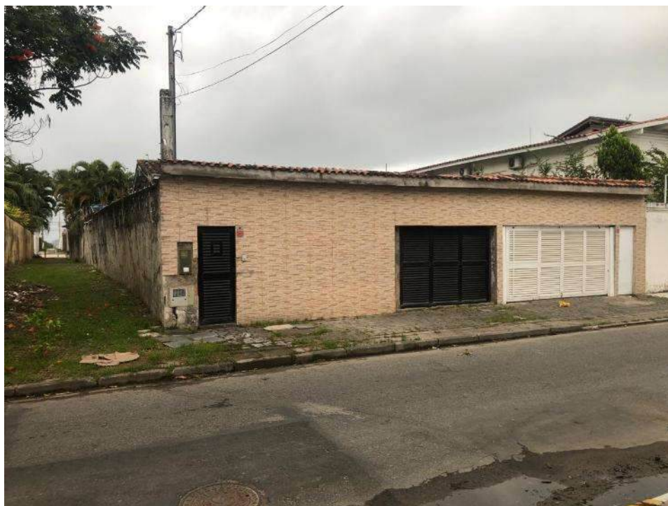
Figura 09 – Vista frontal do imóvel avaliado (Atenção a falta de prumo do muro lateral).
