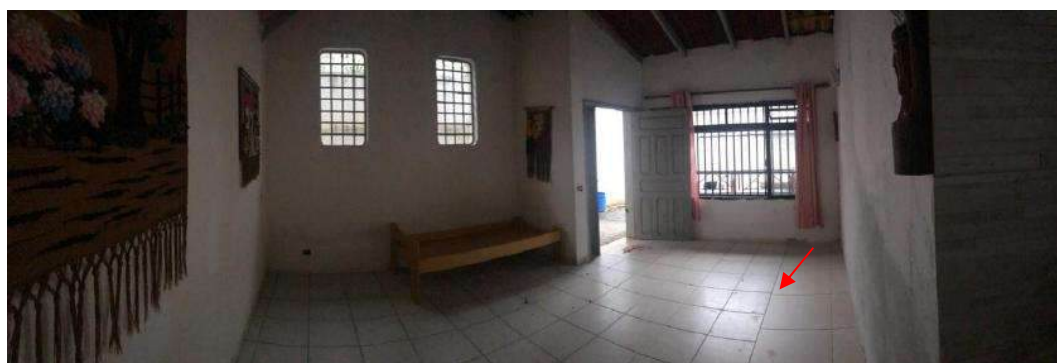
Figura 49 – Área frente, interior da casa lado portões brancos. Detalhe diferença de pisos.
