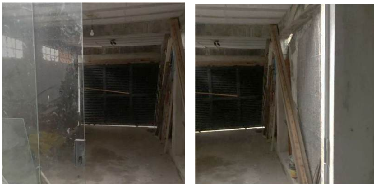
Figura 22 – Vista área da frente da casa internamente com aparente desmembramento das partes. Portão de alumínio para carros.
