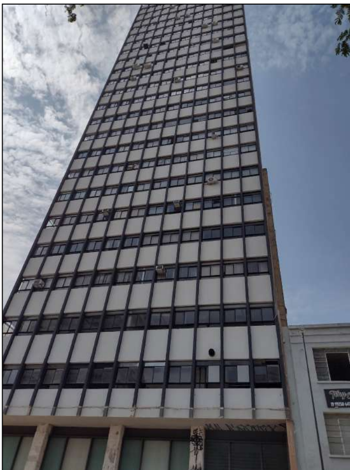
Fachada do Edifício Anhumas.
