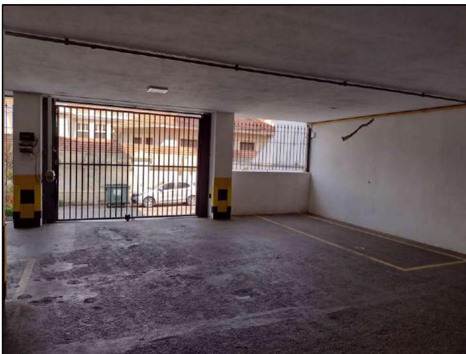
Vista da garagem.
