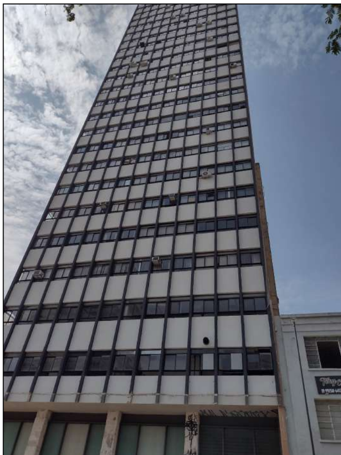
Fachada do Edifício Anhumas.
