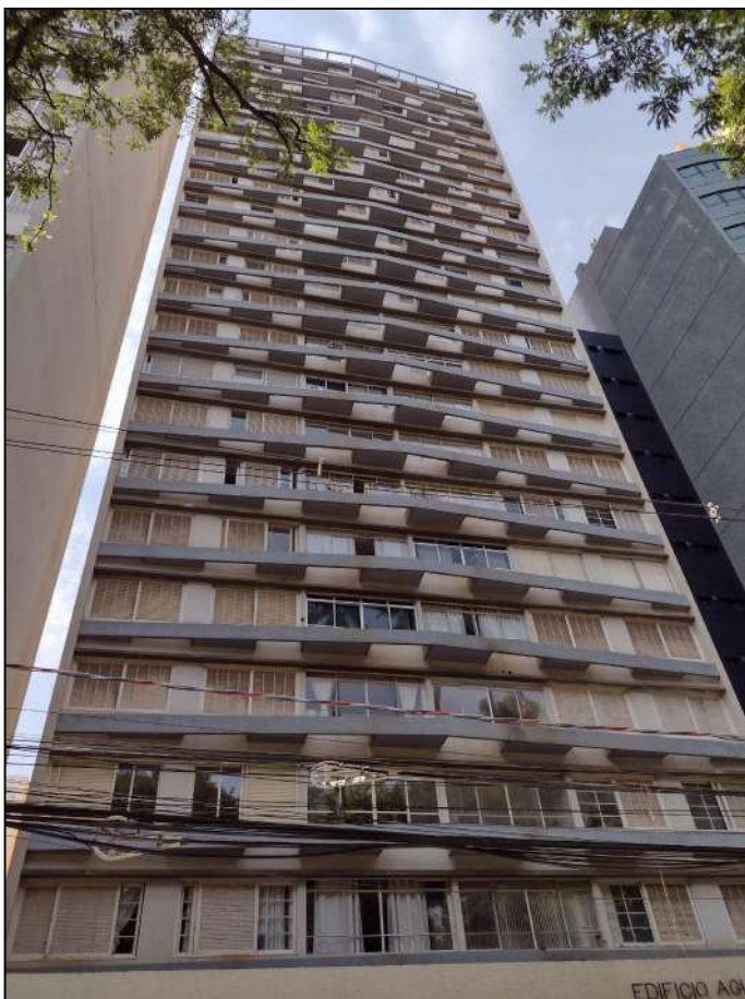
Vista da fachada principal do Edifício Agulhas Negras.
