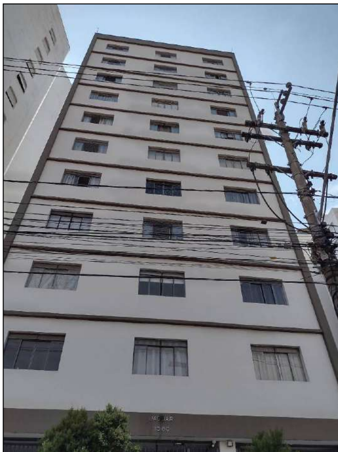
Fachada do Edifício Jaguar.
