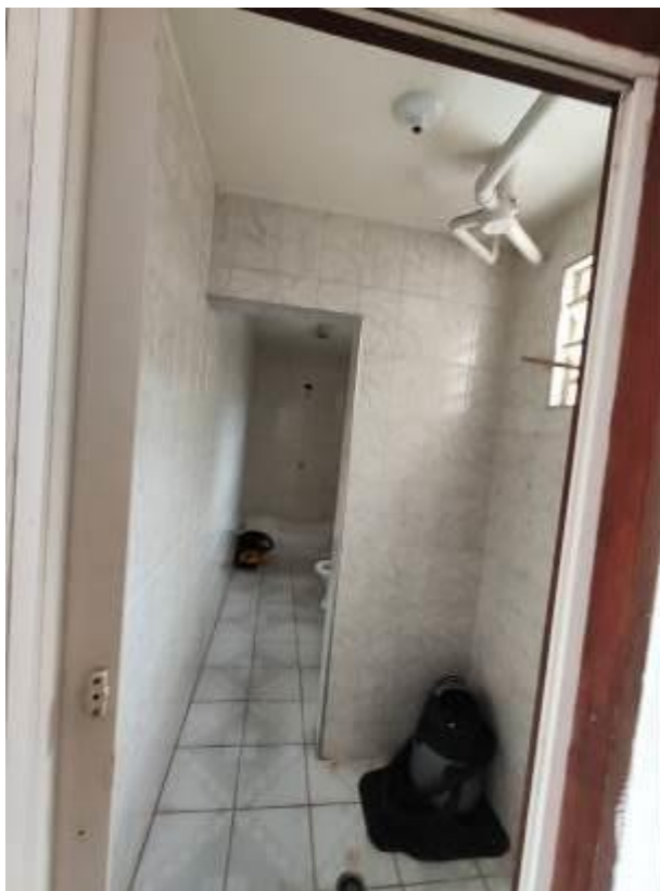
Foto 9: Vista interna do banheiro do salão comercial.
