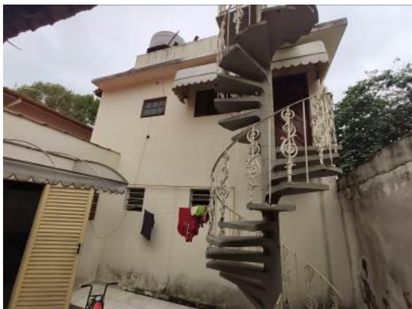
Foto 7: Vista da escada caracol de acesso ao 1.º e 2.º pavimentos.
