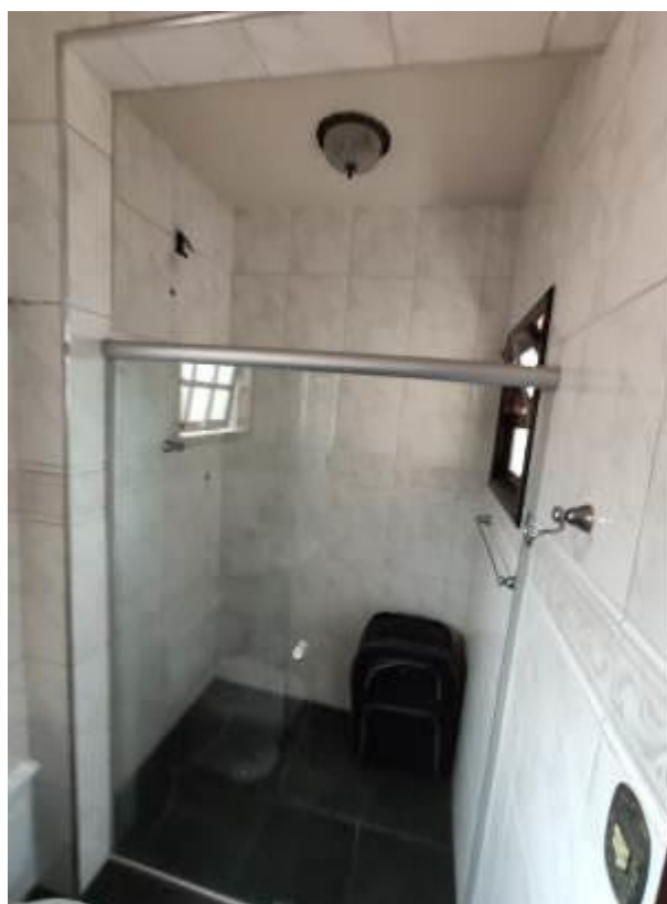
Foto 12: Vista interna do banheiro da residência do 1.º pav.
