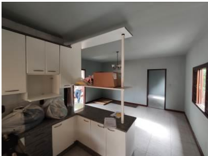
Foto 11: Vista interna da cozinha e sala da residência do 1.º pav.
