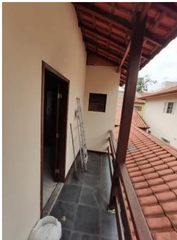
Foto 15: Vista da varanda do 1.º pav.
