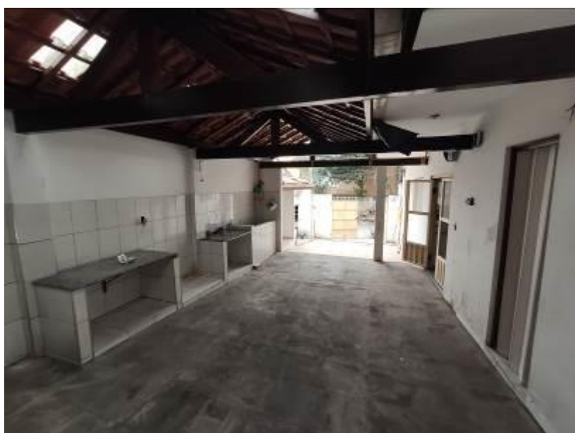
Foto 10: Vista interna da garagem.
