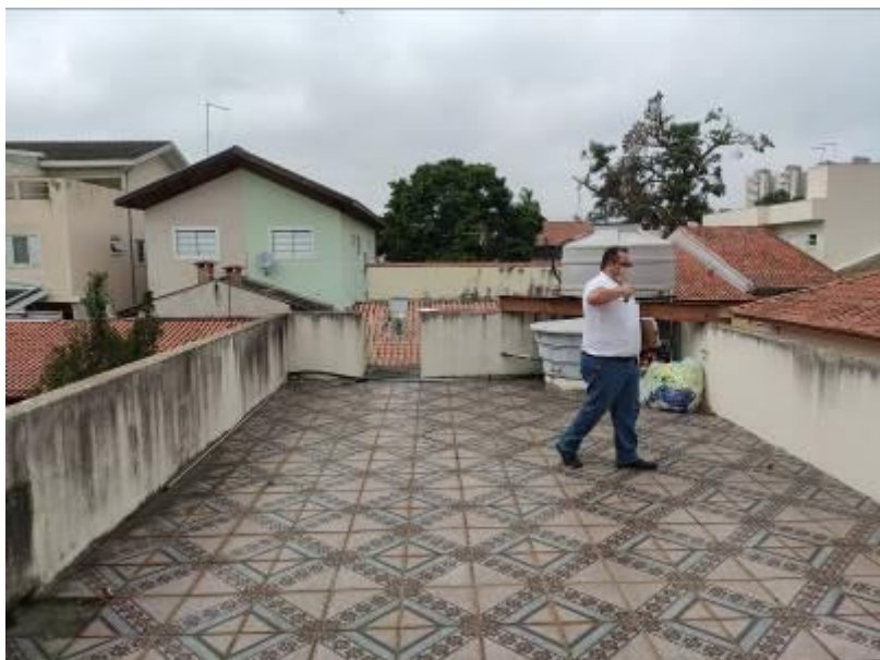
Foto 16: Vista da varanda do 2.º pav.
