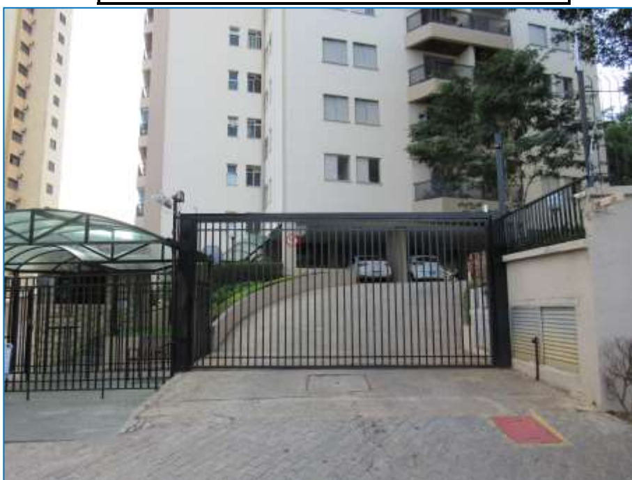
ACESSO DE VEÍCULOS.
