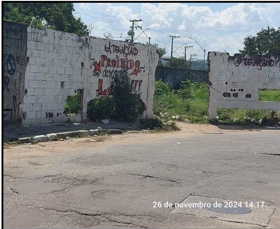
FOTO 03: Vista do terreno pela Rua José Fedrigo
