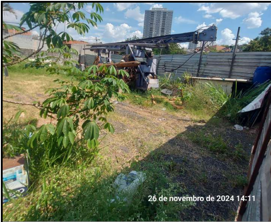
FOTO 09: Área do terreno cercada por tapume metálico
