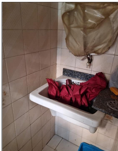
FOTO 13. Área de Serviço.
