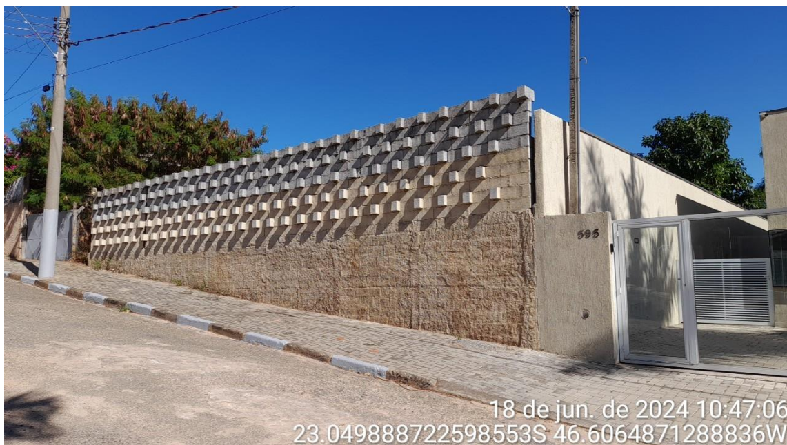
FOTO 3 – Outra vista da fachada do lote em questão, observando-se as características do muro de contenção e fechamento.
