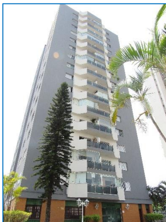
Fachada do Edifício Viviane – Bloco “B”.
