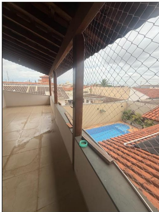
Área externa (parte superior).
