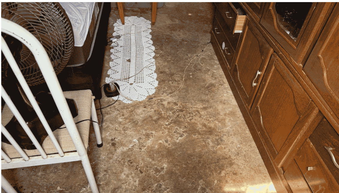
Piso em concreto em todos os ambientes
