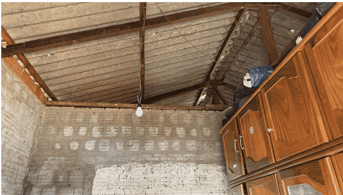
Cobertura em telhas de fibro cimento em todos os ambientes
