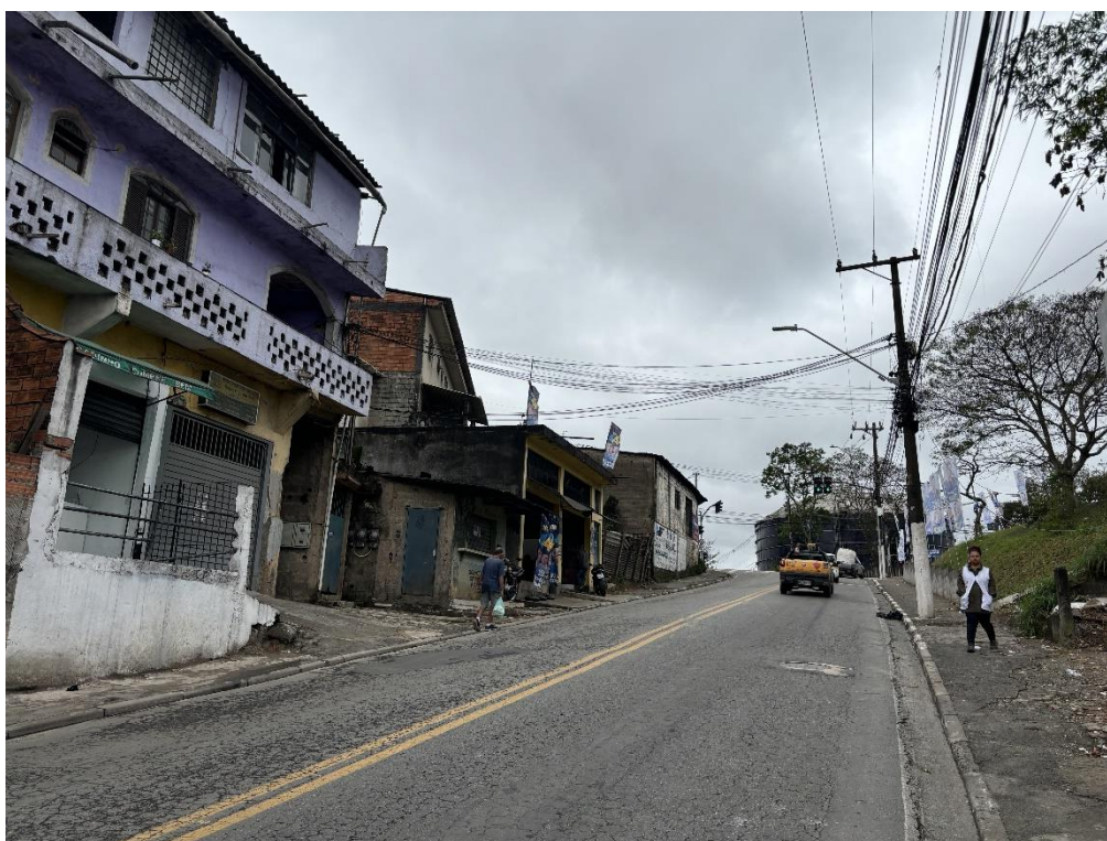
Foto nº. 1 – Vista da Estrada Comodoro, onde se localiza o imóvel avaliado no presente laudo.
