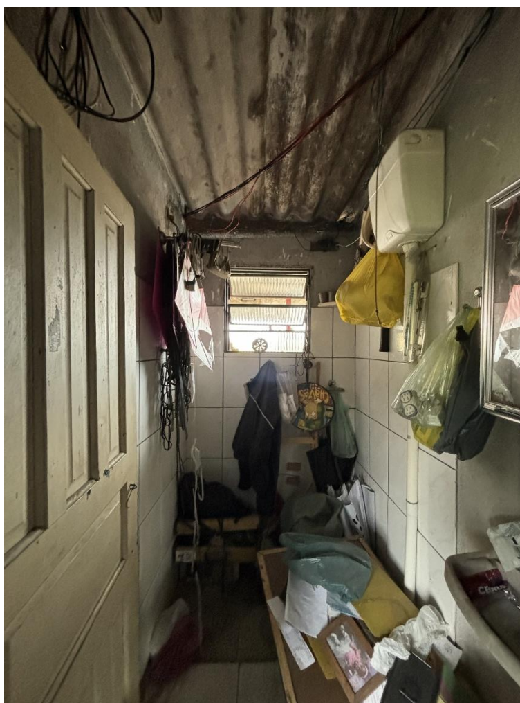
Foto nº. 23 – Vista do banheiro.
