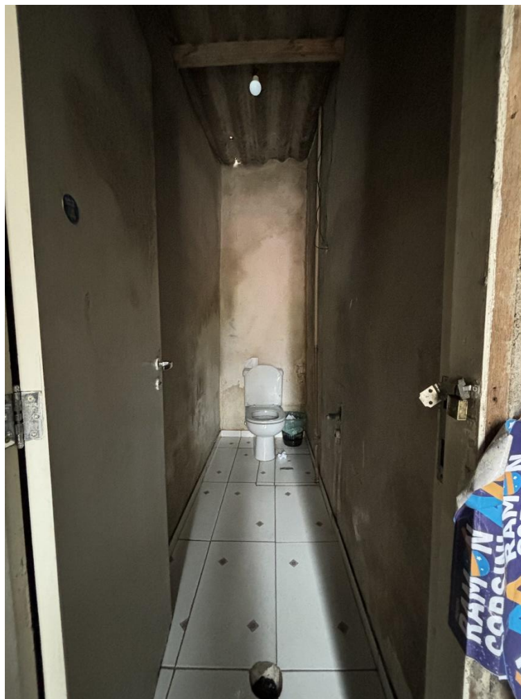
Foto nº. 5 – Vista do banheiro.
