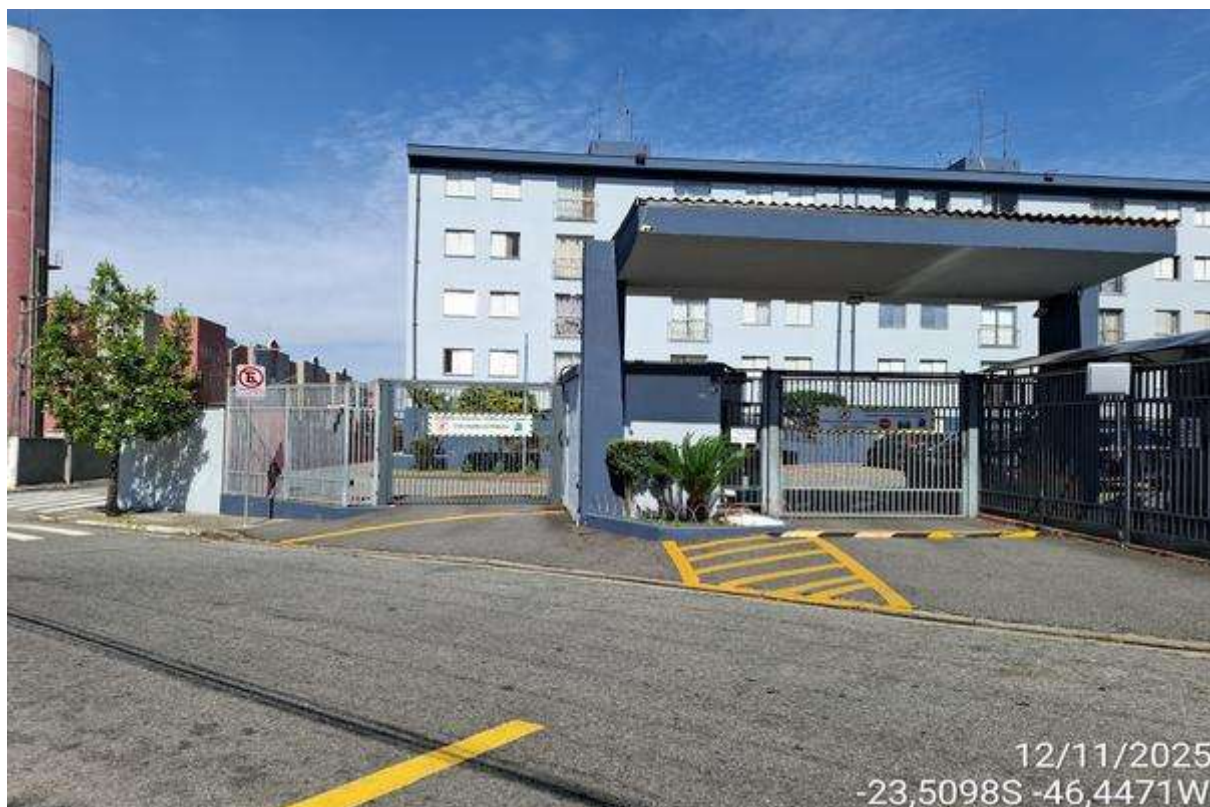
Foto 3: Vista da entrada e saída do condomínio
