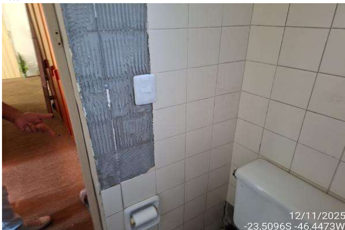
Foto 21: Vista do banheiro
