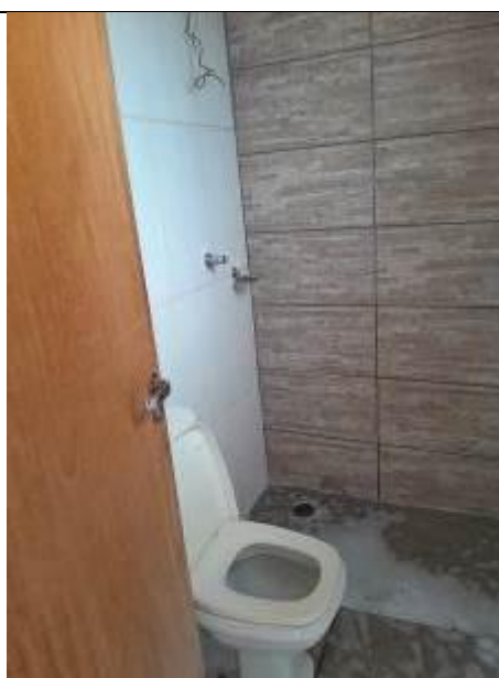
Vista do Sanitário
