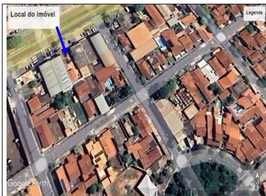
Vista parcial da Av. Eng. Necker Carvalho de Camargos nas proximidades do Imóvel
