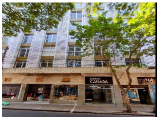
Fachada do prédio
