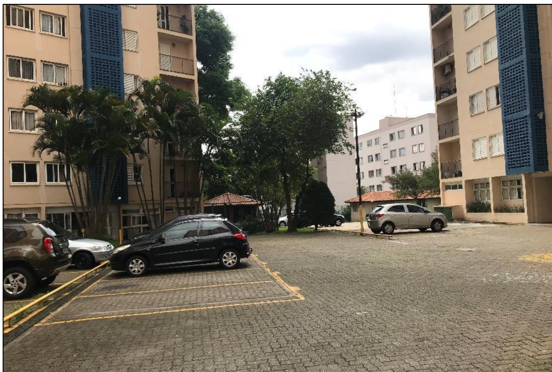
Foto 7 – Vista da área comum do Condomínio Residencial Parque Cidade de São Paulo, observando as vagas de garagem no térreo.
