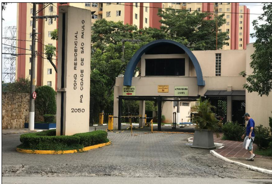
Foto 4 – Vista da portaria e acesso de pedestres do Condomínio Residencial Parque Cidade de São Paulo.
