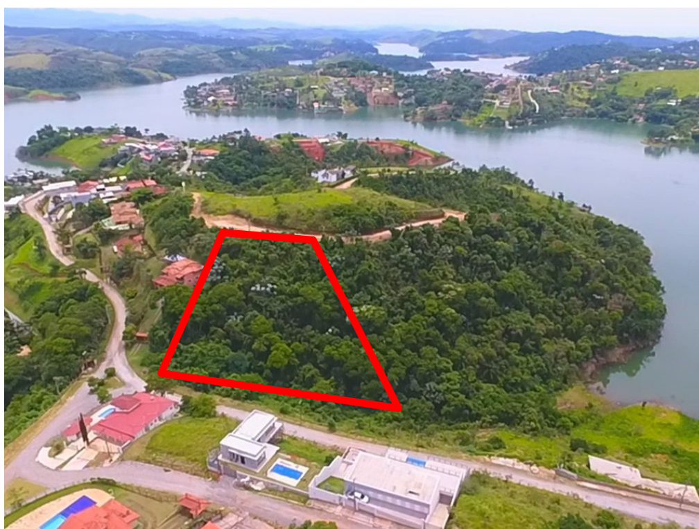
Fotografia 02 – Vista geral do Lote 147 do Condomínio Paraíso de Igaratá (em vermelho).
