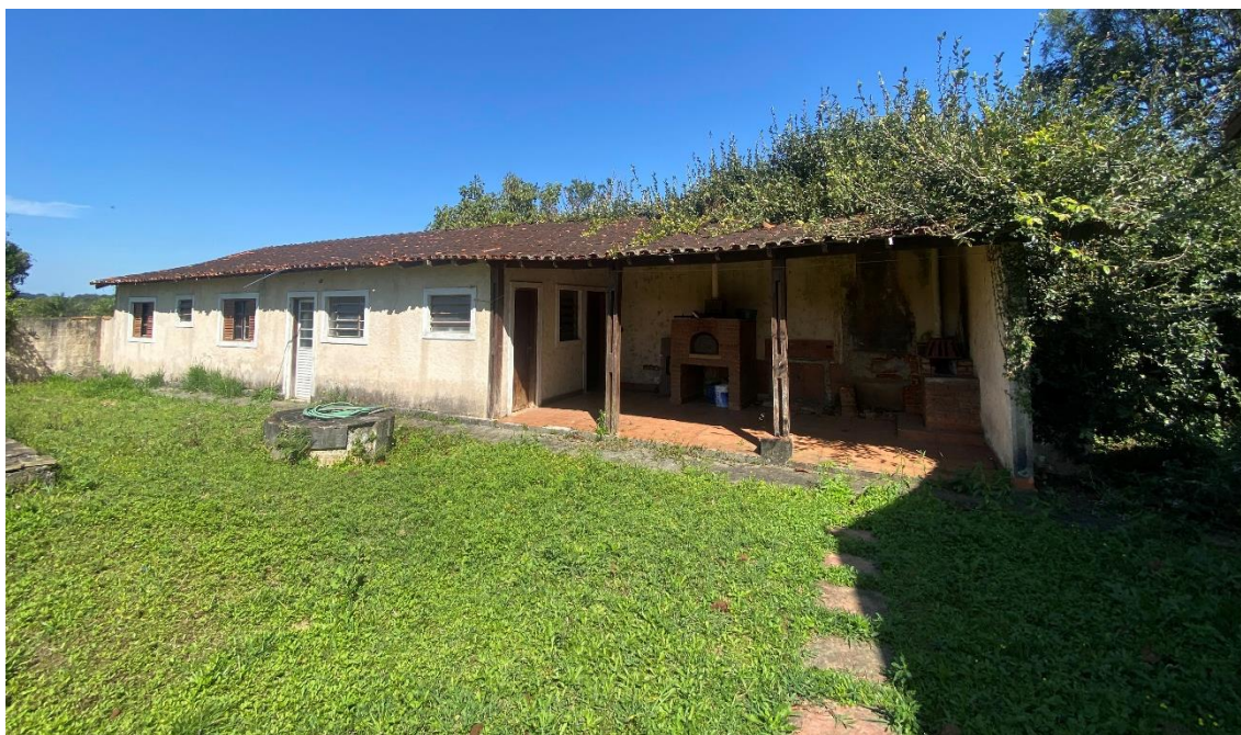
Imagens 33: Casa 02 – área externa
