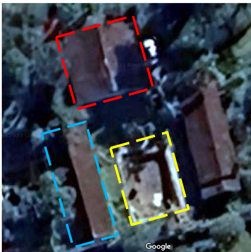
Imagem 04: Vista aérea do imóvel avaliando, com destaque para a casa 01 (cor vermelha), casa 02 (cor azul) e piscina (cor amarela) (fonte: Google Maps)
