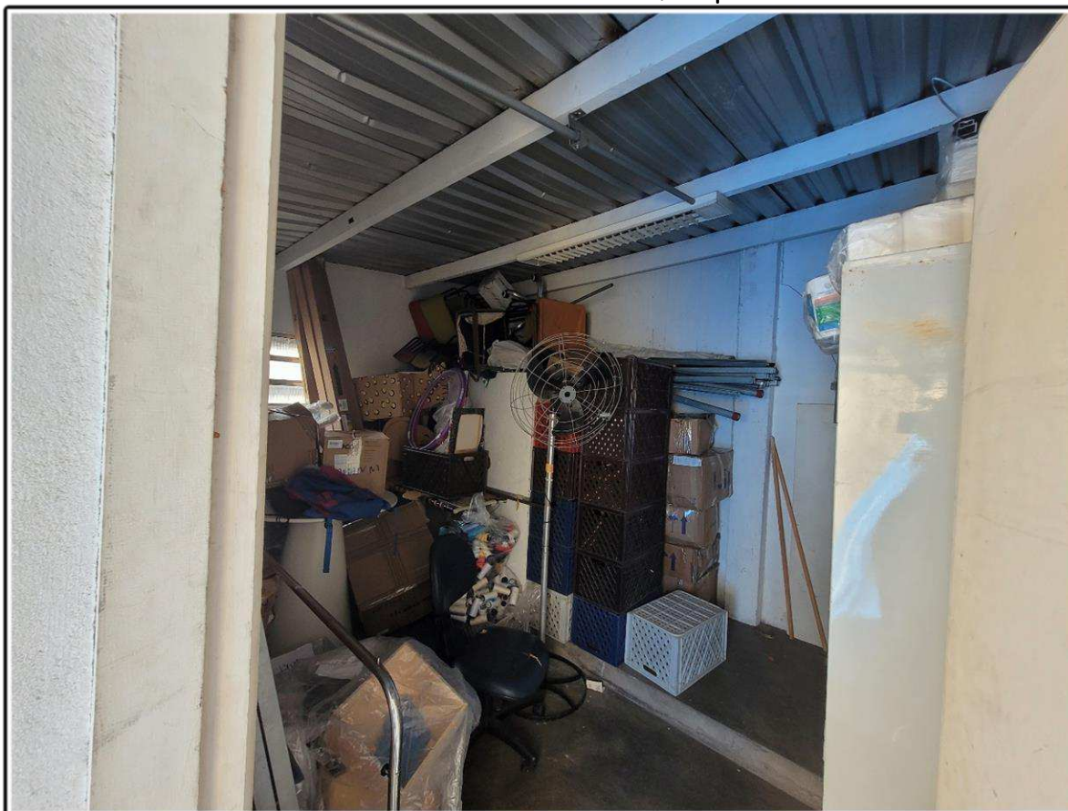
Foto 6 - Vista interna das benfeitorias, no pavimento térreo.
