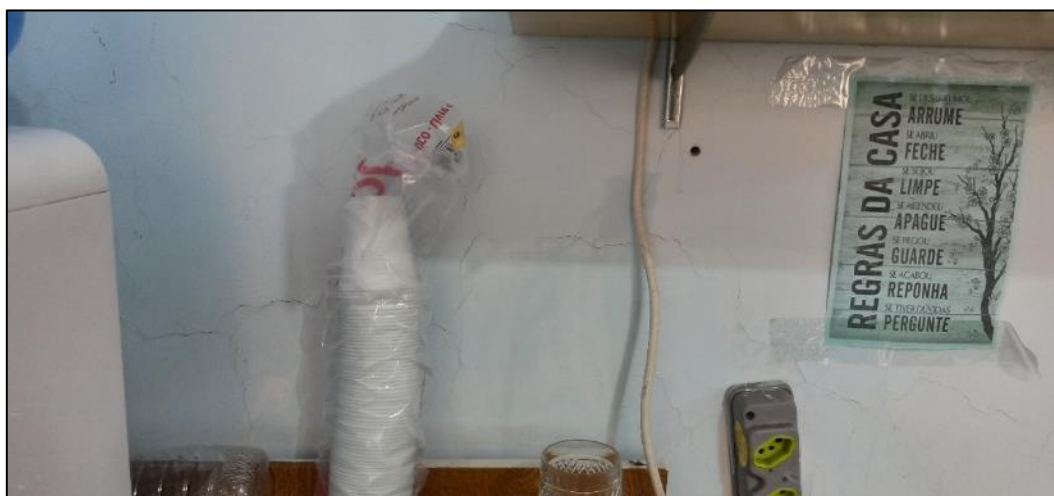
Foto 7. Fissuração na Sala 308
