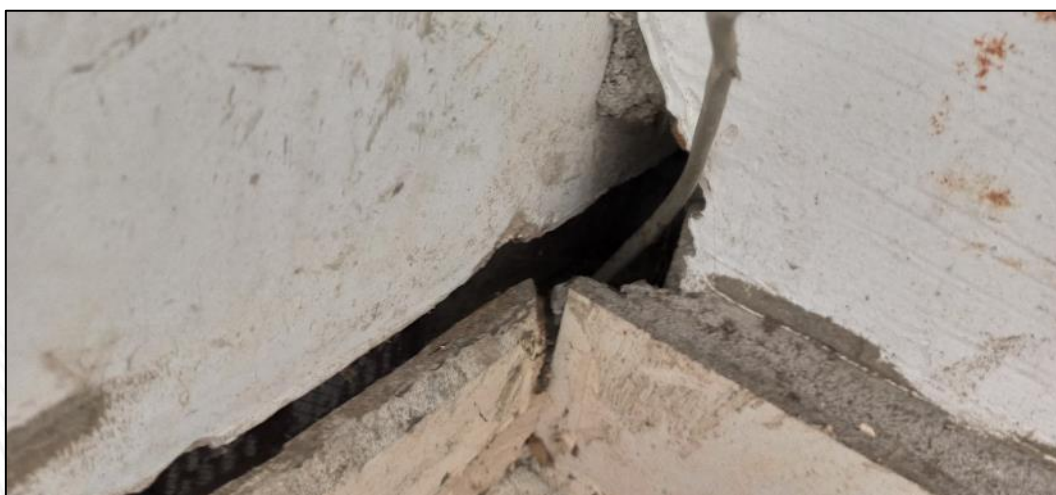
Foto 44. Detalhe da Sala 311
