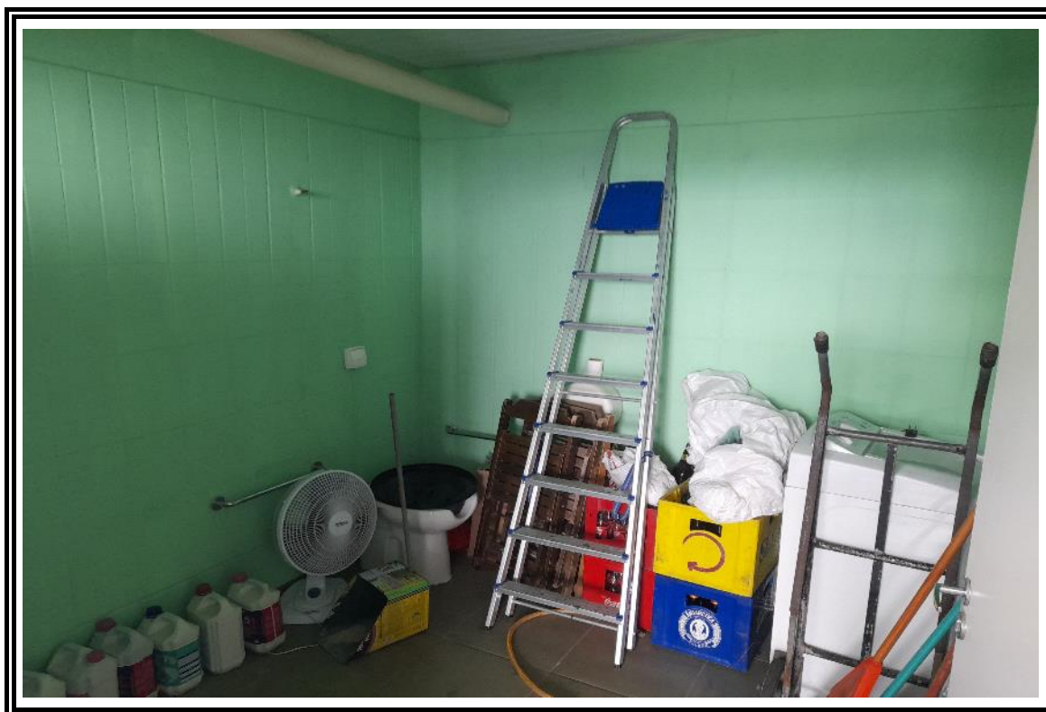
Foto nº 20: Vista do banheiro PNE
