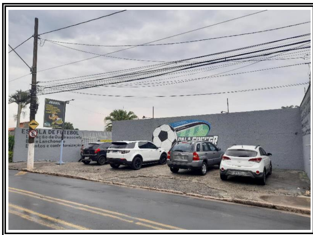
Foto n° 02: Outra vista geral (fachada) do imóvel avaliando
