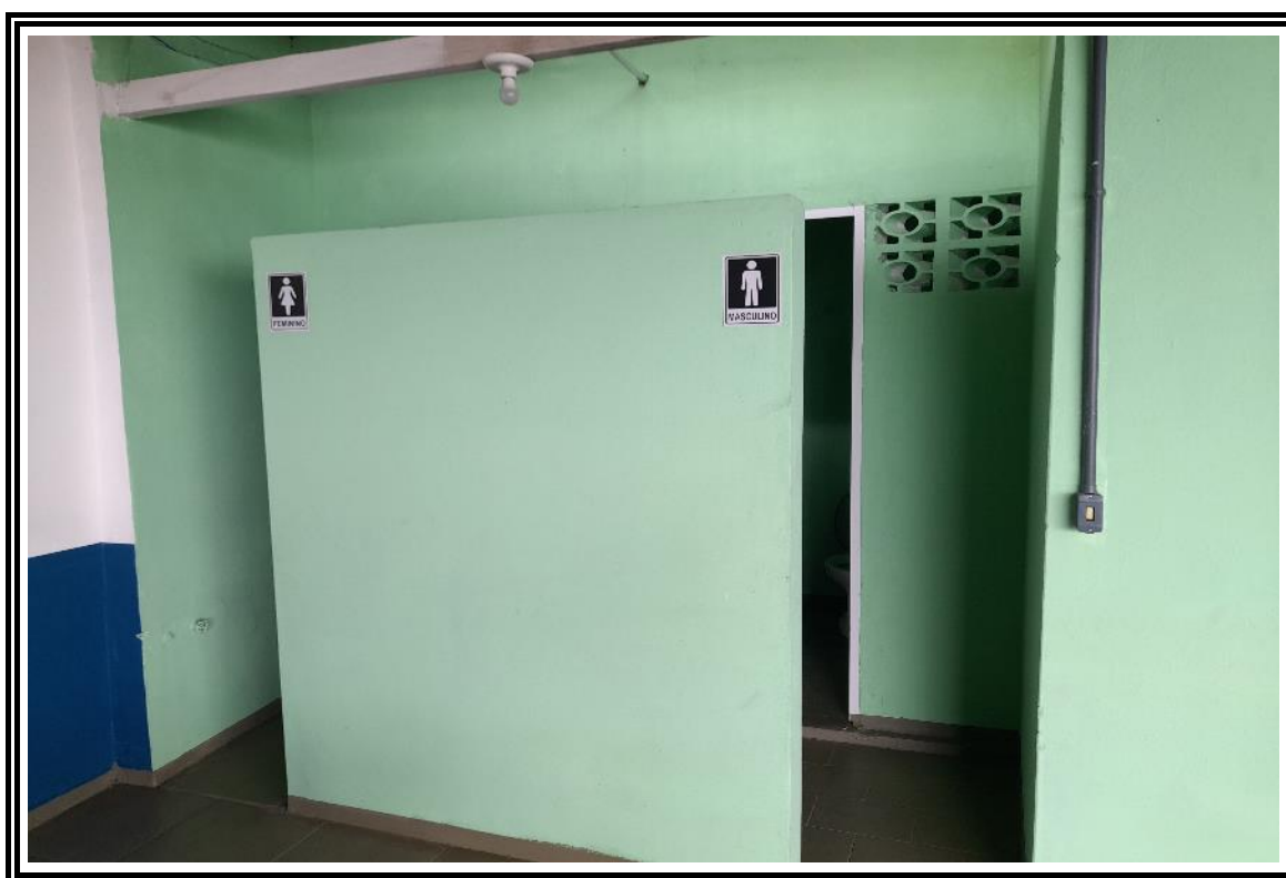
Foto nº 21: Vista geral dos banheiros
