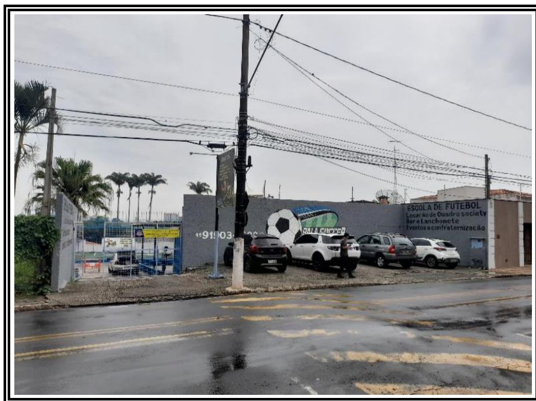
Foto nº 01: Vista geral (fachada) do imóvel avaliando
