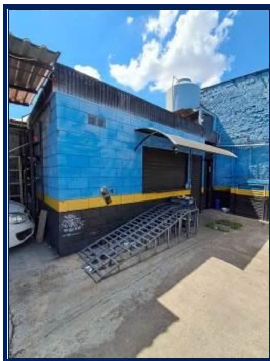
Depósito: Vista externa.
