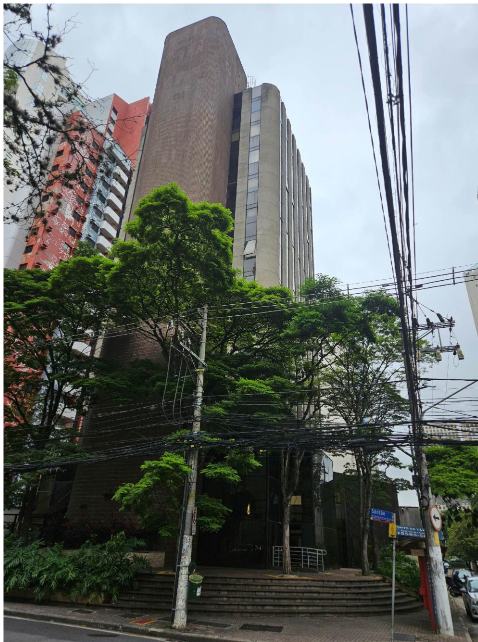
FOTO 10: FACHADA DO EDIFÍCIO PARA A RUA SANSÃO ALVES DOS SANTOS
