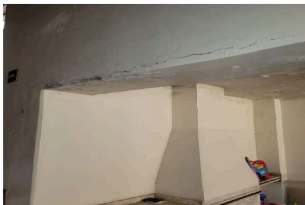
Foto 11- Vista da lareira e teto
