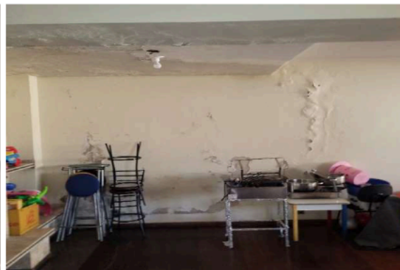
Foto 10- Vista da sala com a lareira
