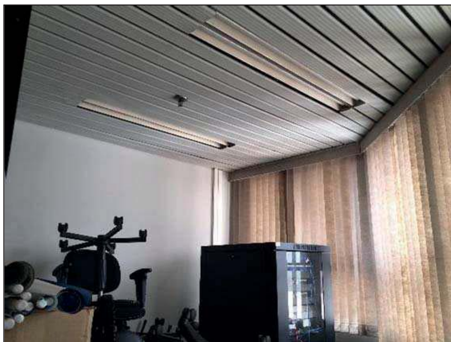
Foto 04. Detalhe da sala do imóvel avaliando.
