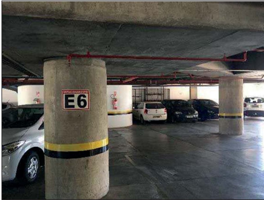
Foto 13. Detalhe da garagem do condomínio do imóvel avaliando.
