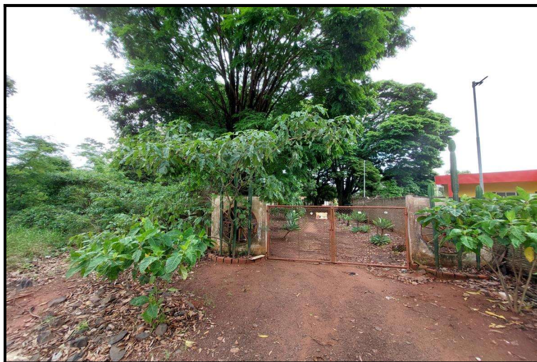
Figura 06: vista do acesso ao imóvel.
